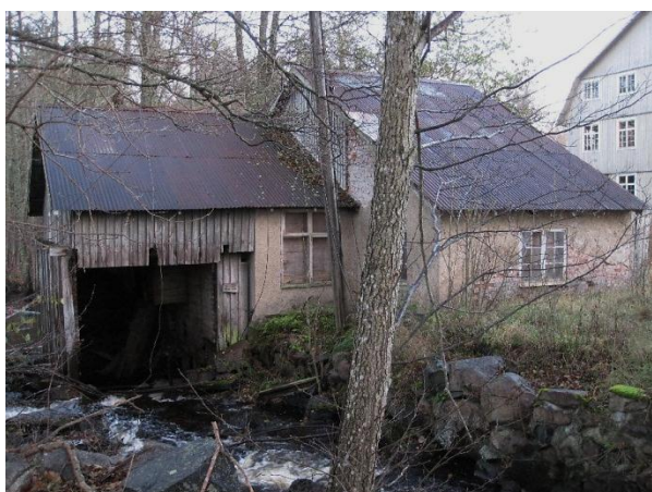
Det gamla kraftverket intill fabriken. T.h. kraftverkets ställverk som ännu används.
