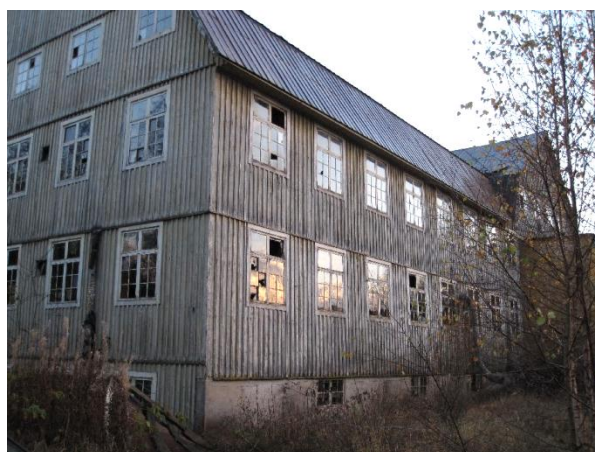
Den stora fabriksbyggnaden.
