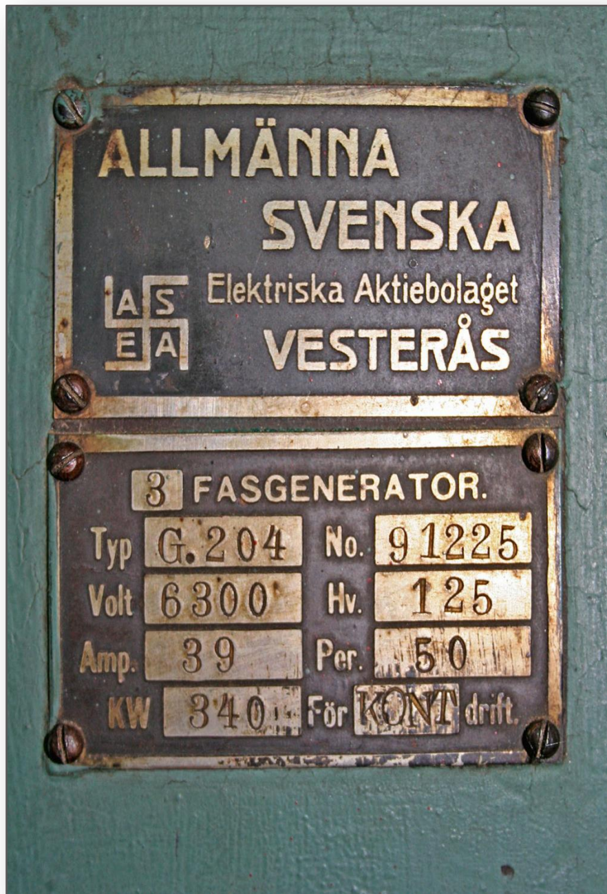
Märkplåt på generator i Karlshammars kraftverk. (Foto: Lotta Lamke)
