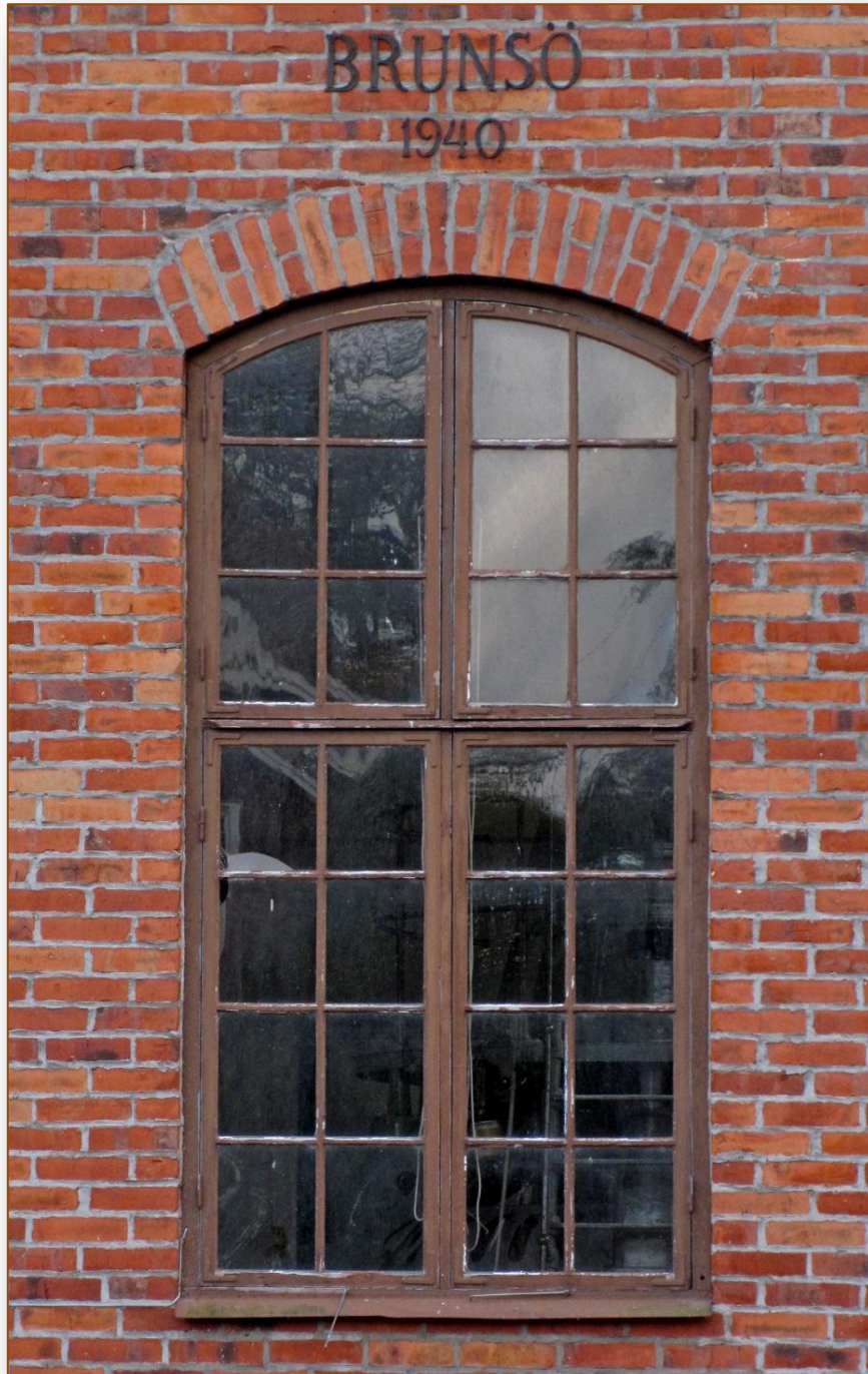
Brunnsö kraftstation. Kaplanhallen, uppförd år 1940. (Foto: Lotta Lamke)
