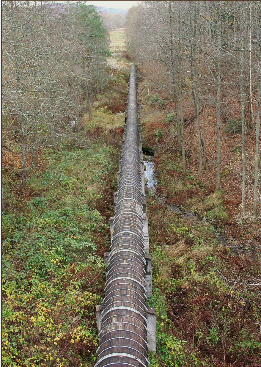
Intagstuben vid Melby kraftverk. (Foto: Lotta Lamke)
