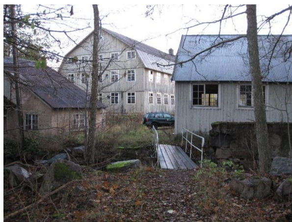
Sandslättsfabriken med den gamla kraftstationen t.v.
