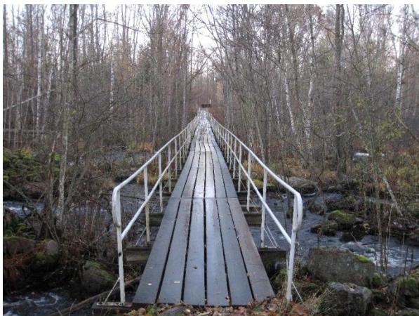
Spången som förbinder fabriken med kraftstationen.
