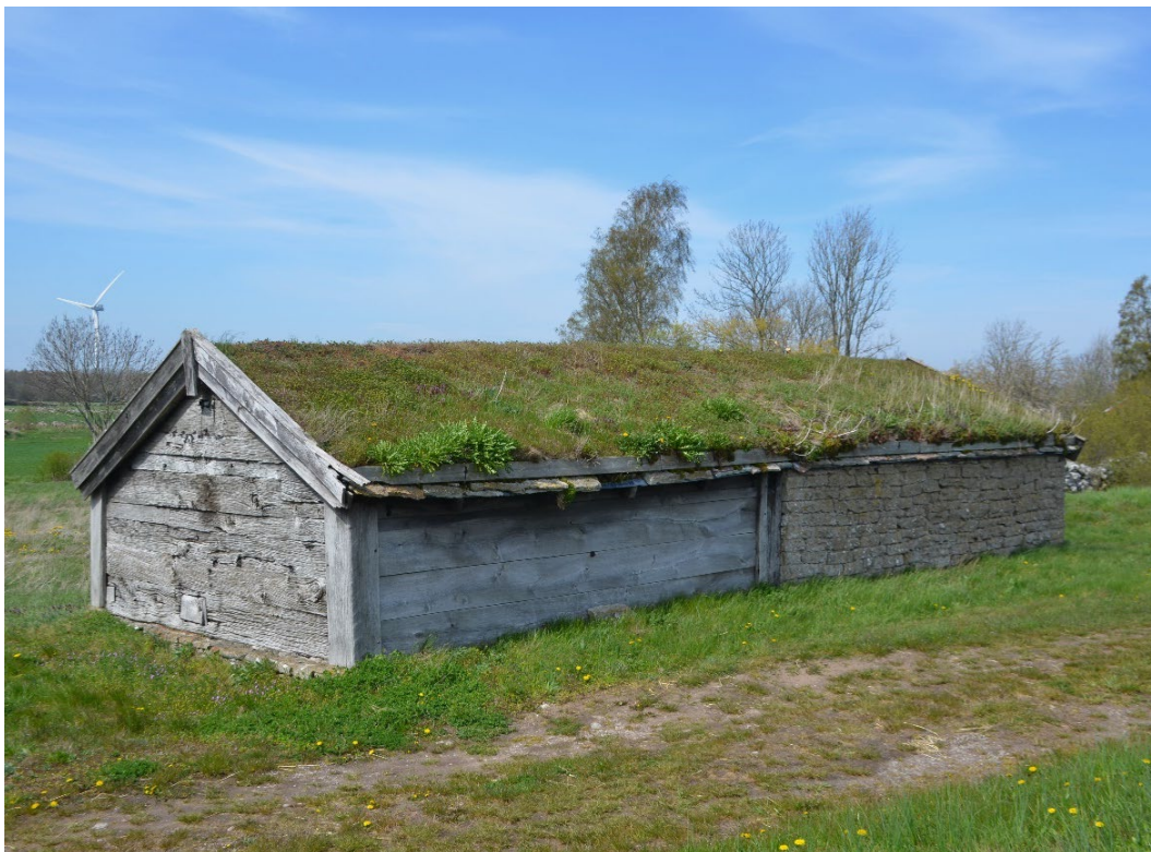
Ett av Mittlandets mest välhållna torvtak är taket på linbasta i Lerkaka i Runstens församling, Floran är genom växtbetingelserna helt olika på takets västra och östra sidor.
