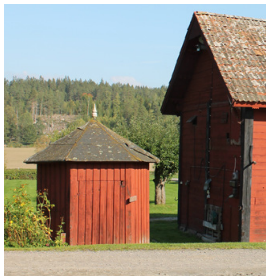
Det sexkantiga "hemlighuset" har fått en ny användning och är idag garage för gräsklipparen. Mulestad, Odensvi socken
