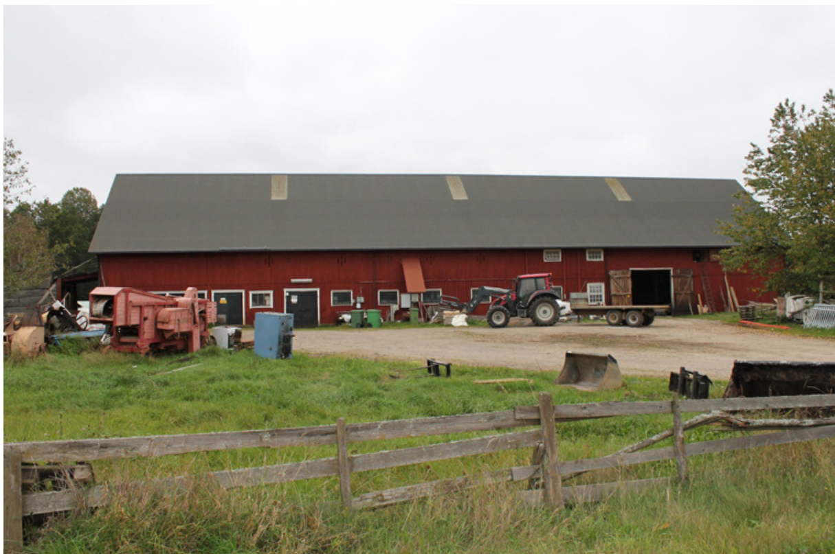
Denna ladugård från 1927 är representativ för de undersökta socknarna. De äldsta och yngsta ekonomibygnaderna är få jämfört med de "halvgamla" där verksamheten dock många gånger är i avtagande. Snårsfall, Odensvi socken
