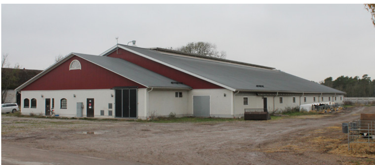
I väggarna används betong som i mitten av 1900-talet kom att avsluta den långa traditionen att använda kalksten som byggnadsmaterial. Denna lösdriftsladugård från 2012 rymmer 200 mjölkkor. Slagerstad, Stenåsa socken
