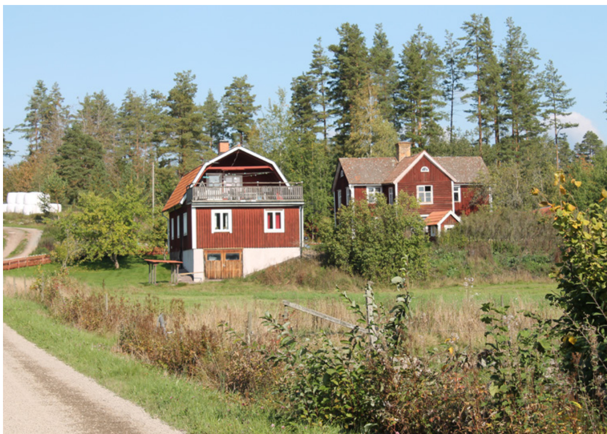
Det äldre bostadshuset, till höger i bild, är uppfört omkring 1860 och är idag en överloppsbyggnad. Det nuvarande bostadshuset som ligger strax intill är byggt 1915. Brånefall, Odensvi socken
