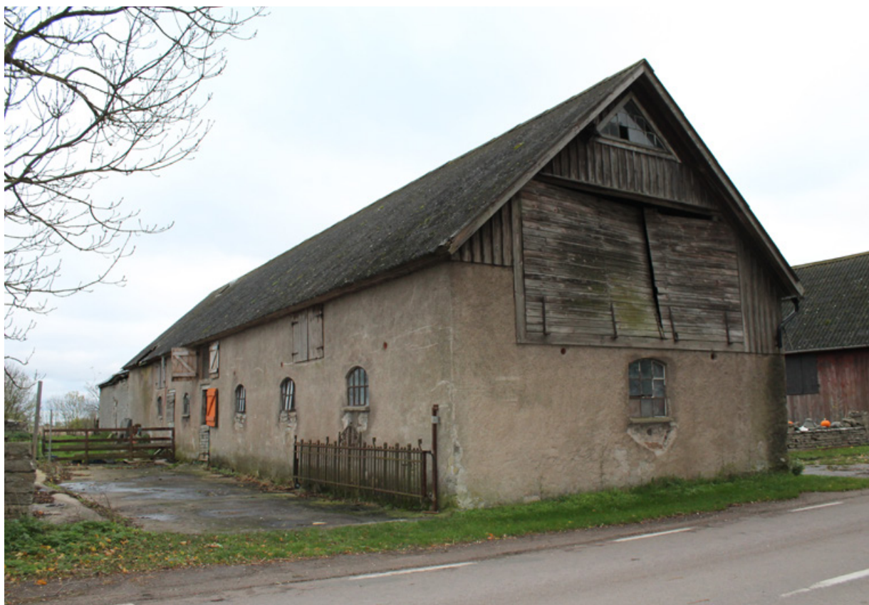
Det tidiga 1900-talets ladugårdar gavs högre väggliv och större bredd än sina föregångare. På södra Öland användes fortfarande kalksten som väggmaterial. Lilla Brunneby, Stenåsa socken
