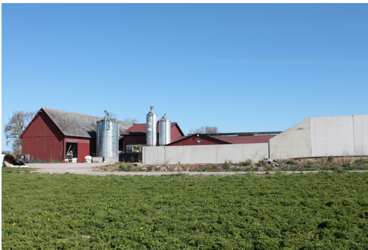
De stora djurbesättningarna fordrar vidlyftiga lagringsutrymmen för foder. På bilden ses exempel på såväl plan- som tornsilor. Norra Kvinneby, Stenåsa socken
