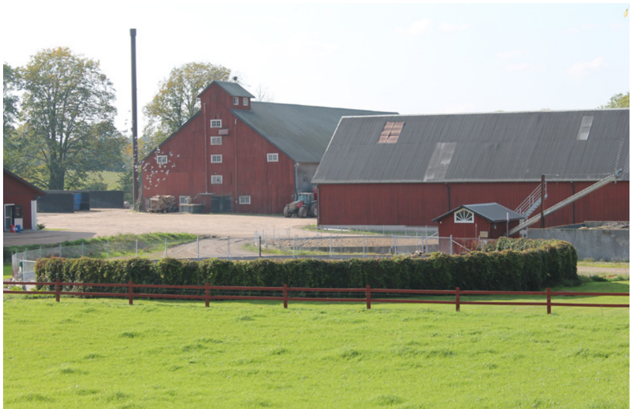
Gödselvårdsanläggningar är inte byggnader i egentlig mening men har tagits med vid inventeringen som husdjursbyggnad. Här har en häck planterats runt en del av anläggningen. Odensviholm, Odensvi socken
