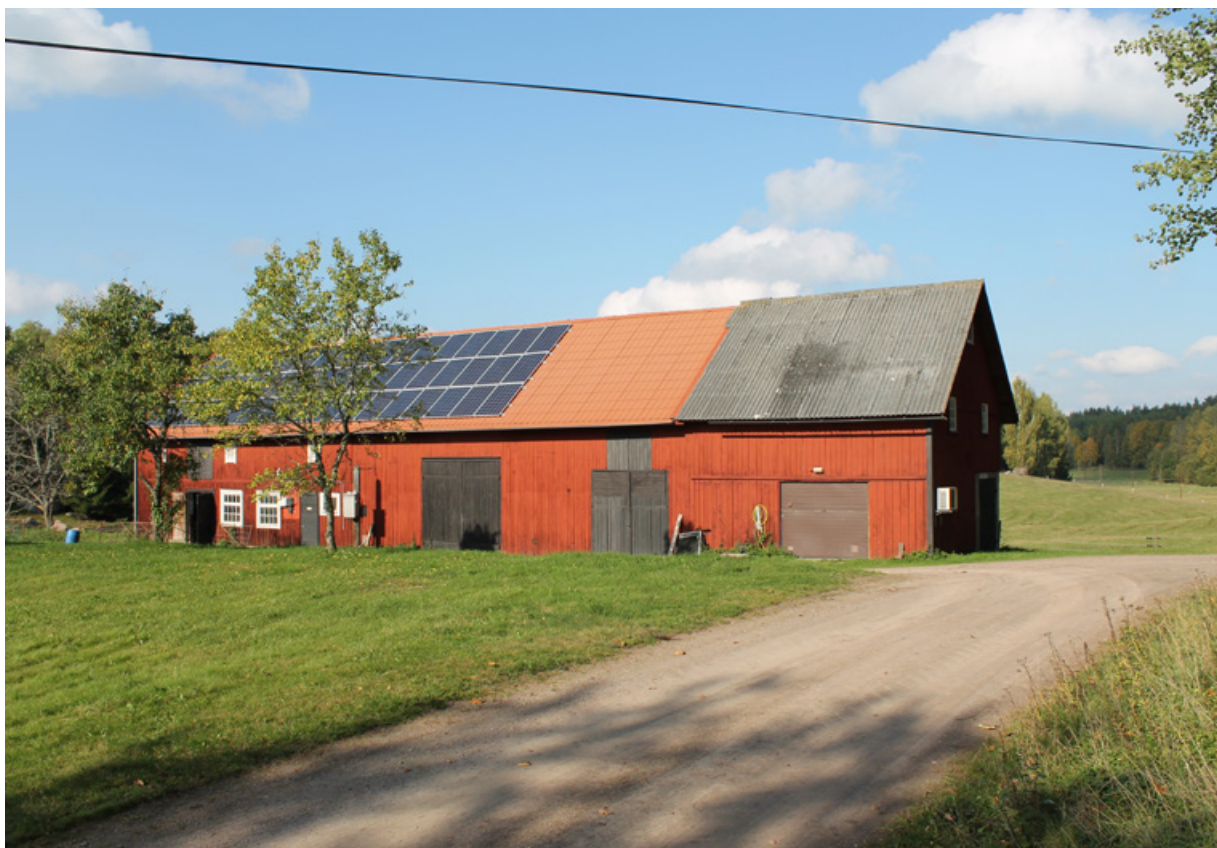
I det skogrika Odensvi byggdes hela ekonomibyggnaderna i trä även under andra halvan av 1900-talet. Denna byggnad har under senare tid försetts med solceller på taket. Katrineberg, Havet, Odensvi socken
