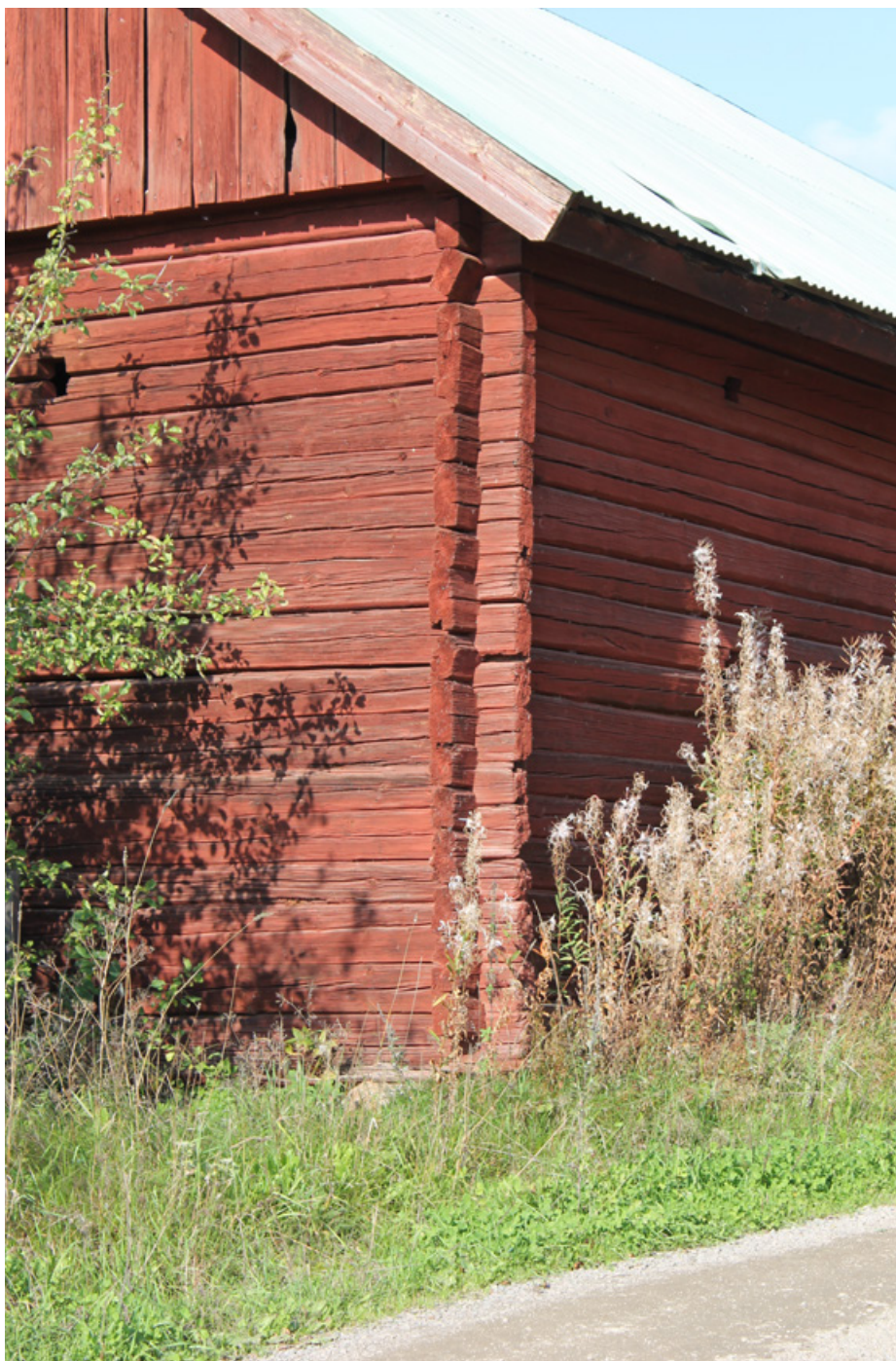
Knuttimring ger stabila stommar med lång livslängd. Brånefall, Odensvi socken
