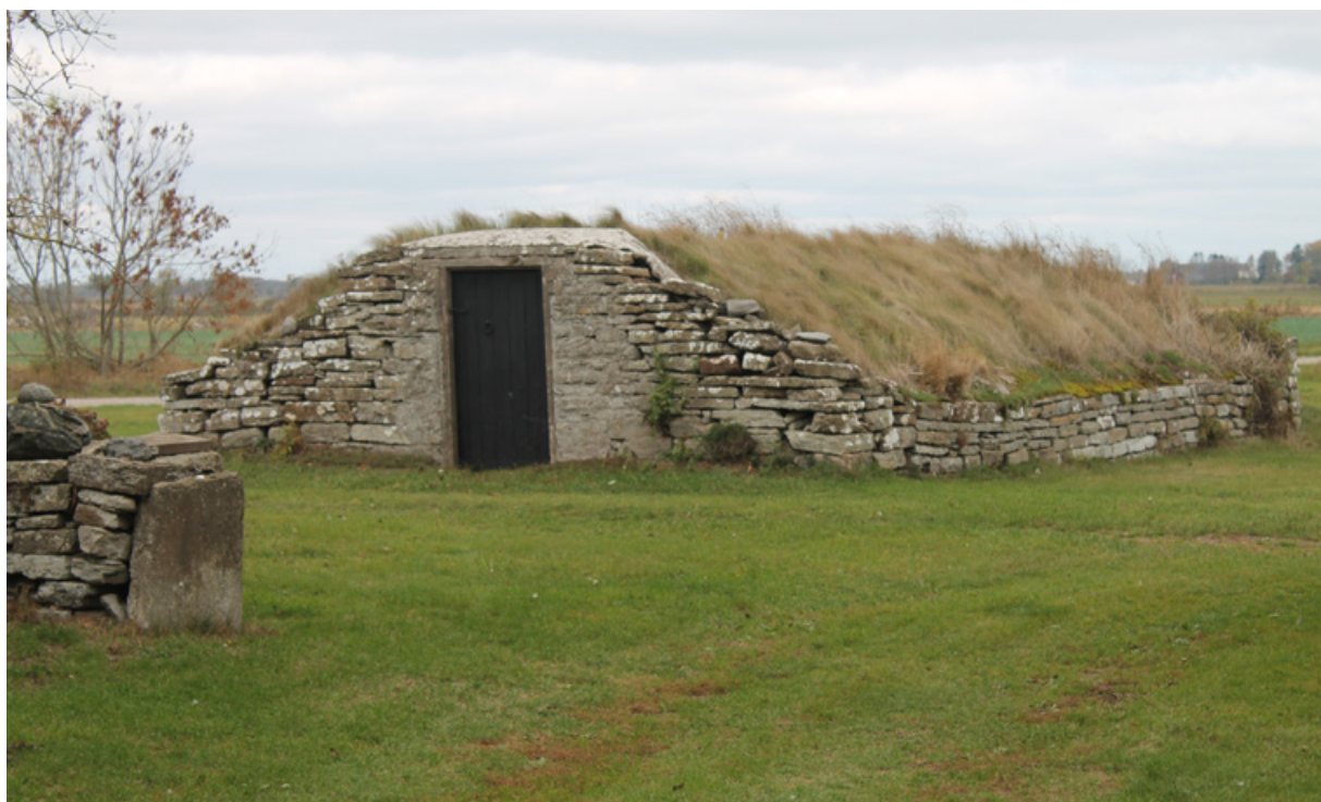
Den alltmer utökade odlingen av potatis under 1800-talet ledde till ett behov av svala, frostskyddade och mörka förvaringsutrymmen. Denna valvslagna stenkällare i kalksten från 1890 skulle kunna vara äldre än så men också yngre. Stenåsa by och socken
