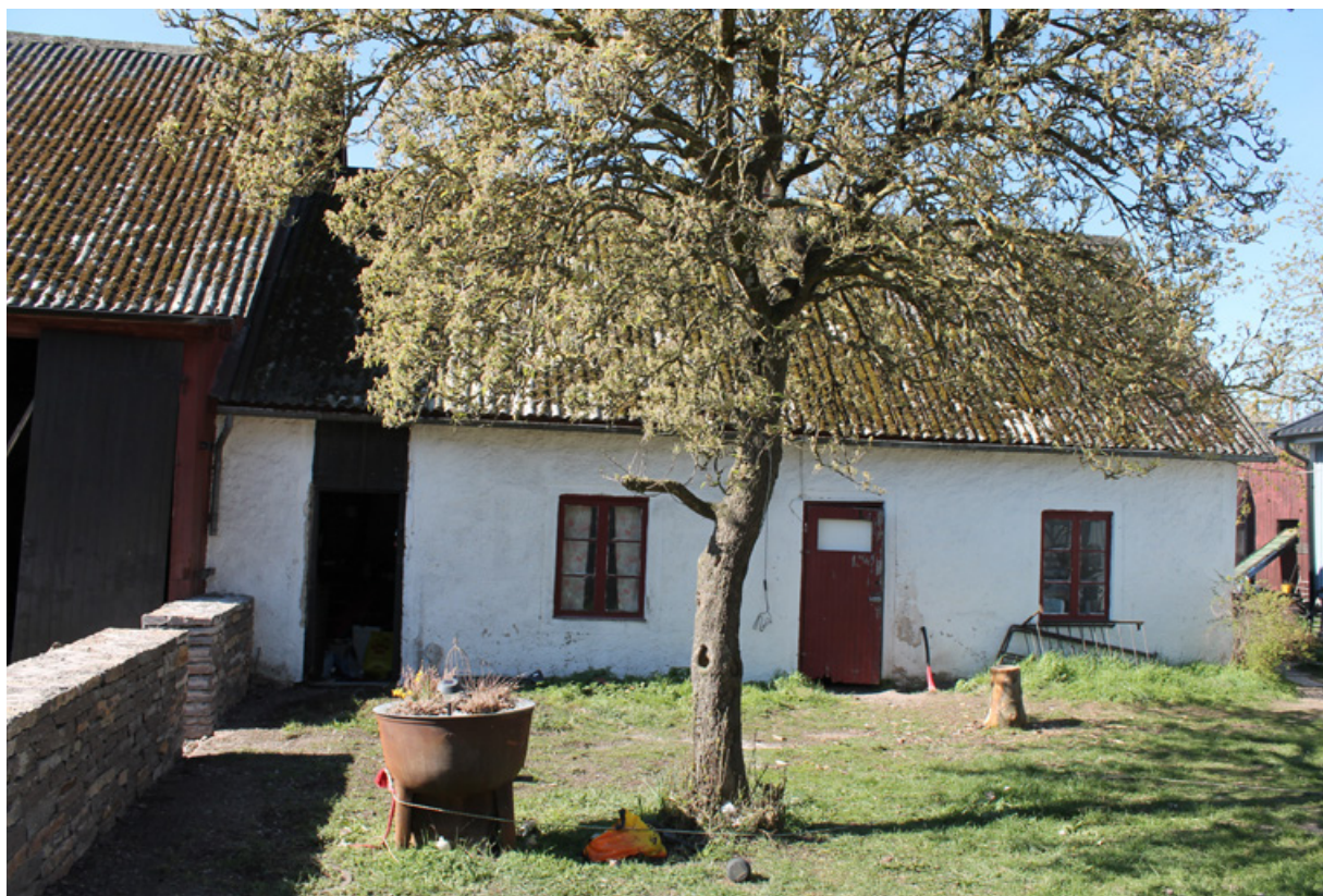
I Stenåsa är sidobyggnaderna ofta uppförda i kalksten och väl lämpade för sval förvaring av livsmedel. Slagerstad, Stenåsa socken
