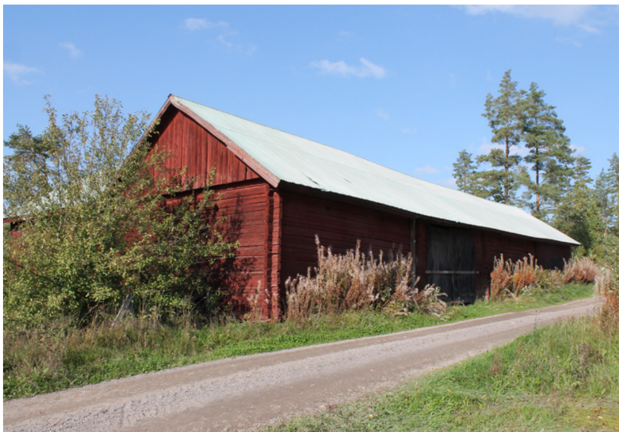
Knuttimringstekniken tar mest virke i anspråk av de olika träbyggnadsteknikerna och har dominerat i hela Sverige. Brånefall, Odensvi socken
