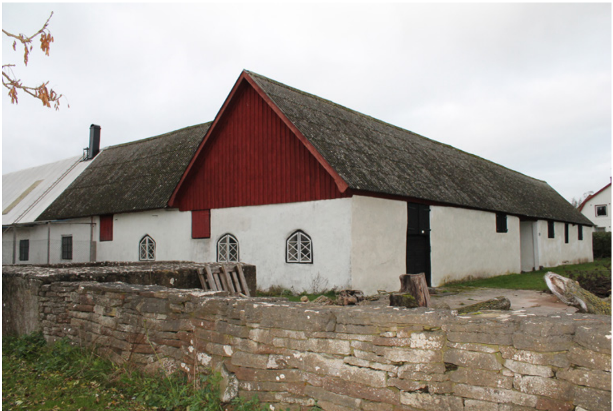
Som ofta på Öland har byggnadernas olika funktioner lagts under ett sammanhängande tak. I detta fall finns funktionerna brygghus, stall, ladugård och lada representerade. Stenåsa by och socken
