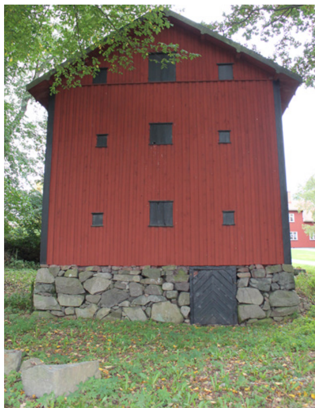
Sockeln i granitblock av olika storlekar ger ett livfullt uttryck. Ogestad, Odensvi socken
