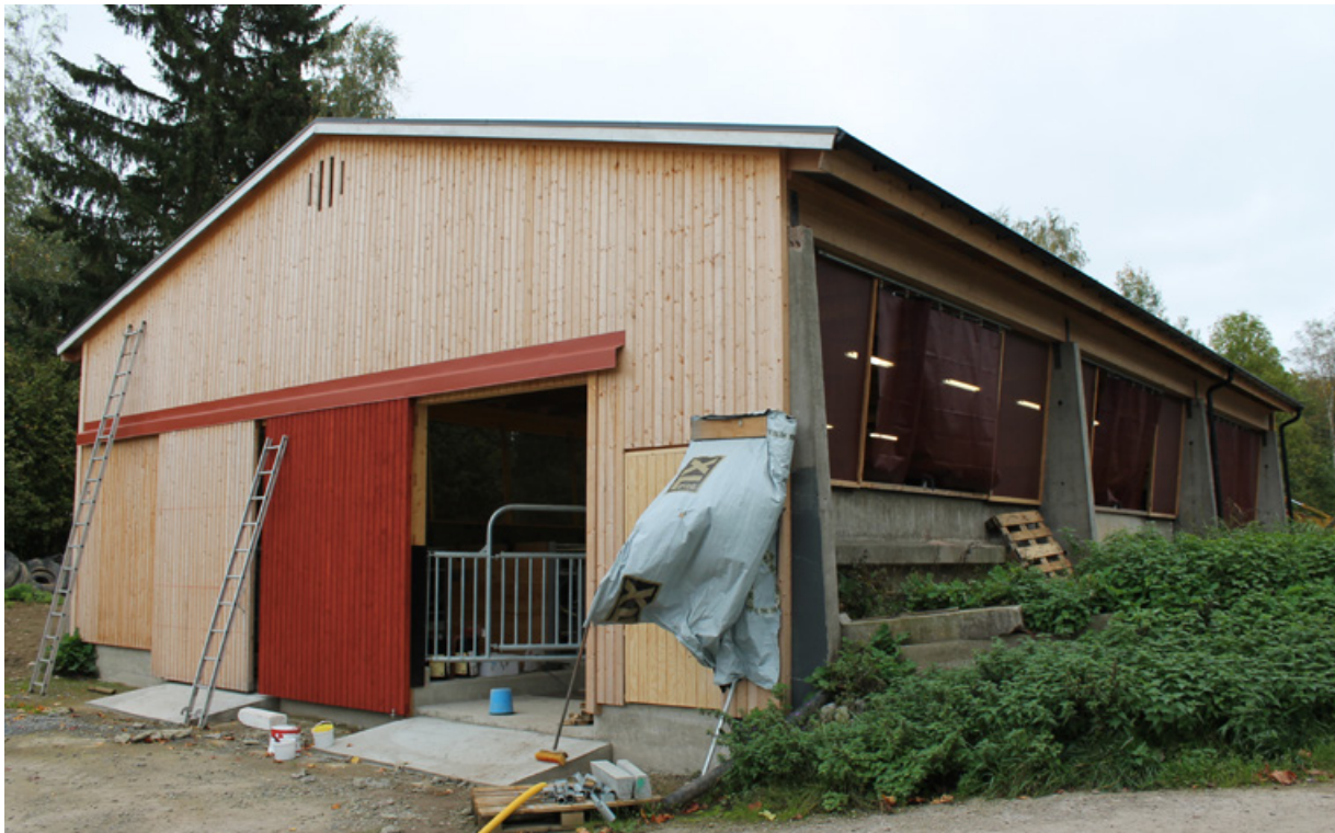
En plansilo ligger till grund för denna lösdriftshall för köttjur som är under uppförande. Ekhult, Gällerstorp, Odensvi socken
