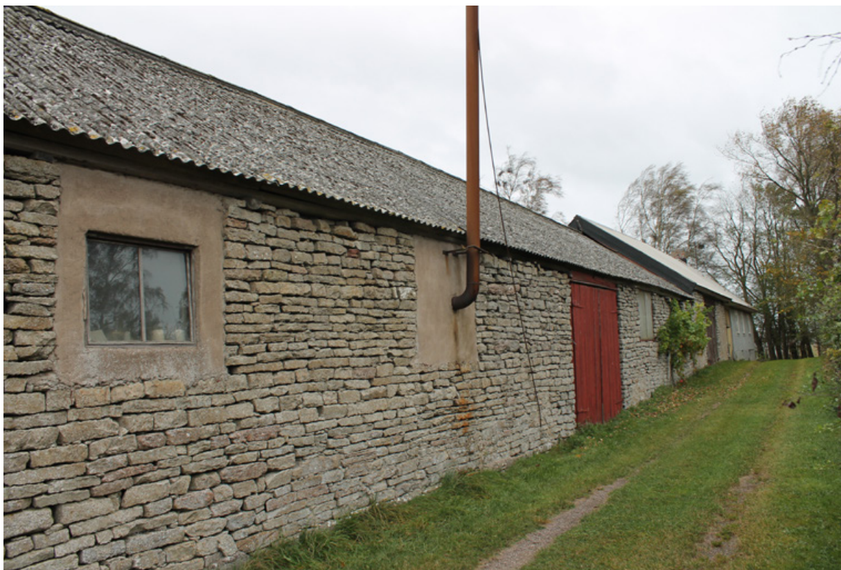
Kalkstenen dominerade under 1000-tals år som material i ekonomibyggnaderna. Inte förrän i sen tid konkurreras den ut. Denna byggnad är uppförd som loge men används idag som ankbod och mottagningsstall. Stora Brunneby, Stenåsa socken.
