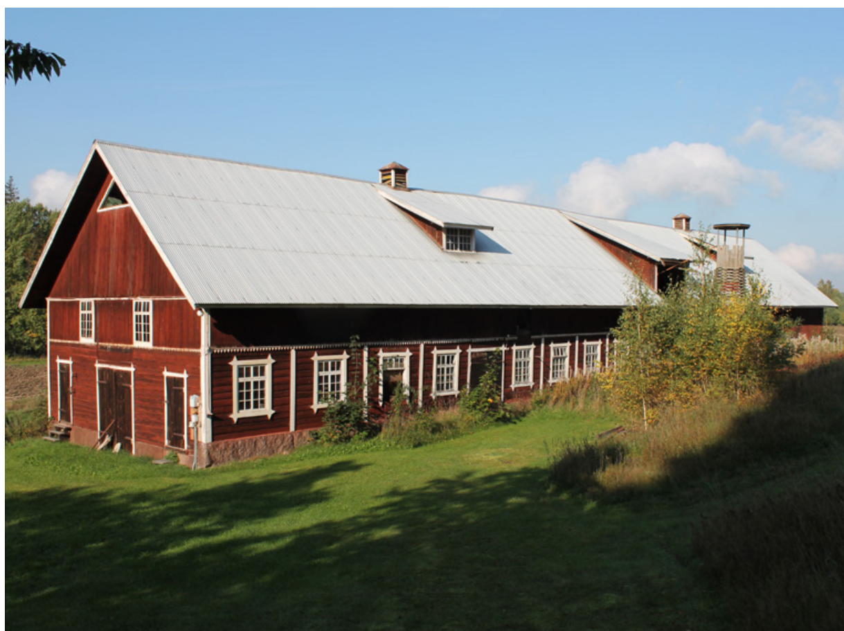
I det skogrika norra länet användes timmerväggskonstruktionen. Måtten är som synes lika det öländska exemplet nedan. Sandkullen, Skälhem, Odensvi socken
