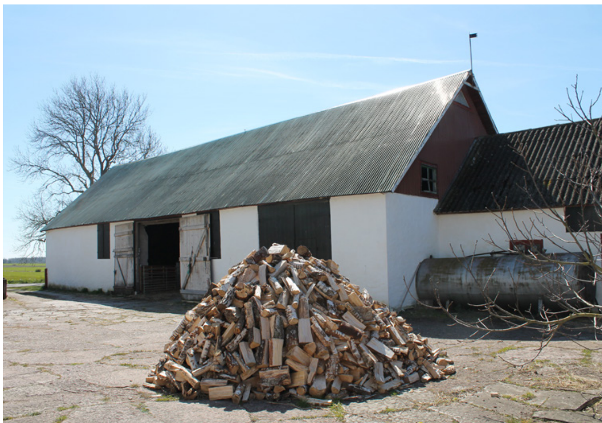
I Stenåsa, rikt på kalksten, fick en byggnad med samma användning som byggnaden på bilden ovan, detta utseende. Denna lada har i sen tid omvandlats till fårhus. Södra Kvinneby, Stenåsa
