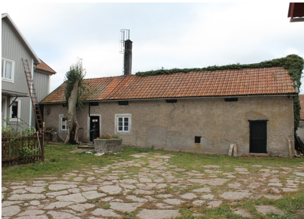
Denna sidobyggnads äldsta del, till vänster i bild, är från 1800-talet och förlängdes under 1920-talet. Byggnaden användes tidigare som sommarkök men är idag värmecentral och förråd. Fröslanda, Stenåsa socken
