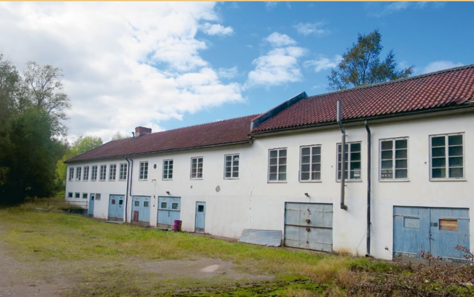
Sliperiet, degelkammaren, garage och tvättstuga.
