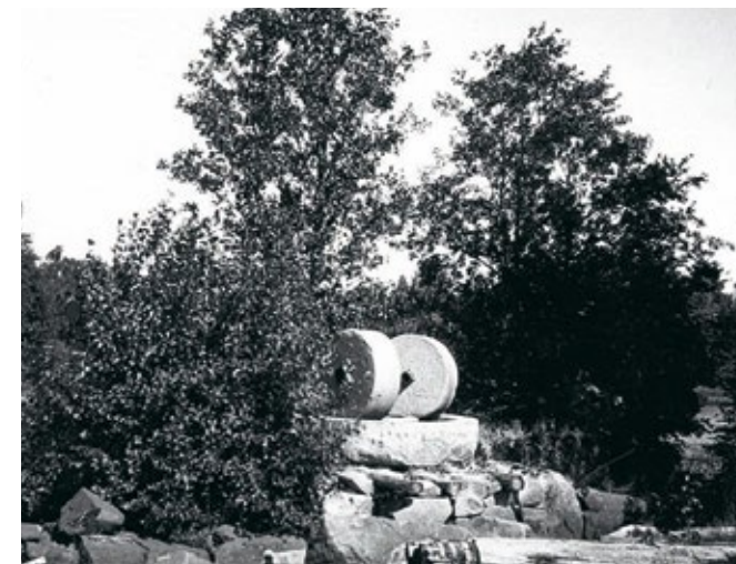
Den gamla kollergången eller krossen som användes för att krossa kisel (kvarts) och deglar vid det första glasbruket som låg här. Idag ligger den kvar under vattnet i dammen.
