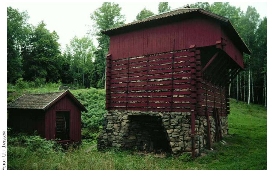
Figur 49. Trehörnings masugn vid Mariedamm är en multimerhytta, en av de få kvarvarande i Sverige.
