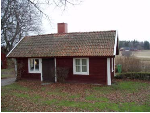
Gott skick: helt tak, fullt funktionsduglig, inget att anmärka på utom möjligtvis bristfälligt ytskikt (färg). (Ovan från vänster: Dömmesta 2:4, Fänninge 1:9)
