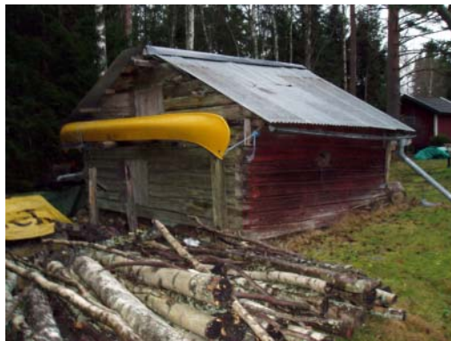
Ganska gott skick: fullt funktionsduglig men skulle behöva en smula omsorg, angripen fasad, väggar börjat sjunka, en och annan takpanna saknas. (Ovan från vänster: Vintermossen 1:20, Vintermossen 1:20, Vintermossen 1:15)
