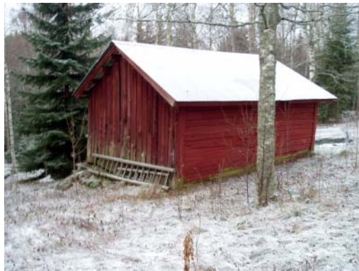
Gott skick: helt tak, fullt funktionsduglig, inget att anmärka på utom möjligtvis bristfälligt ytskikt (färg). (Ovan från vänster: Dömmesta 2:4, Fänninge 1:9)
