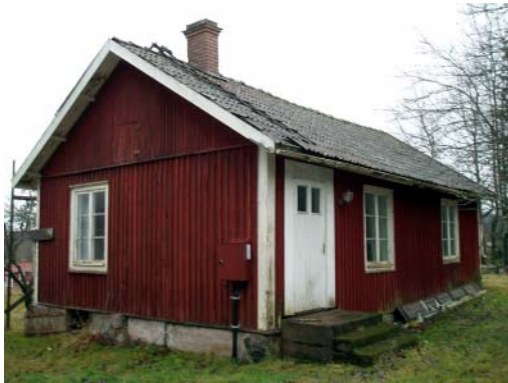
Ganska gott skick: fullt funktionsduglig men skulle behöva en smula omsorg, angripen fasad, väggar börjat sjunka, en och annan takpanna saknas. (Ovan från vänster: Vintermossen 1:20, Vintermossen 1:20, Vintermossen 1:15)
