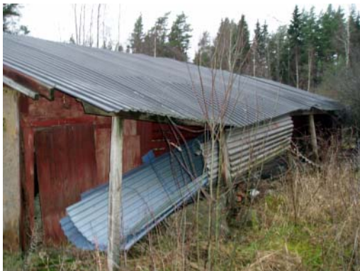
Ganska gott skick: fullt funktionsduglig men skulle behöva en smula omsorg, angripen fasad, väggar börjat sjunka, en och annan takpanna saknas. (Ovan från vänster: Vintermossen 1:20, Vintermossen 1:20, Vintermossen 1:15)
