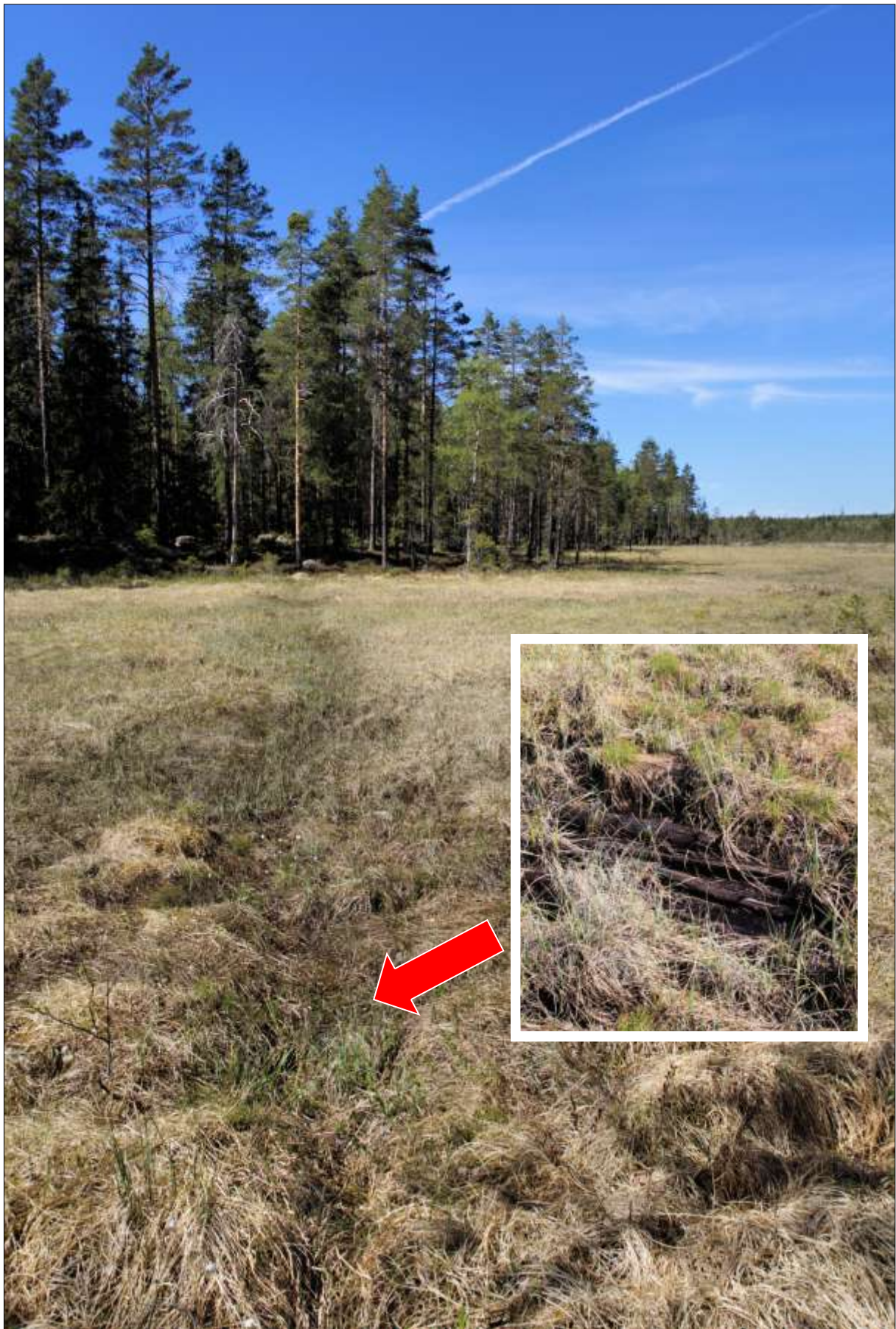
12. Kavelbro byggd av klena senvuxna granstammar i Karvalaksmossens sydöstra lagg.
