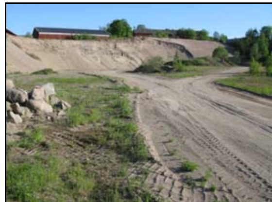
Figur 42. Gelleråstäckten är en större anläggning med betongfabrik, omlastning och förvaring av fraktioner.
