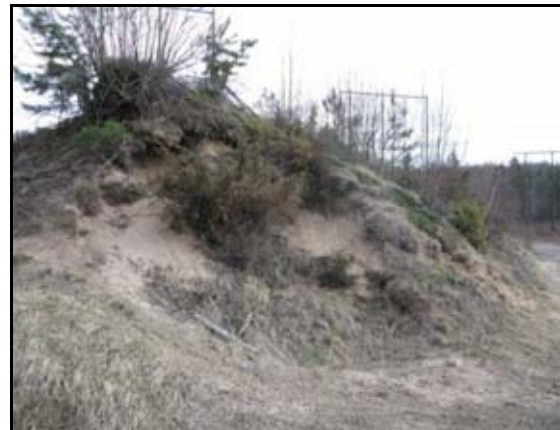
Figur 36. Hälleforsdynen. Sydvänd vägslänt i områdets södra del.
