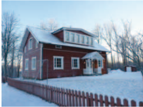
Figur 111. Skankeruds skola har förvandlats till bostadsbus. Fasaden har tilläggsisolerats och fönstren bytts ut.
