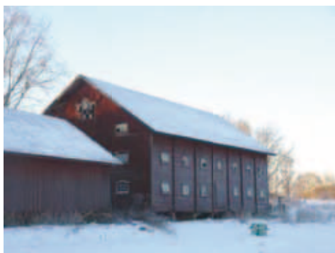
Figur 51. Magasinsbyggnad vid Bärsta gård.
