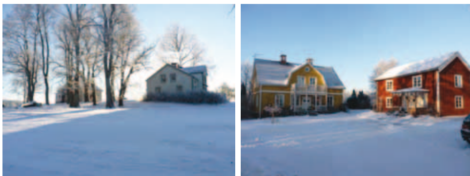
Figur 30. Mangårdsbyggnad på Nalaviberg med en kvadratisk putsad flygel med tälttak från 1700-talet i bakgrunden. Mangårdsbyggnaden är tilläggsisolerad samt har fått nya fönster och ny fasad (se fig. 119).
