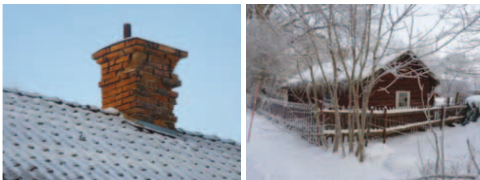
Figur 48. Skorsten med profilerat krön i Gippersta.
