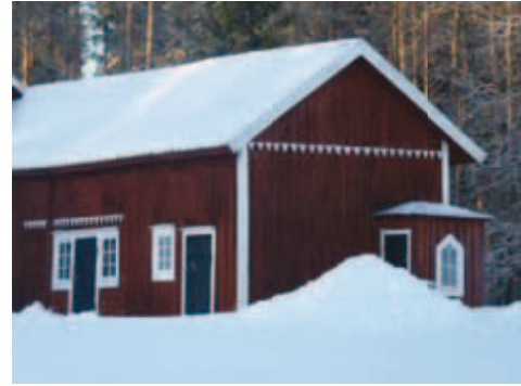
Figur 73. Detalj av byggnad i Herrgröyt. Den timrade byggnaden har endast gavelröset klätt med panel. I övrigt är timmerväggarna bara.
