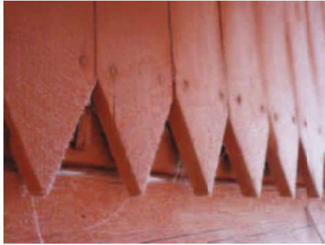
Figur 73. Detalj av byggnad i Herrgröyt. Den timrade byggnaden har endast gavelröset klätt med panel. I övrigt är timmerväggarna bara.
