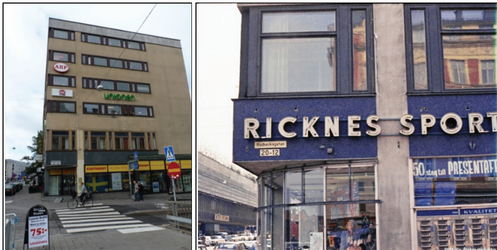
Figur 33. Modernismen är karakteristisk för Söder, men drabbas ibland av okända ingrepp. Ett exempel är hur den smäckra, tidigare lätt rundade profilen på skyltfönstret i hörnet Rudbecksgatan 20 har bytts ut mot ett nytt, snedställt standardparti.
