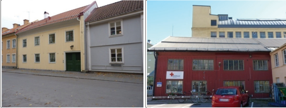
Figur 119. Flera trähus tycks ha återuppförts i centrum efter branden. Några är bevarade som här på Skolgatan (Det grå huset är emellertid flyttat inom kvarteret.)
