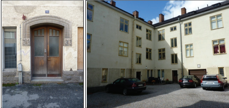
Figur 239. Jugendport med korbågig omfattning av natursten samt grund med natursten. Figur 240. Gårdsinteriör i kvarteret Grundläggaren. Fasaderna har ett enkelt uttryck in mot gården.
