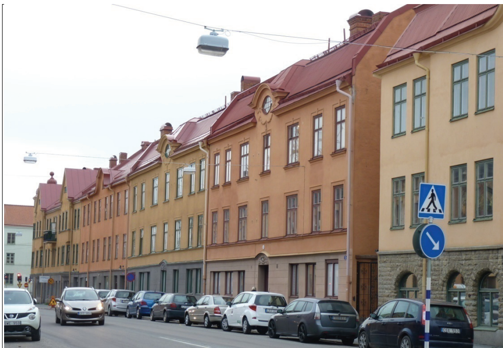
Figur 207. Landshövdingehus i jugendstil på Karlslundsgatan med typisk öppning in till gården mellan två brandgånar. Också taklandskapet, där takfoten bryts av takkupor med "oxögon", frontspiser och hörntorn, är typiskt för området. Jugendarkitekturen är emellertid betydligt mer återhållsam än inne i stadens mer centrala delar.
