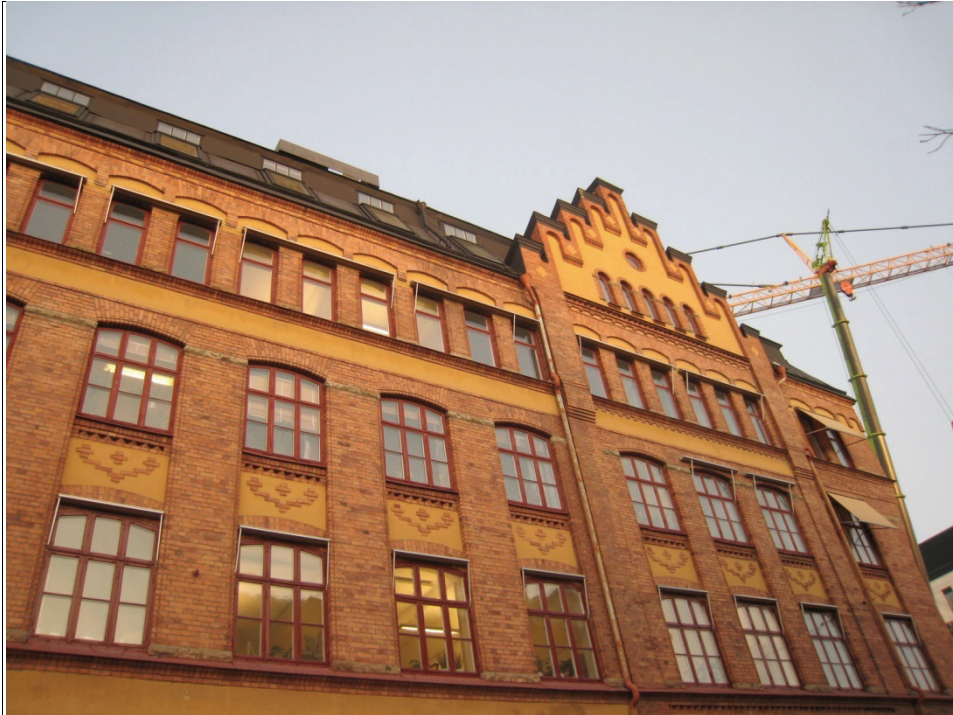
Figur 140. I korsningen Järnvägsgatan och Klostergatan ligger Örebro skofabrik. Fabriken grundades redan på 1890-talet men flyttade 1907 verksamheten till dessa fabrikslokaler på industriområdet på Norr.
