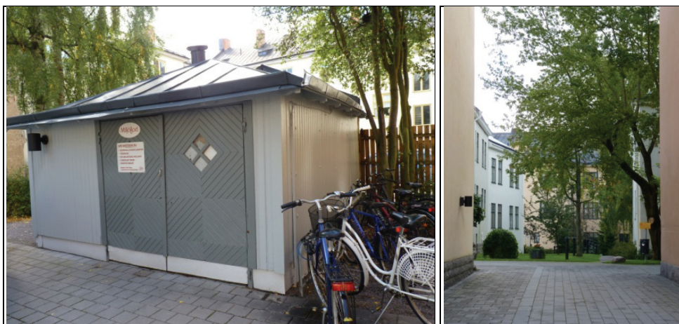
Figur 242. Gårdsbus som moderniserats men där takfotstassarna avslöjar att byggnaden är äldre. Figur 243. Gård kvarteret Grundläggaren med passage från gatan mellan två parallella brandgavlar.
