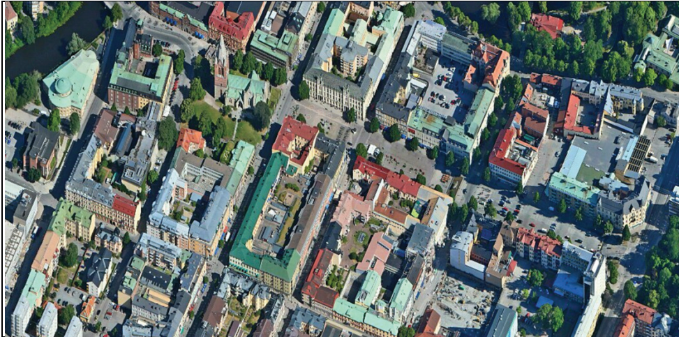
Figur 3. I den centrala delen av staden är bebyggelsen oftast ordnad i slutna kvarter som är orienterade efter den strikta rutnätsplanen. I många fall är också gårdarna exploaterade med gårdsbebyggelse. Rutnätsplanens långa siktlinjer har också till följd att antalet fondbyggnader är få. Strömparterren som ligger i änden av Kungsgatan och villa Choisie i änden av Olaigatan är enstaka exempel. Flygfoto: Eniro.
