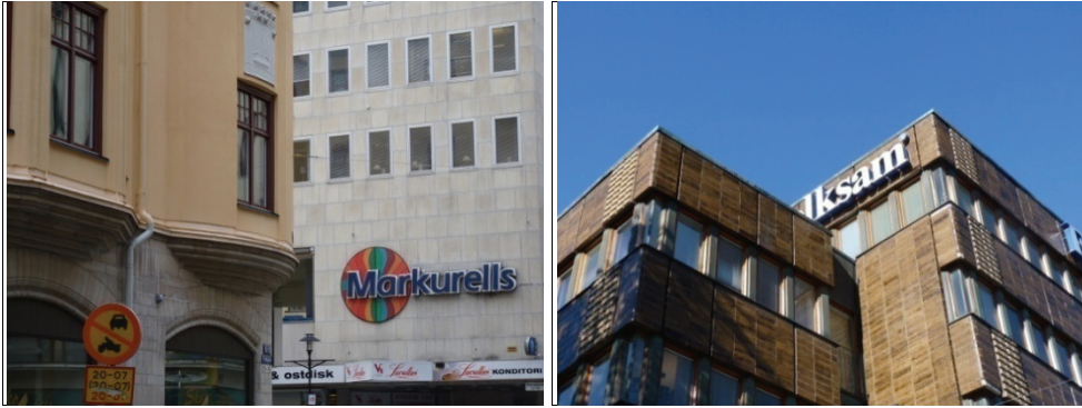
Figur 157. Då Markurellshuset, dåvarande EPA, uppfördes på Storgatan fanns det från politikernas sida en önskan om att det skulle skapa en balans mellan centrumets södra och norra delar.
