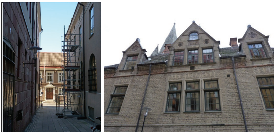
Figur 99. Färgaregatan är en av få gator som inte breddats efter branden. I fonden syns Elgérigården. Figur 100. Församlingshemmet med anor från medeltiden men vars nuvarande fasaduttryck härstammar från en renovering utförd i slutet av 1800-talet.
