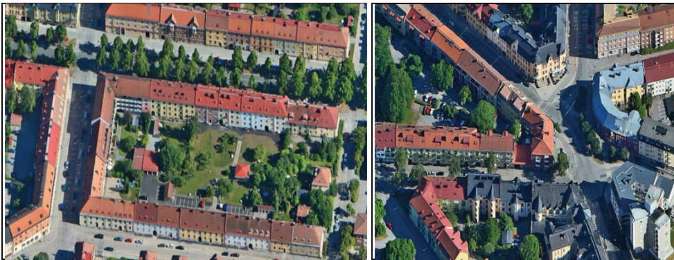
Figur 4. På Öster, som särskilt karakteriseras av 1920-tals klassicismen, dominerar den tidens storgårdar med grönskande innergårdar och begränsad gårdsbebyggelse. Kvarteren är många gånger inte helt slutna. Bebyggelsen ger ett homogent intryck, stilmässigt och volymmässigt. Samtidigt är byggnaderna ofta tydligt avgränsade samt individuellt utformade och färgsatta vilket ger en variation. Flygfoto: Eniro.
