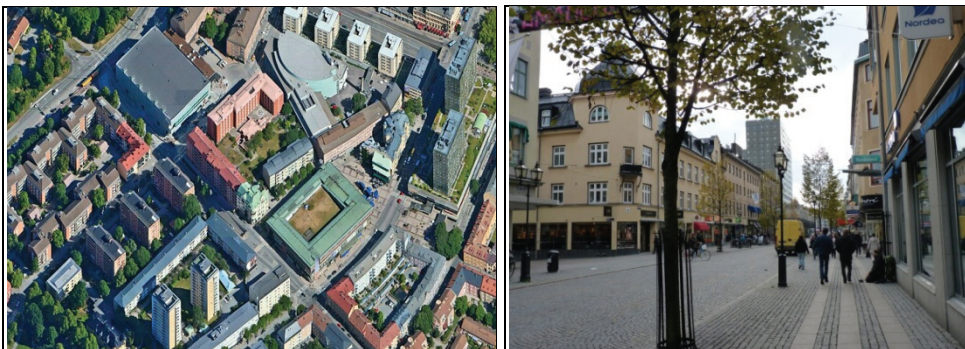
Figur 6. Söder har färre slutna kvarter och bebyggelsen är, i enlighet med modernistiska ideal, oftare fristående i form av lamellbus och skivbus. Byggnadshöjderna och volymer är också betydligt mer varierade än i resten av staden. Flygfoto: Eniro.
