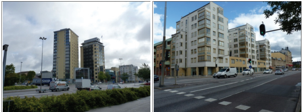
Figur 167. Nyuppförda punkthus utmed Rudbecksgatan.
