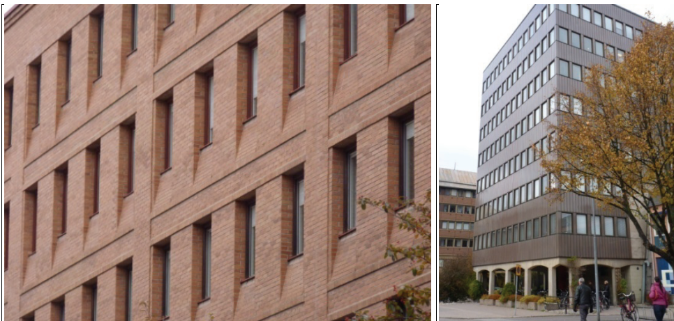
Figur 161. Modernistisk byggnad på Slottsgatan, vilken ersatte Örebro nya kvarn som tidigare stått på platsen. Möjligen kan den massiva murverkan i teglet och takfotens profilering vara ett försök att fånga upp några av den gamla kvarnens miljöskapande värden. Den är också ett exempel på hur annan verksamhet inne i stadens centrala delar under efterkrigstiden fick ge vika till förmån för kontors- och förvaltningsbyggnader.
