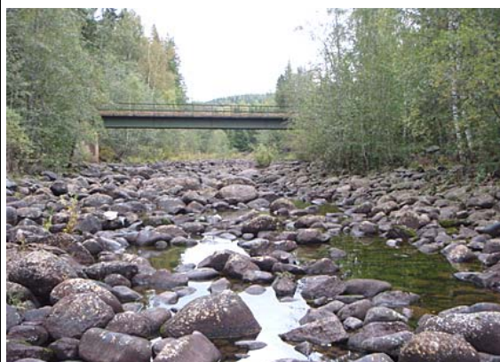
25-40 m nedströms stålbron.
