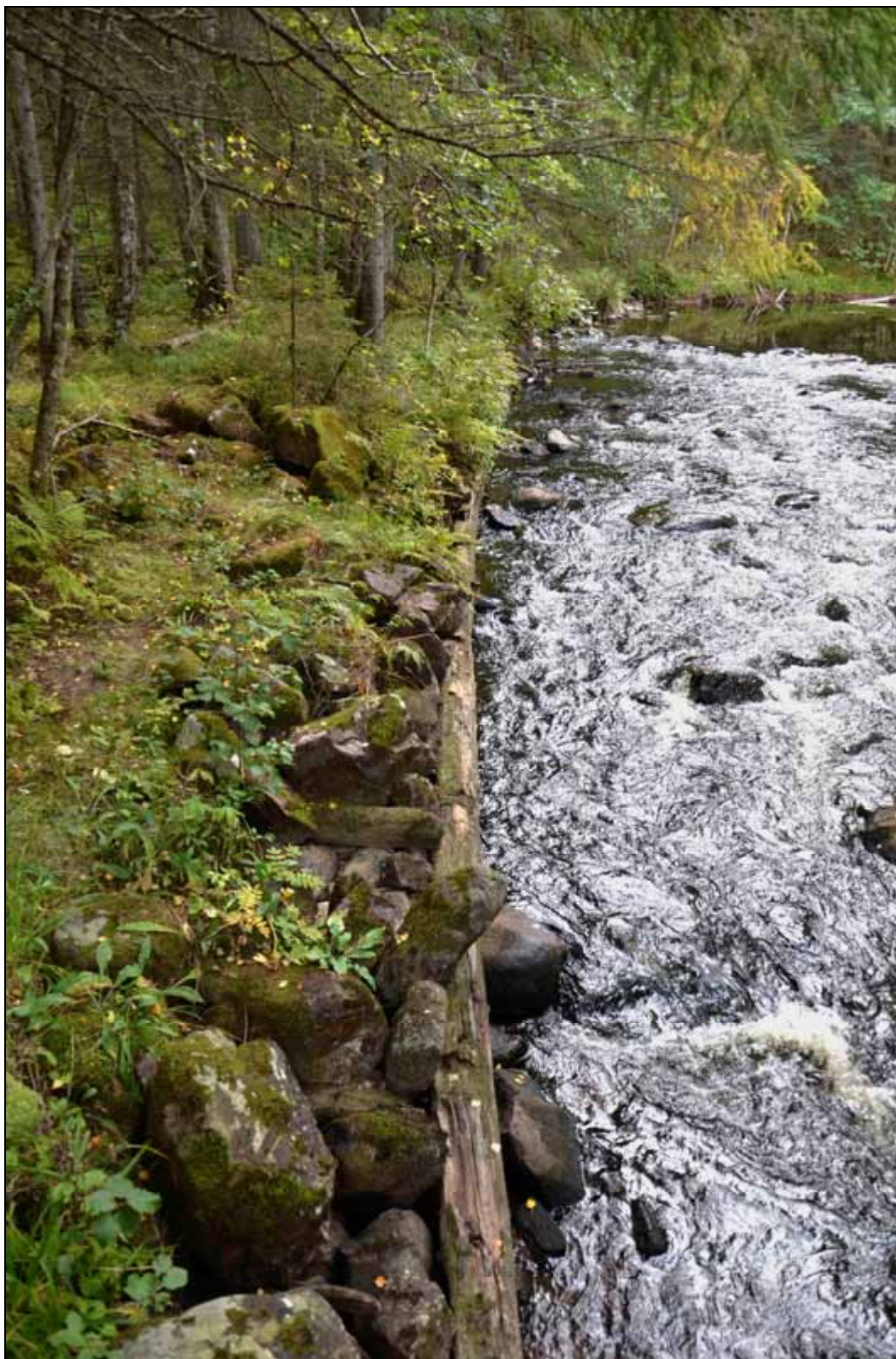
Figur 64. Detalj av strandskoning (objekt 1) med tydliga tvärgående stockar för stabilitet.
