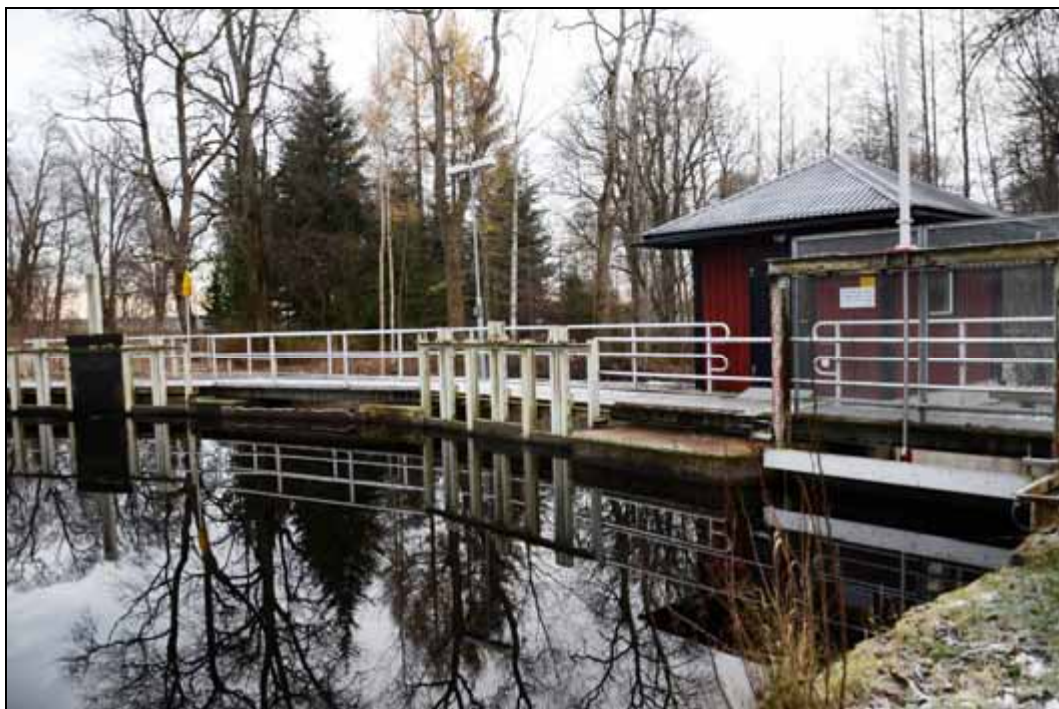
Figur 197. Kraftverksdamm. Foto mot sydöst.
