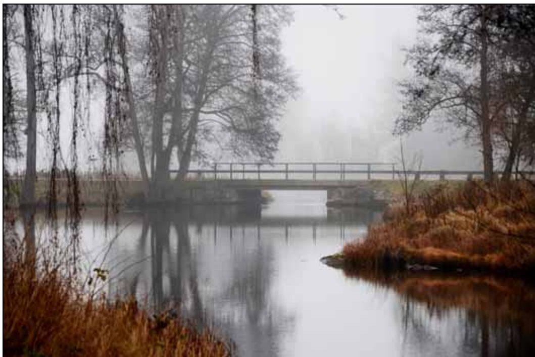
Figur 308. Nyare bro vid äldre överfart över Gunnilboån uppströms kraftverksdammen. Foto mot nordöst.
