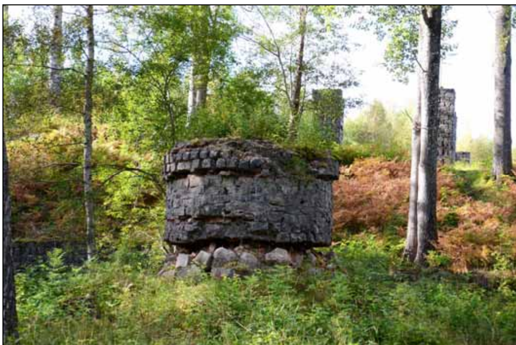
Figur 238. Rester av den nya hyttan. I bakgrunden skymtar kolhusets pelare av slaggsten (Västervåla 42:1). Foto mot norr.
