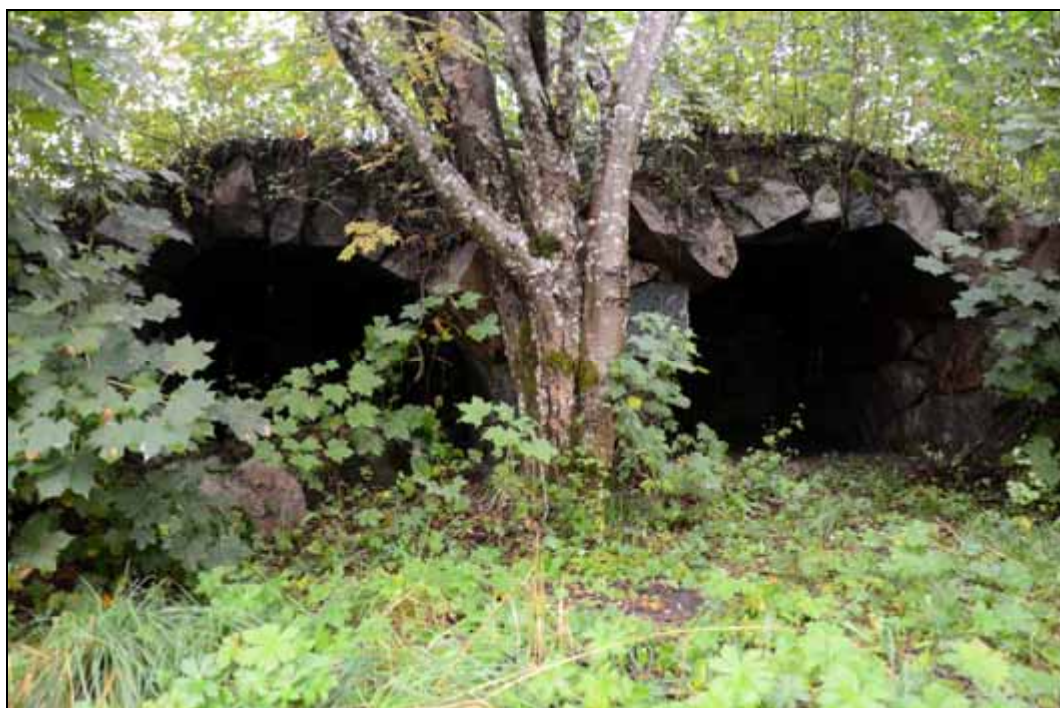
Figur 203. Två öppningar till kallmurade förrådsvalv invid bäckfåran. Foto mot norr.
