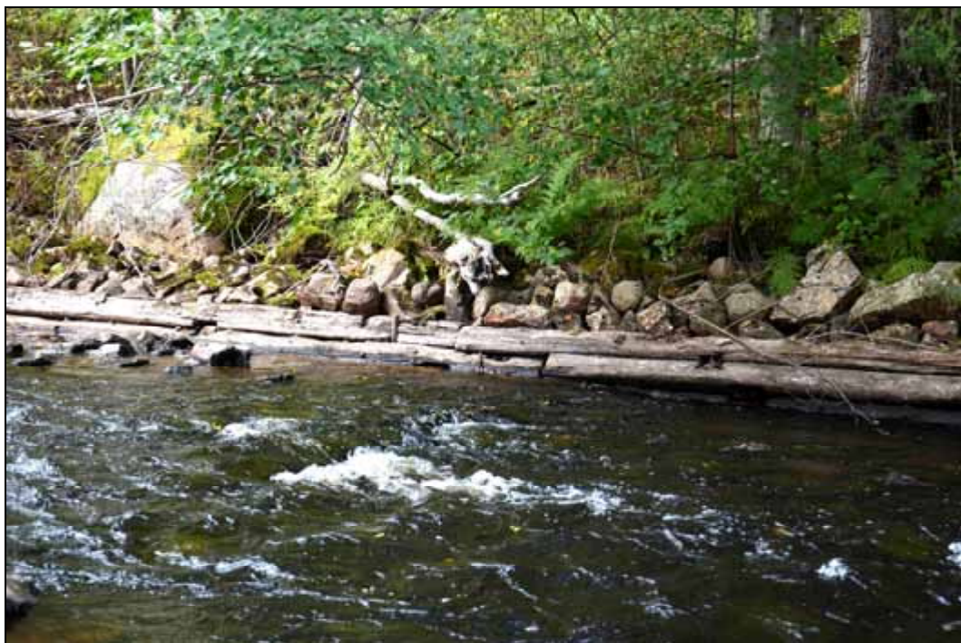
Figur 66. Detalj av objekt 2 som visar konstruktionen med återanvänt timmer.
