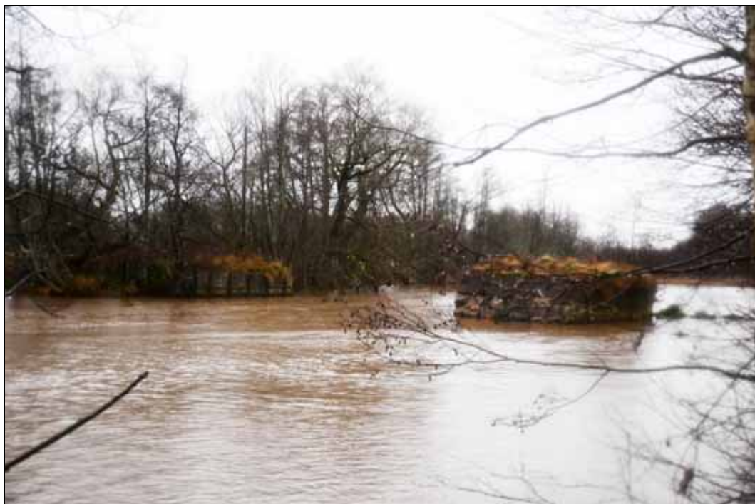
Figur 393. Kallmurat brofundament mitt i Hedströmen. Foto mot norr.
