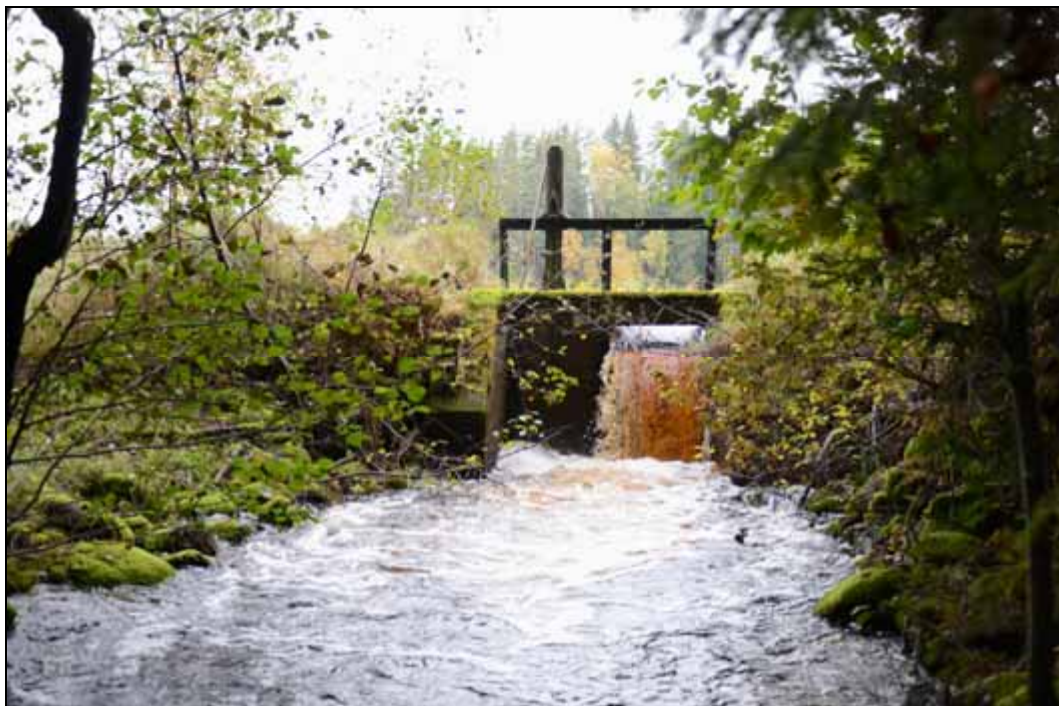
Figur 209. Dämnet vid Nedre Gävjans utlopp. Foto mot väster.
