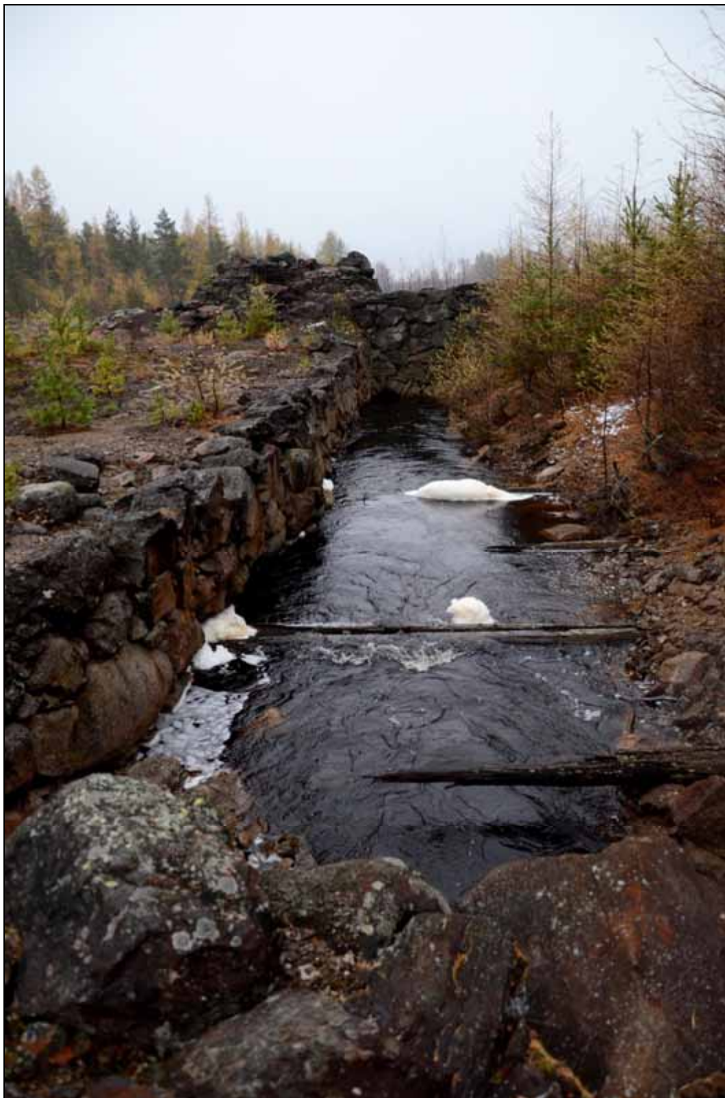
Figur 121. Nästa nedströms liggande damm (nummer 2) med kringliggande anläggningar. Foto mot söder.
