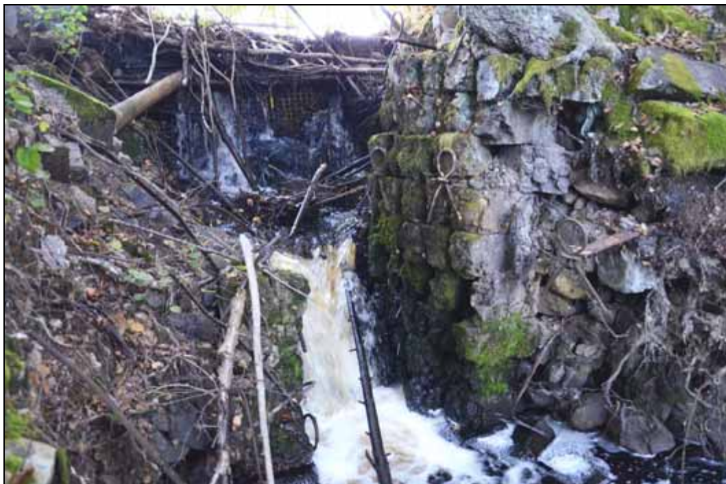
Figur 240. Detalj av dammvallen vid Sågsjöns södra utlopp (Västervåla 107:1). Notera utskovets konstruktion med gjutna slaggstenar sammanhållna av järnryttare. Foto mot norr.
