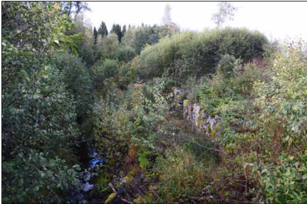
Figur 271. Kraftigt igenväxt vattenränna vid Killinhammar. Foto mot norr.
