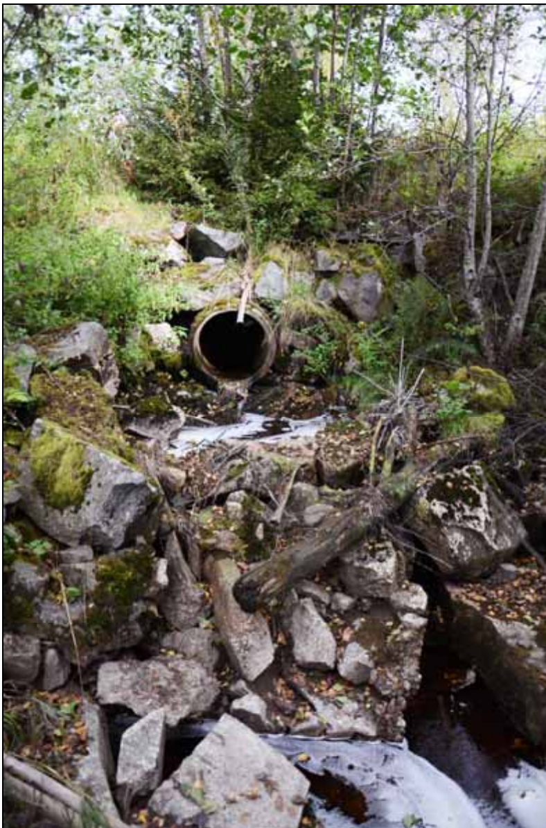
Figur 324. Vandringshindret med cementrör under vägbanken. Foto mot norr.
