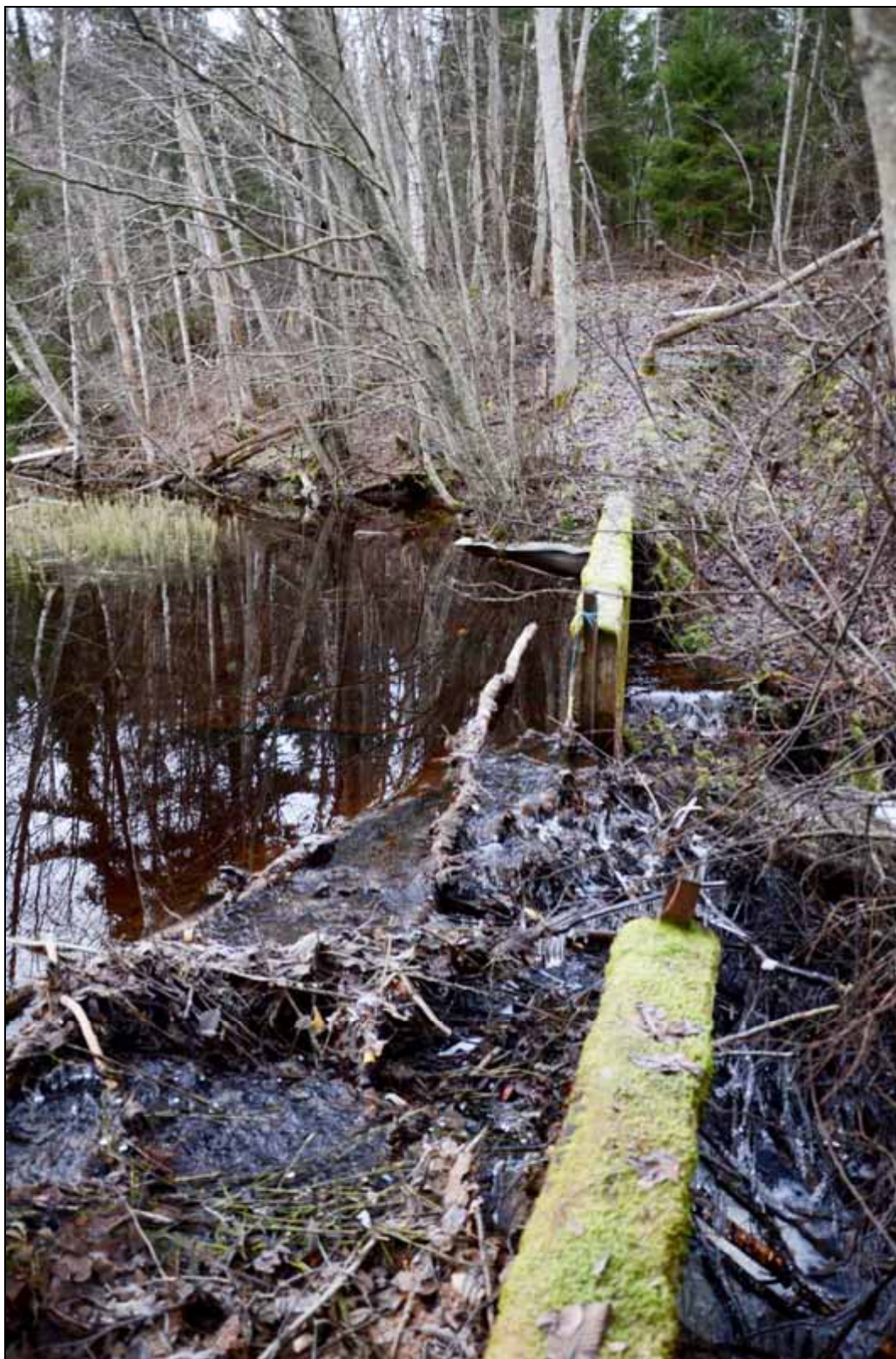
Figur 78. Senare bättring av dammens mittparti. I bakgrunden skymtar en äldre del av anslutningsdammen av jord och sten. Foto mot öster.
