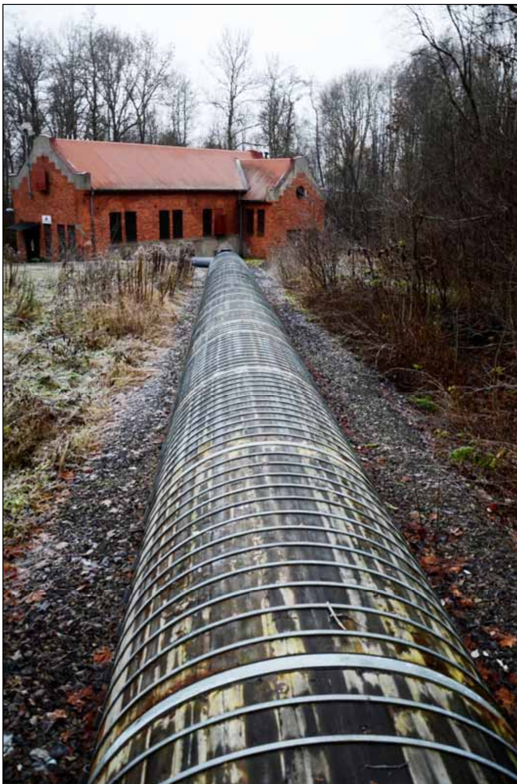
Figur 199. Trätub till kraftverket. Foto mot söder.
