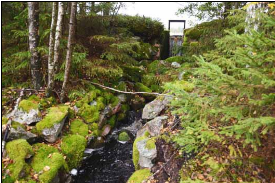
Figur 246. Stensatt vattenränna vid sjön Trehörningens södra utlopp (Västervåla 96:1). Dämmet finns med på en karta från 1698. Foto mot nordväst.
