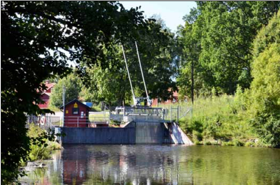
Figur 372. Nuvarande damm vid Kolsva Bruk. Foto mot sydväst.
