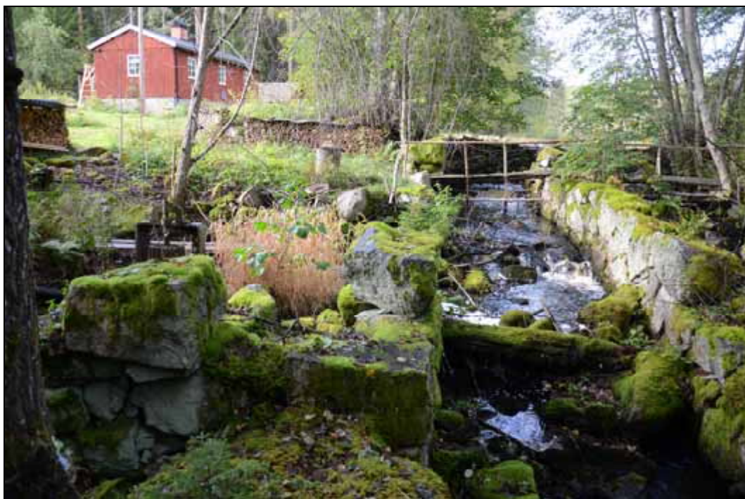
Figur 256. Västra vattenrännan vid Övre hammaren. Foto mot nordväst.
