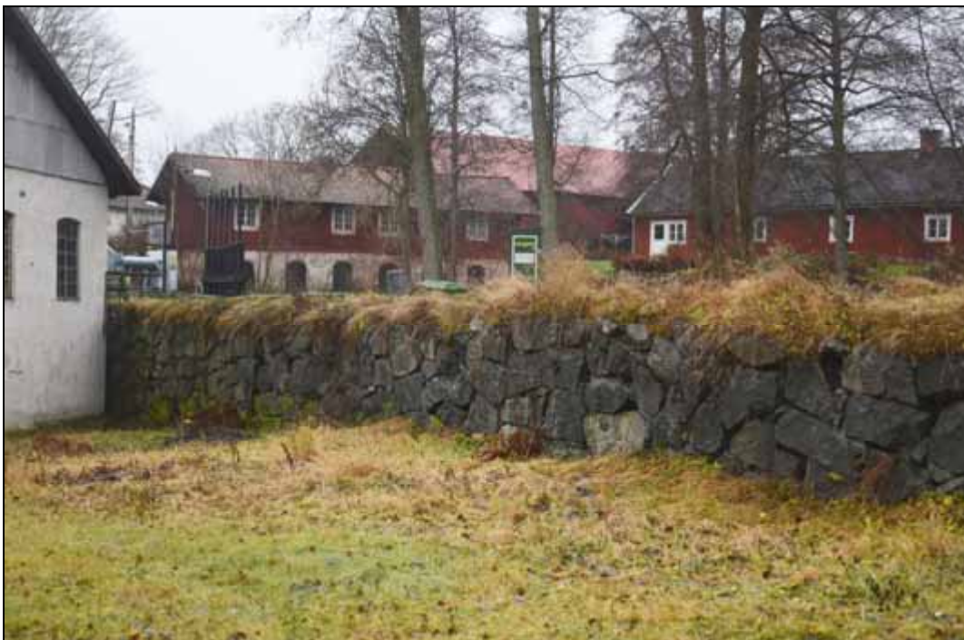
Figur 336. Del av dammanläggningen vid Karmansbo. Foto mot väster.
