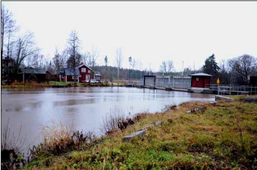
Figur 391. Uppströms kraftverksdammen vid Östuna. Foto mot norr.
