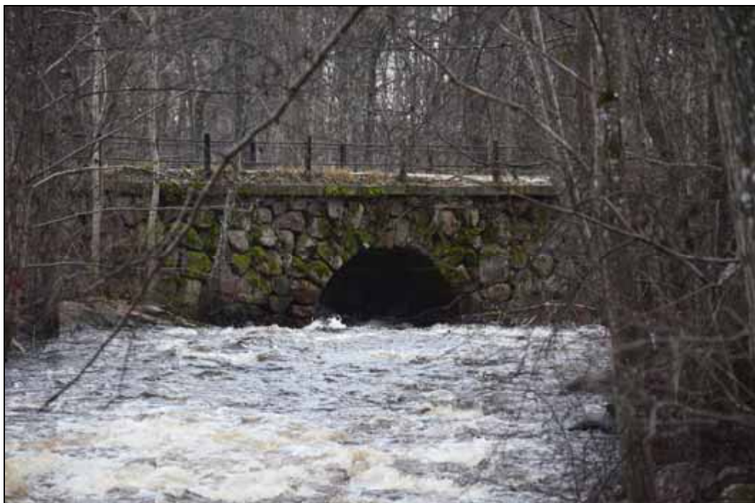
Figur 195. Stenvalvsbron uppförd 1779. Foto mot sydöst
