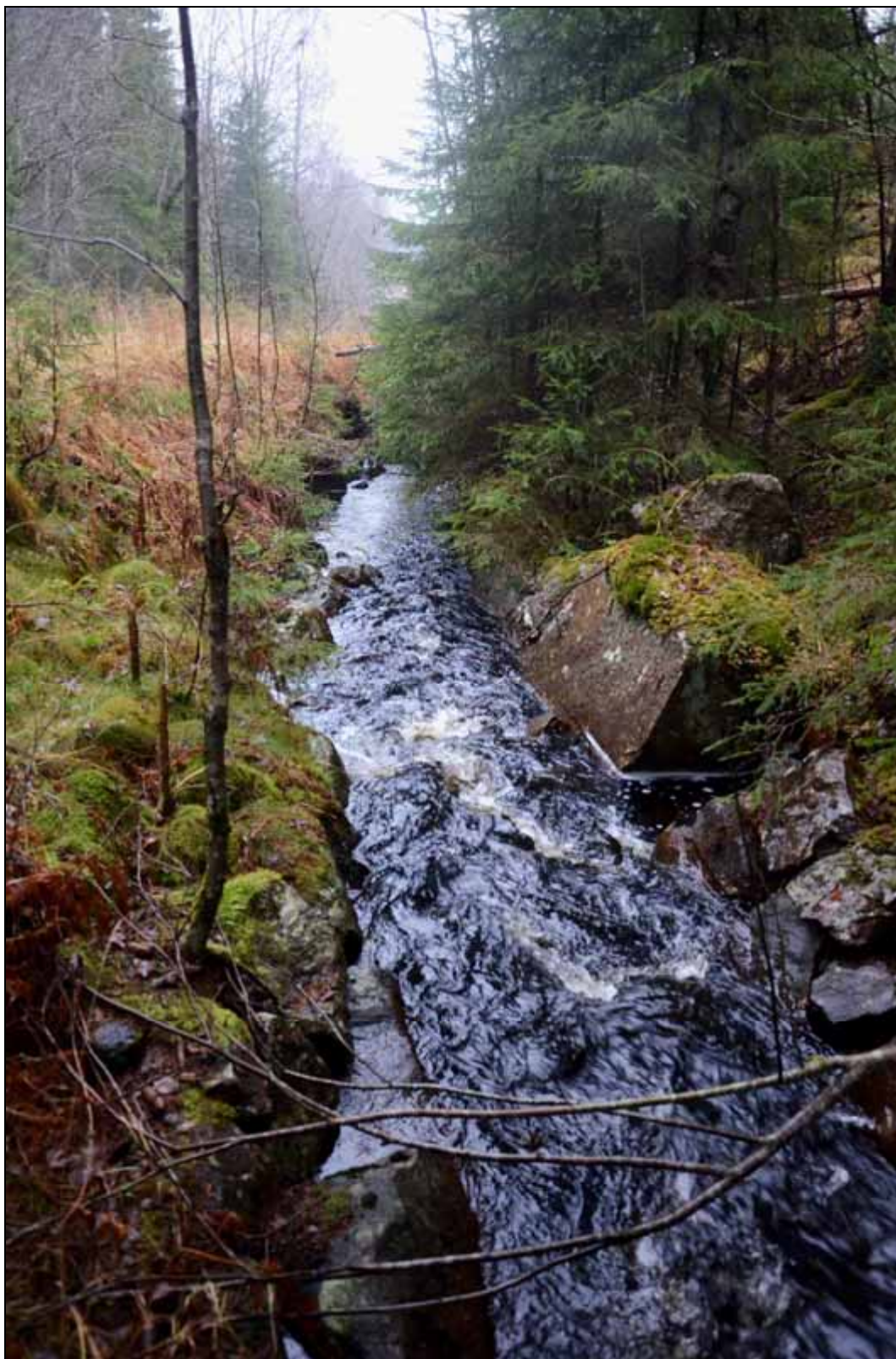
Figur 29. Stensatt bäckfåra nedström Gäddtjärnen. Foto mot nordöst.
