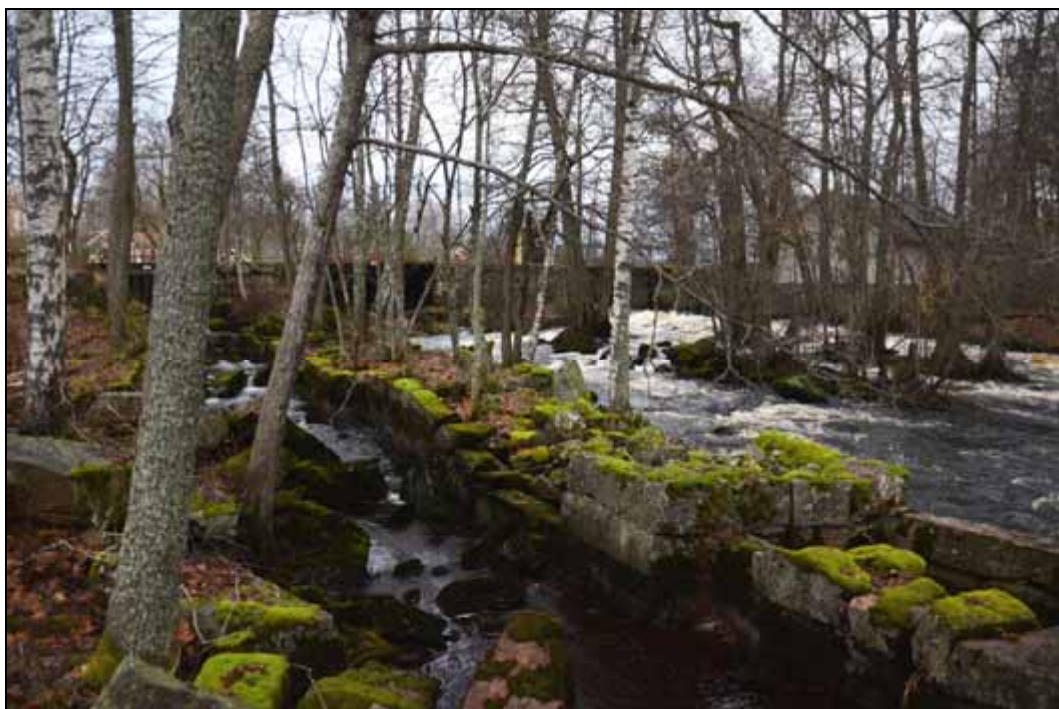
Figur 214. Uttersbergs bruk. Strax nedströms dammen och den gamla bron över Hedströmmen. Foto mot norr.
