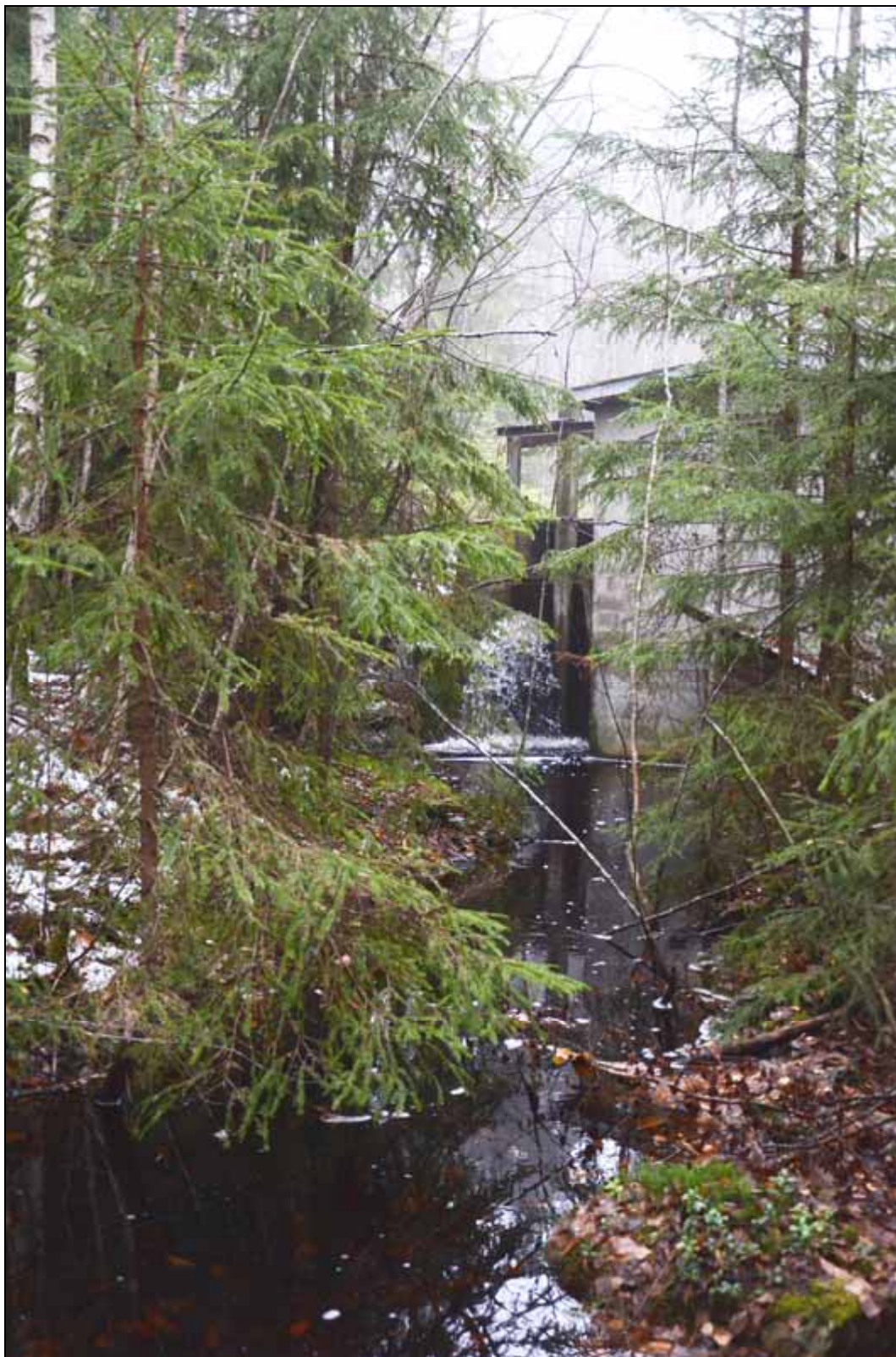
Figur 138. Utskov och pumphus vid Övre Skärsjöns södra utlopp (objekt 1). Foto mot nordöst.
