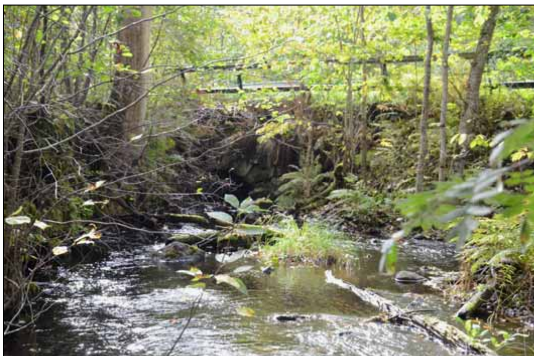
Figur 261. Bakom grönskan kan stenvalvsbron invid Bockhammar anas. Foto mot sydväst.
