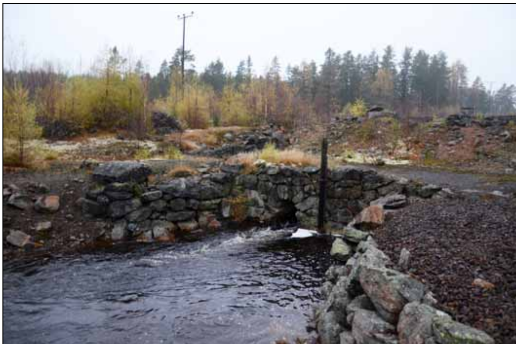
Figur 126. Nya Kopparverket. Nedströms damm nummer 4. Foto mot nordväst.
