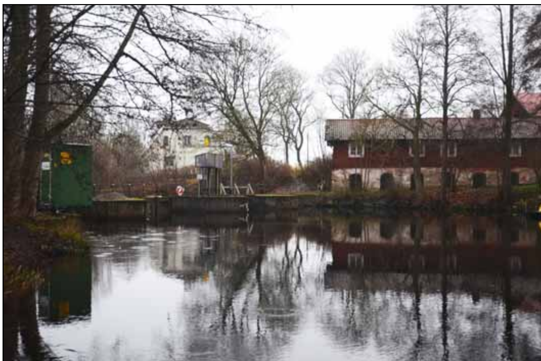
Figur 338. Uppströms dammen vid Karmansbo. Foto mot sydväst.
