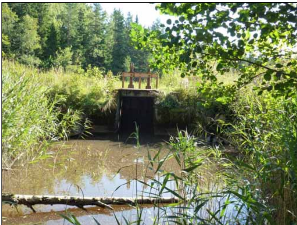
Figur 295. Nedströms dämmet vid sjön Långbjörkens utlopp ( Gunnilbo 72:1). Foto mot nordöst.
