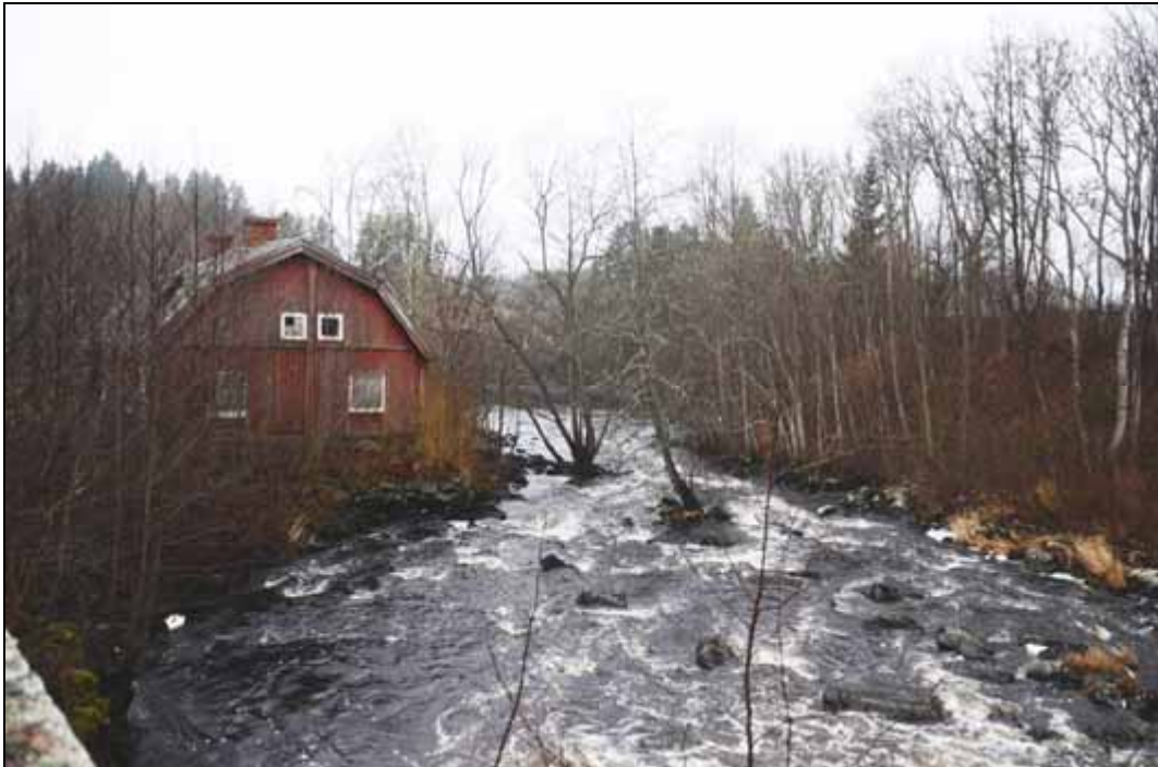
Figur 343. Hedströmmen vid Holmens Kraftstation. Byggnaden har en så kraftig stenfoot att den kan vara byggd på den forna hammargrunden. Foto mot söder.
