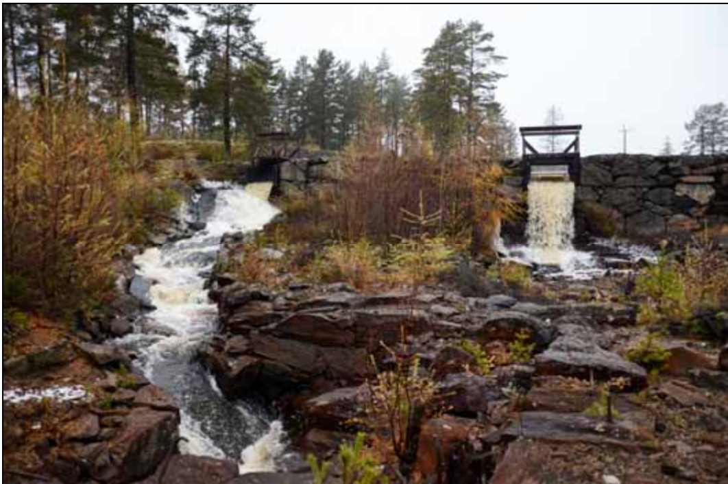
Figur 124. Nya Kopparverket. Damm nr 2. Foto mot norr.
