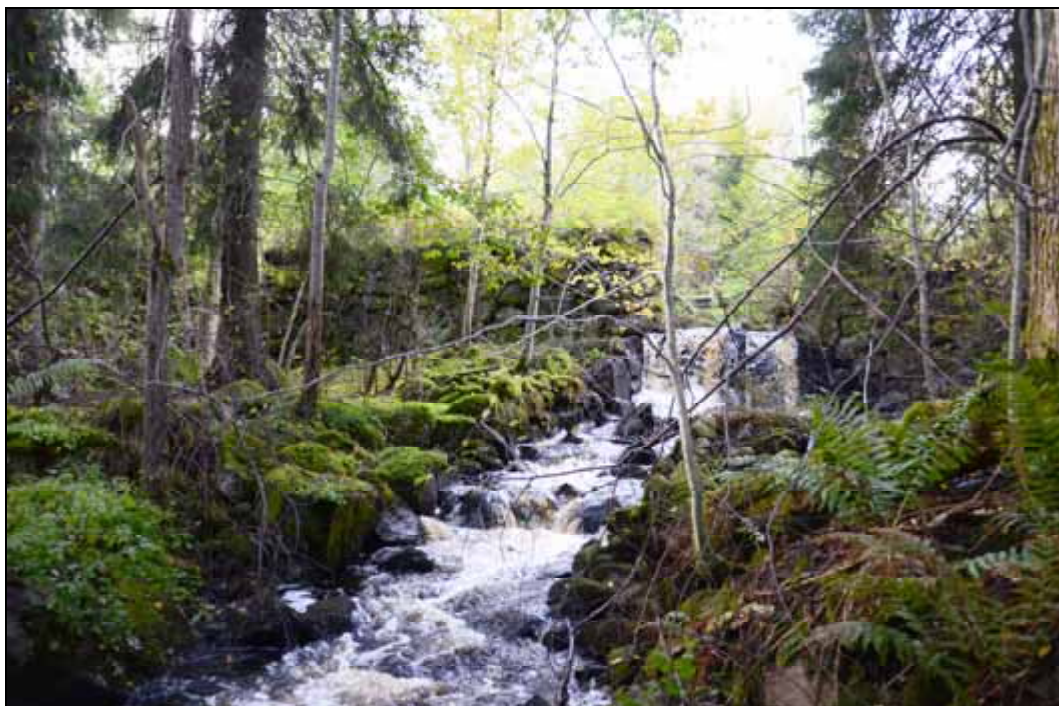
Figur 257. Dammen vid Gethammaren. Foto mot nordväst.
