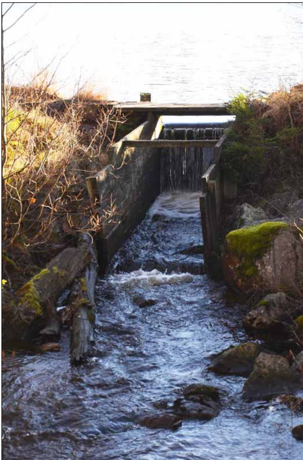
Figur 36. Det av trä fodrade utskovet vid Stora Djurlångens utlopp. Foto mot öster.
