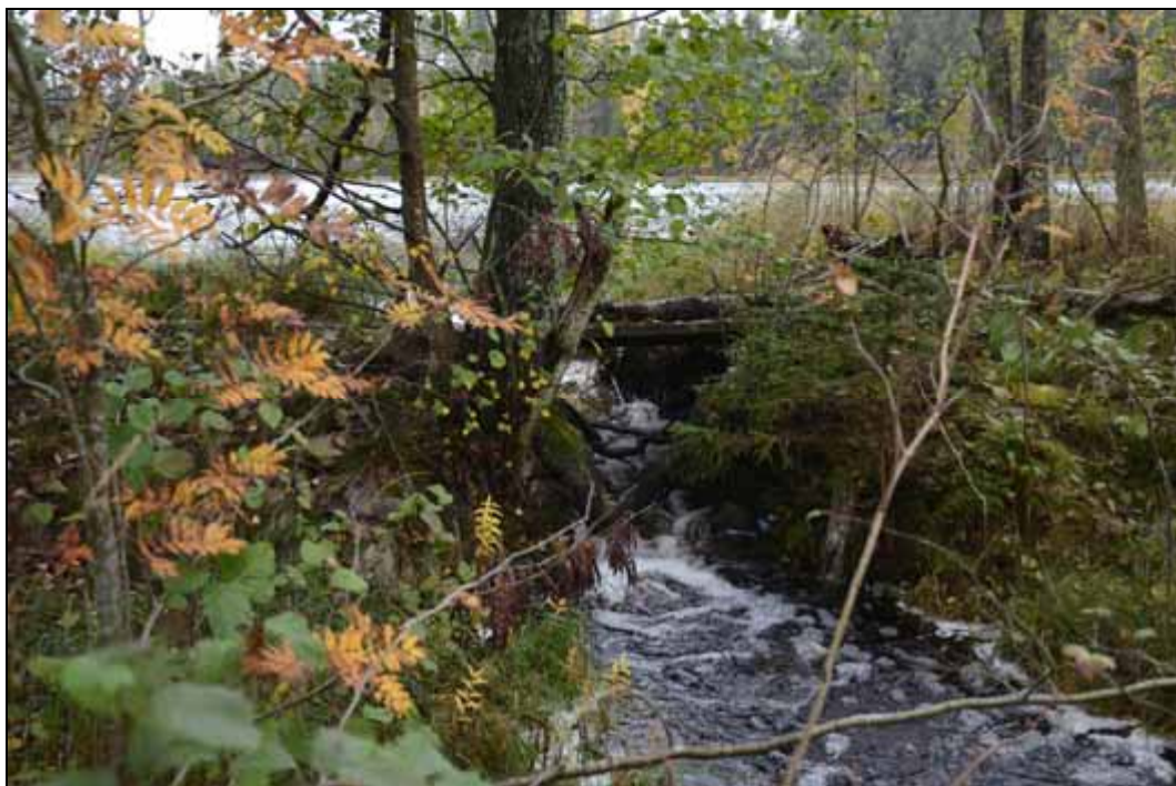
Figur 189. Dammvallen vid Dammsjön, Nyhyttan. Foto mot öster.
