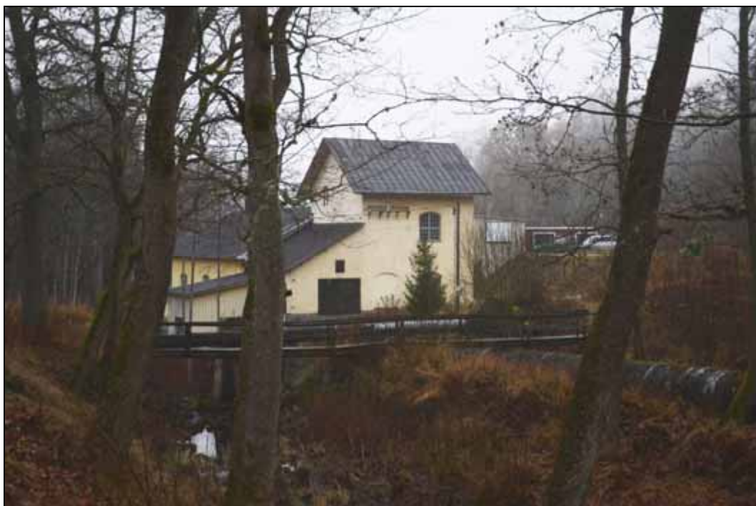
Figur 309. Turbinhus vid Färna på åns västra sida. Foto mot sydväst.
