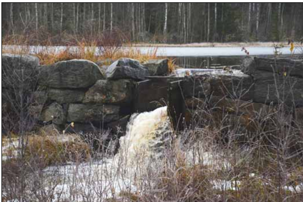
Figur 141. Utskovet i Bockmossdammen. Foto mot norr.
