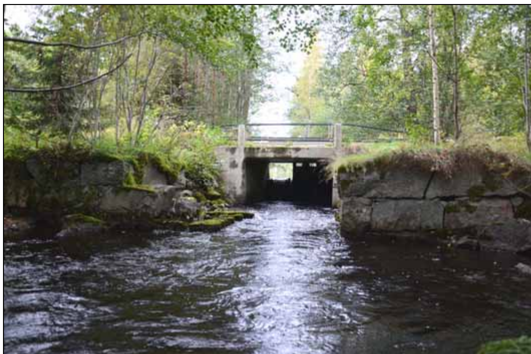
Figur 250. Två generationers broar vid Landfors hammare. På den översta stenen i bildens högra hörn finns en ristad datering: 1880. Foto mot N.
