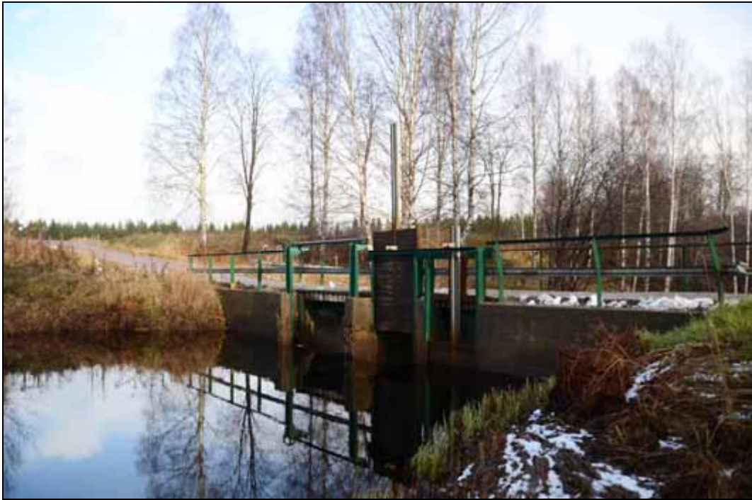
Figur 53. Dämmet uppströms Nedre Borgfors. Foto mot nordöst.
