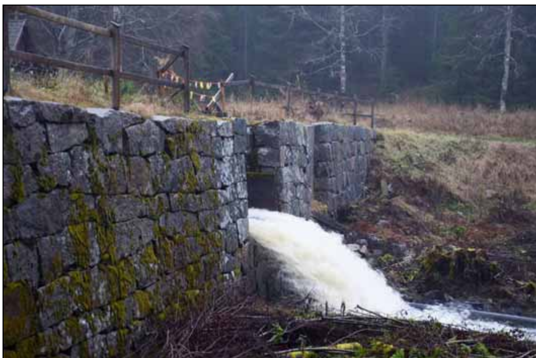
Figur 21. Dammens väl lagda kallmurade sydsida. Foto mot nordöst.
