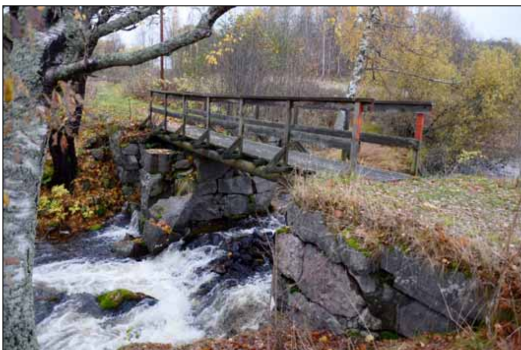
Figur 105. Registrerad fördämningsanläggning (Skinskatteberg 225:1) fungerar idag som gångbro över Darsbobäcken. Fördämningsanläggningen är troligen identiskt med den kvarn som omnämns på 1696 års geometriska karta. Observera hjulgraven längs bort och till vänster i bild. Foto mot norr.
