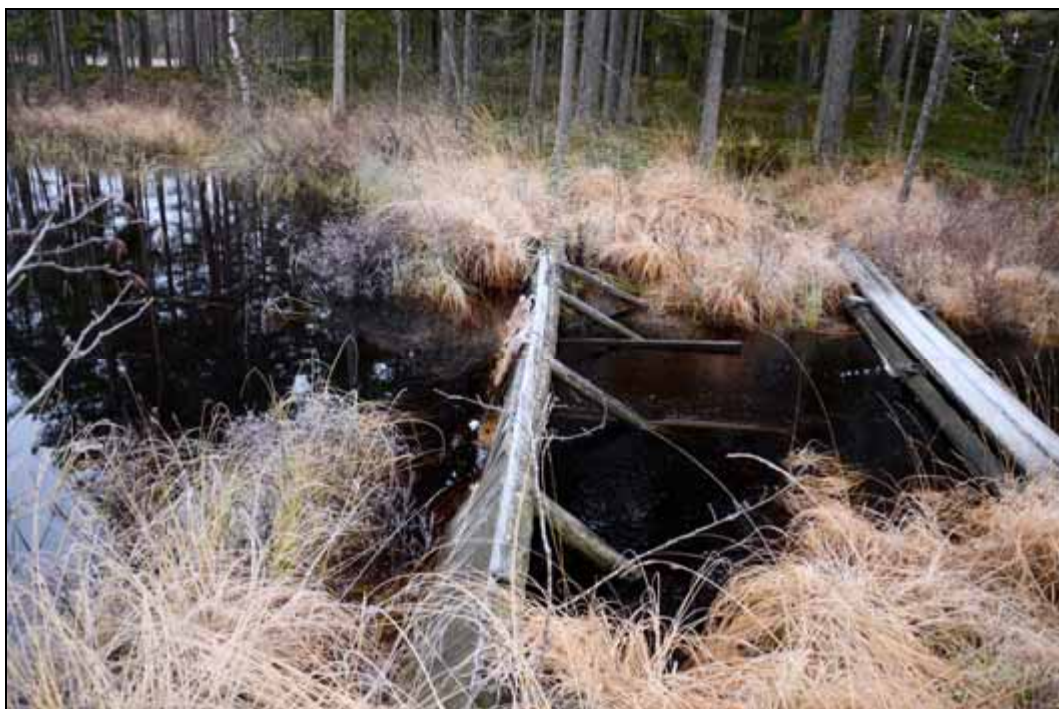
Figur 176. Närbild på dämnet vid Kärringgetsjöns utlopp. Foto mot öster.
