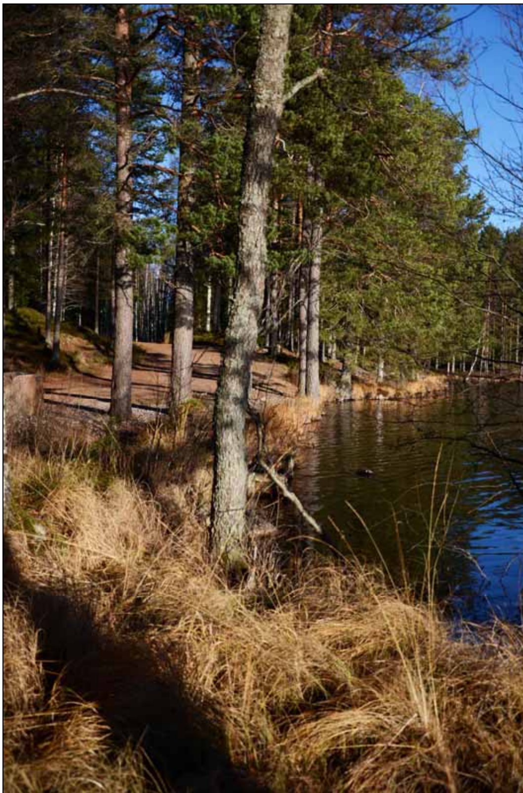
Figur 37. Del av dammvallen. Foto mot norr.
