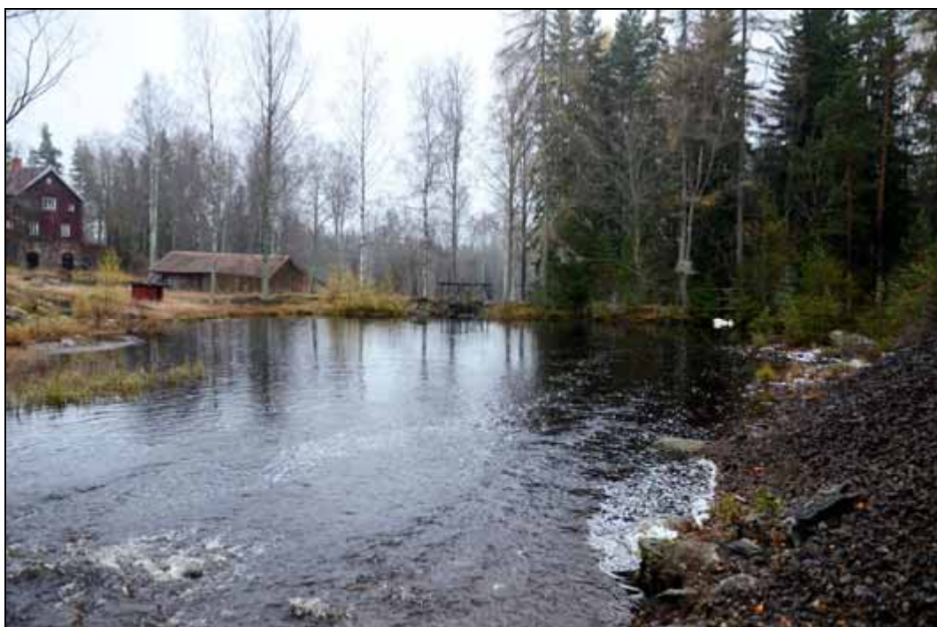
Figur 127. Nya Kopparverket. Uppströms damm nr 5. Foto mot söder.
