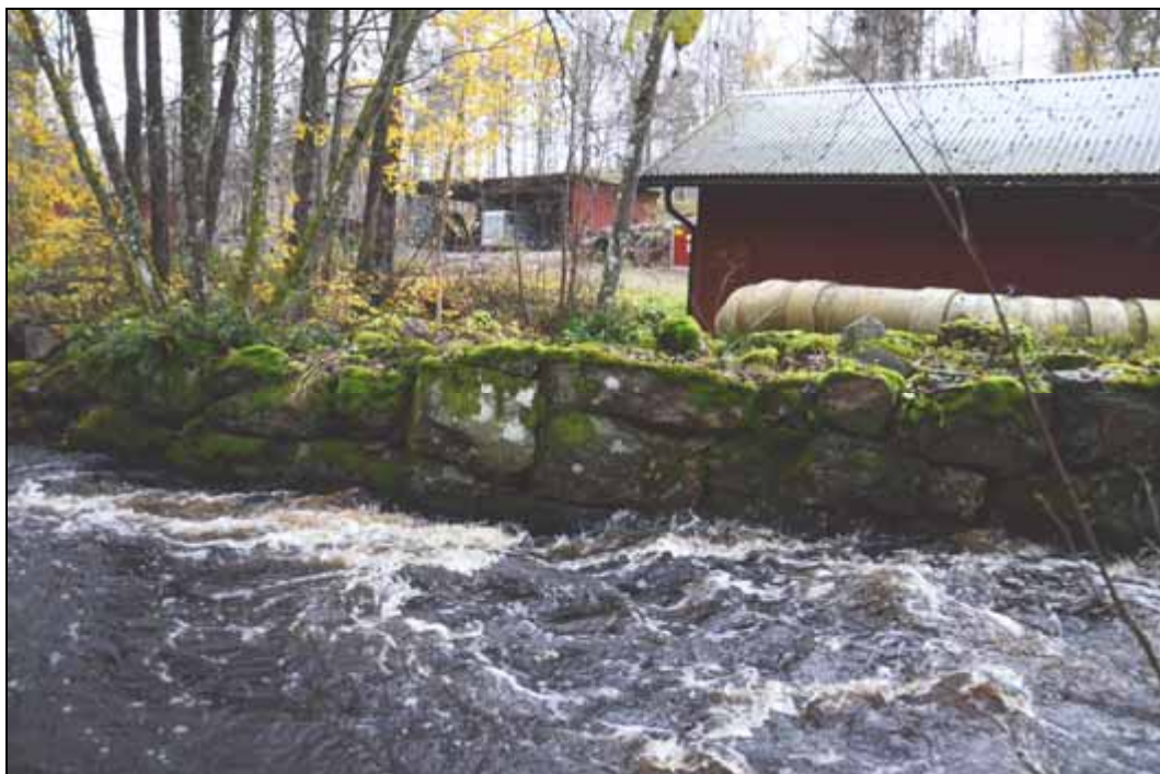
Figur 282. Förstärkning av den västra strömfåran nedströms dammen vid Kedjebohammar. Foto mot sydväst.
