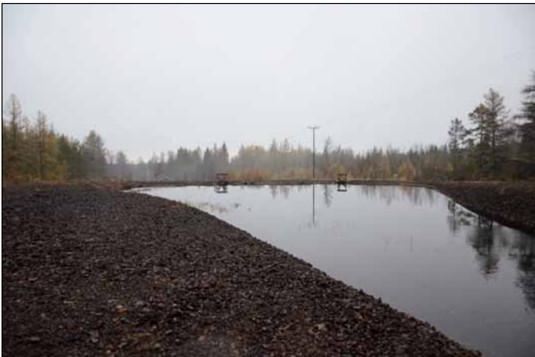
Figur 125. Nya Kopparverket. Uppströms damm nr 3. Foto mot söder
