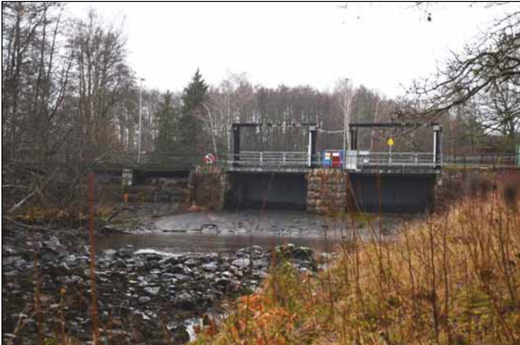
Figur 385. Nedströms Ekeby damm. Foto mot norr.
