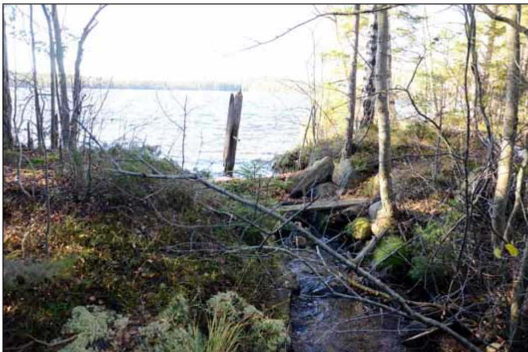
Figur 82. Västra Skälsjöns utlopp med öppning i dammvallen. Foto mot väster.
