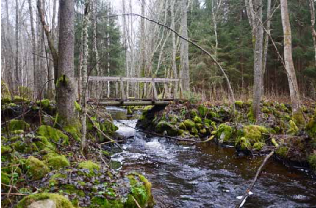
Figur 299. Broläggning över Gillbobäcken strax sydöst om bebyggelsen. Foto mot norr.
