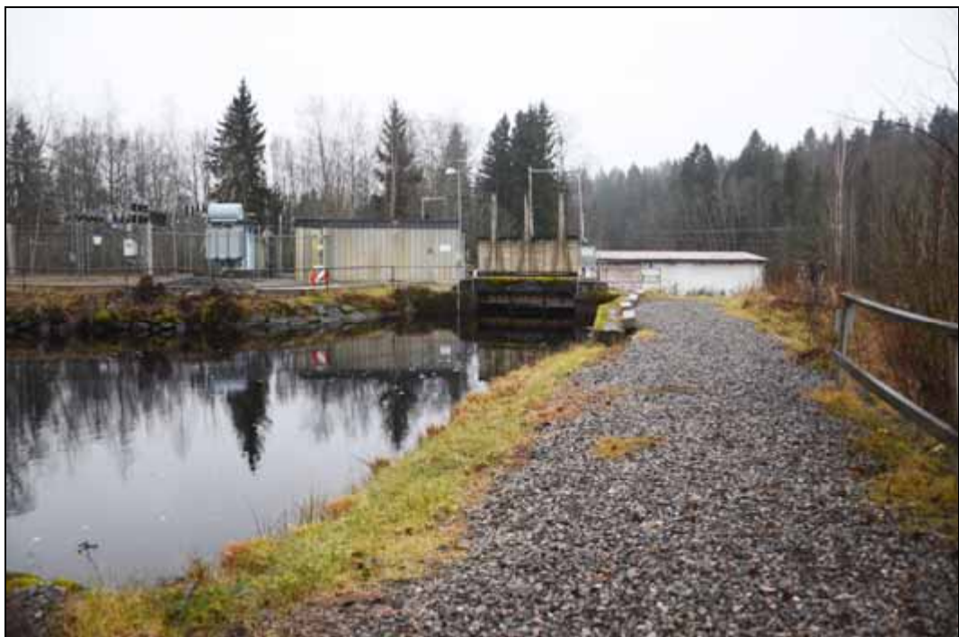
Figur 342. Holmens Kraftstation. Foto mot söder.
