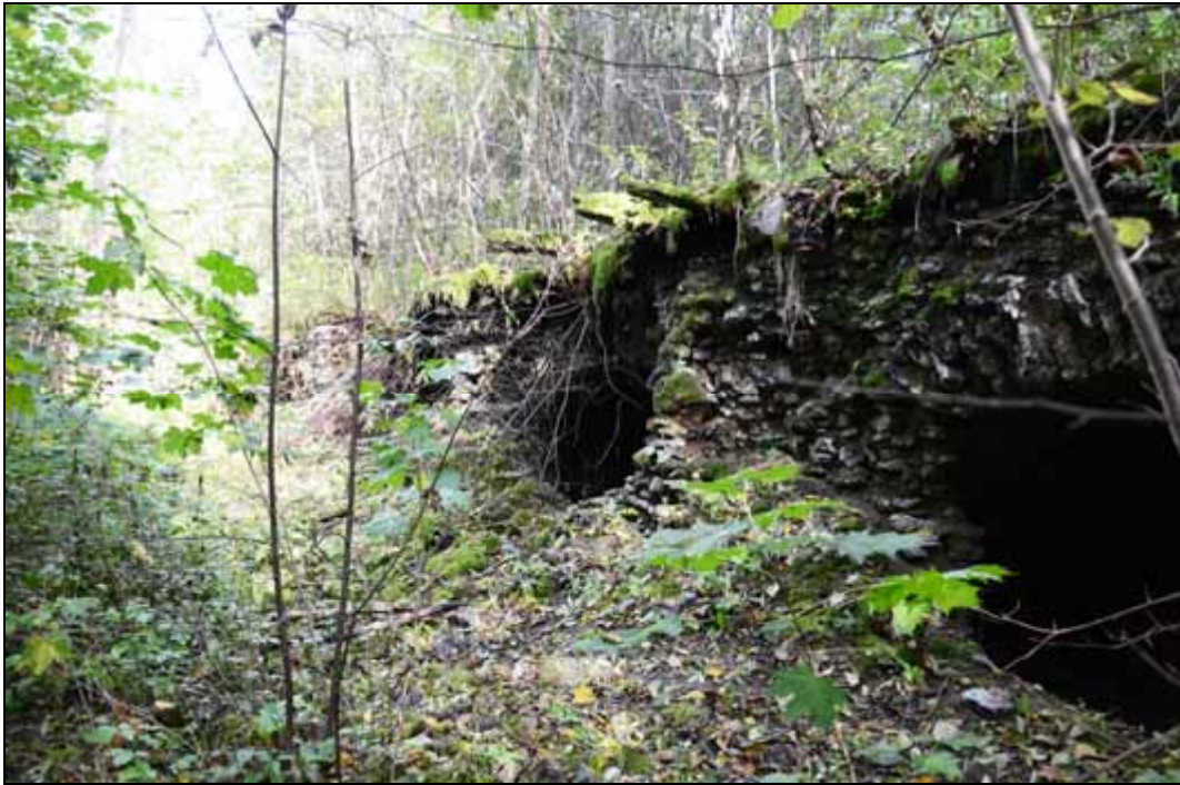
Figur 233. Källarvalv uppbyggda av material från slaggvarpet (Västervåla 43:1). Foto mot nordöst.
