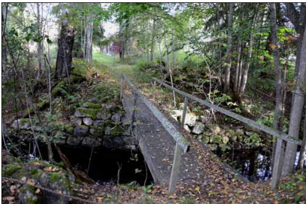
Figur 289. Äldre brofäste över en grävd kanal från Flenasjön till sågen invid Flenaåns utlopp i Norrsjön. Foto mot norr.
