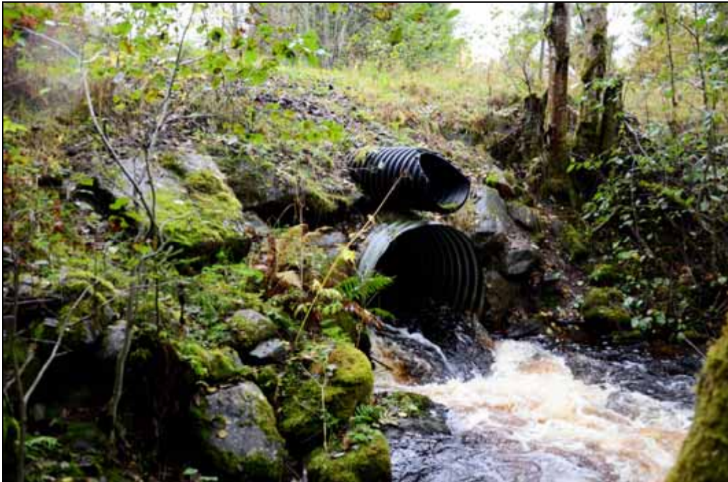
Figur 182. Rester efter Krabo hytta på nedsidan dammen. Foto mot norr.
