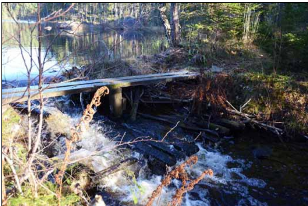
Figur 48. Dämmet vid sjön Lilla Håltjärns södra utlopp. Notera träkonstruktionen på skibordets botten.
