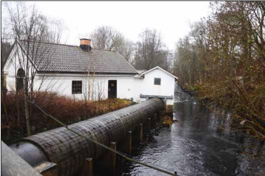
Figur 335. Vattentub och turbinhus nedströms kraftverksdammen. Foto mot söder.
