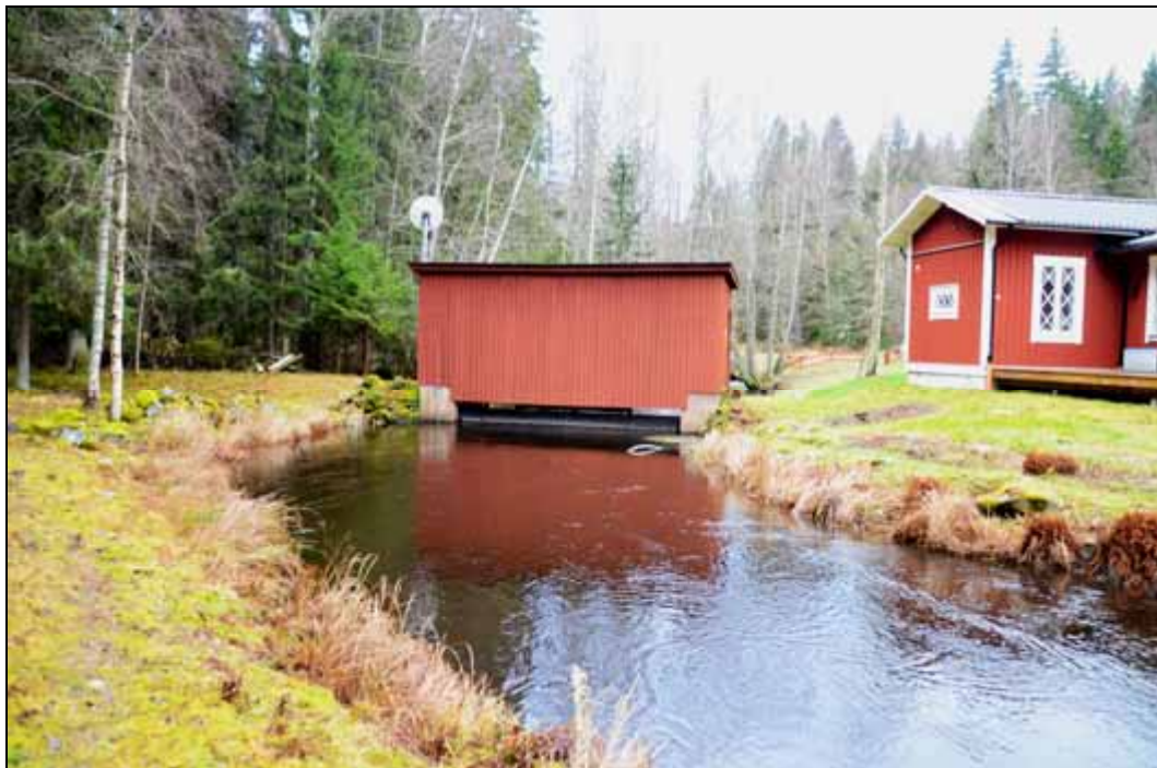
Figur 350. Mindre kraftverk vid Åholmen som utgör ett utpekat vandringshinder för fisk. Foto mot söder.
