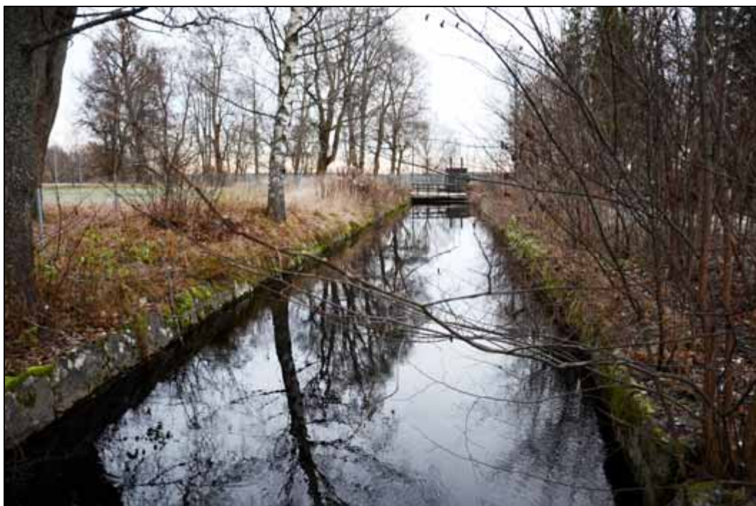
Figur 196. Kanal invid Skinnskattebergs herrgård. Foto mot sydöst.
