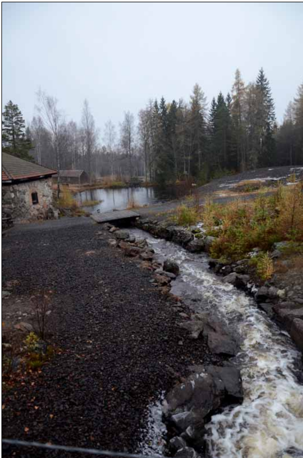
Figur 128. Kopparverket. Vandringshinder 1274. Foto mot söder.
