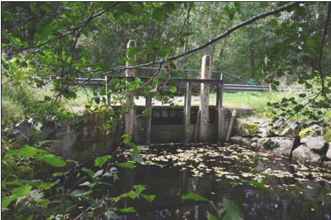
Figur 287. Kombinerad bro och dämme vid Flenassjöns utlopp. Foto mot väster.
