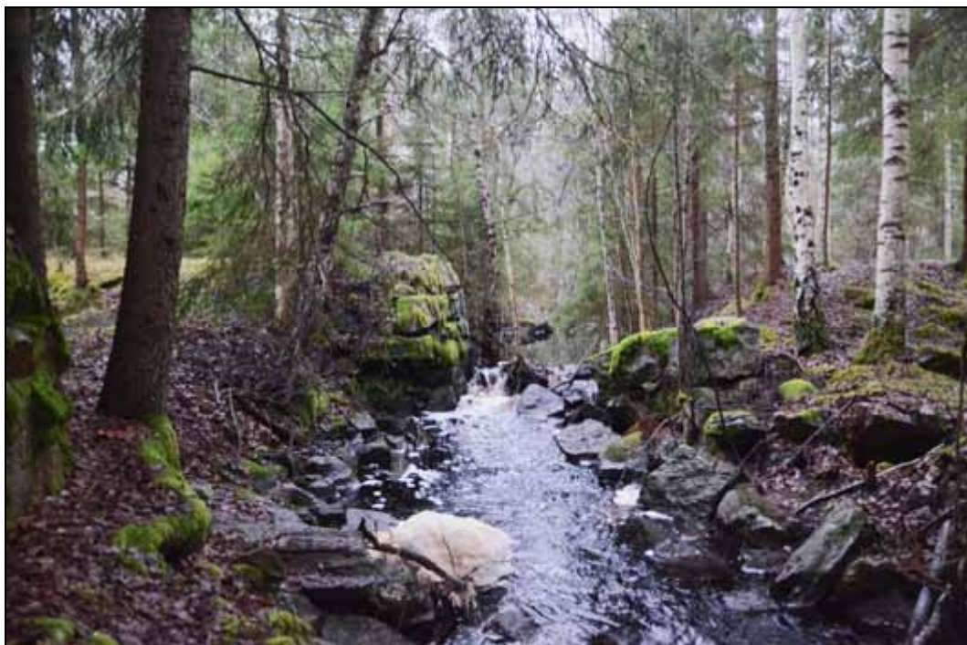
Figur 322. Dammanläggning (Hed 85:1) belägen i bäcken nordväst om Rytartorpet. Foto mot sydväst.
