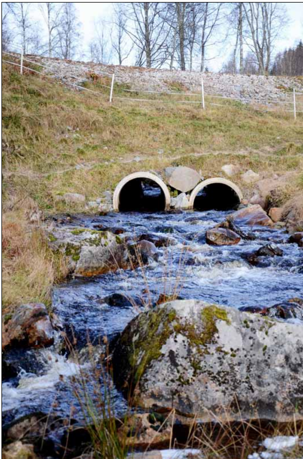
Figur 88. Relativt nylagda vägtrummor i Järån vid Skräddarbo hyttområde. Foto mot nordväst.
