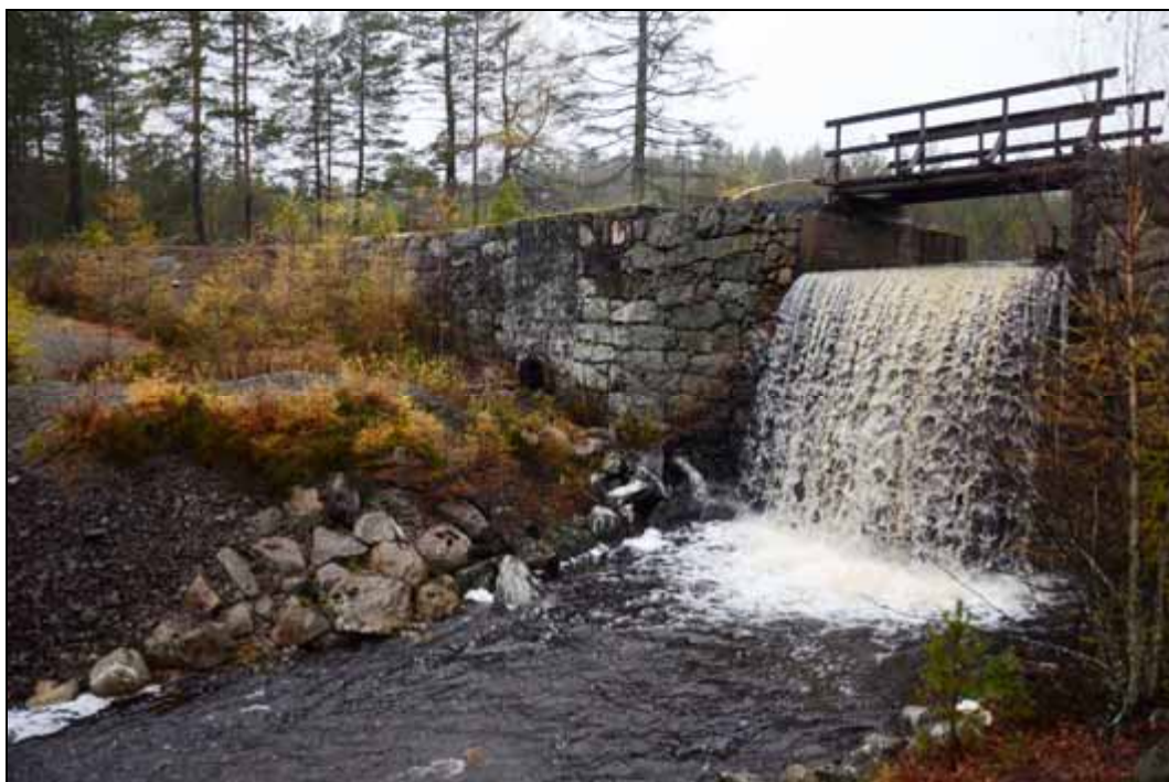
Figur 120. Övre dammen närmast Nedre Skärsjön, sedd nedströms. Foto mot nordväst.
