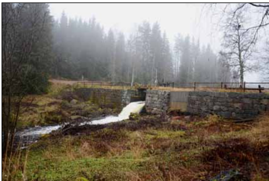
Figur 17. Dammen vid Korslångssmedjan. Foto mot nordväst. Notera det igensatta flötningsutskovet till höger på dammen.
