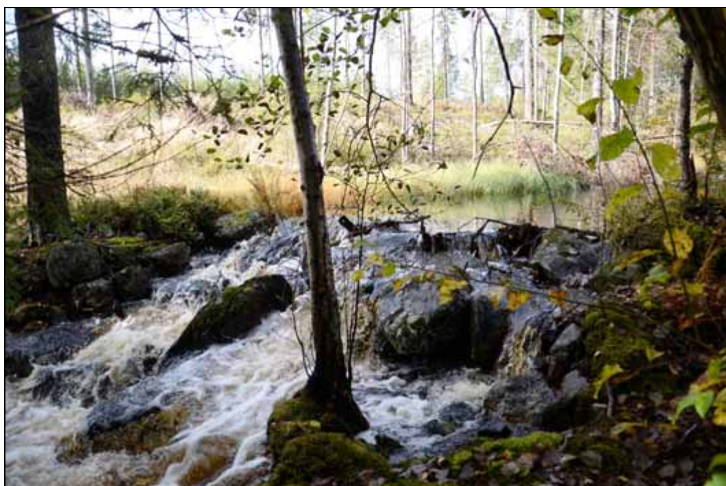
Figur 174. Äldre dammvall vid hyttområde (Skinskatteberg 321:1). Troligen platsen för Pehrs hytta. Utpekad vandringshinder för fisk. Foto mot nordväst.
