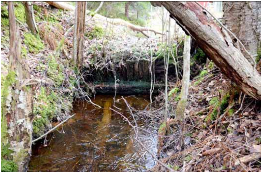
Figur 77. Detalj av dammkonstruktionen med jordfylld träkiskta. Foto mot norr.
