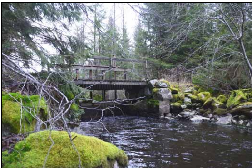
Figur 352. Registrerat vandringshinder för fisk i form av dammanläggning i den östra åfåran. På äldre lantmäterikarta från 1781 återfinns den som både damm och bro. Foto mot nordöst.
