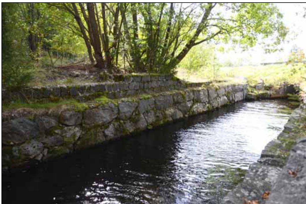
Figur 291. Kallmurad stenförstärkning av åfåran samt slaggstensgrund efter sågen vid Västra Flena. Foto mot väster.
