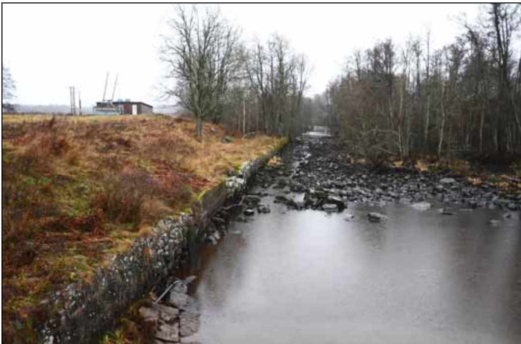
Figur 386. Stensatt strömfåra vid Hjulbron. I bakgrunden skymtar Ekeby kraftverk. Mot söder.
