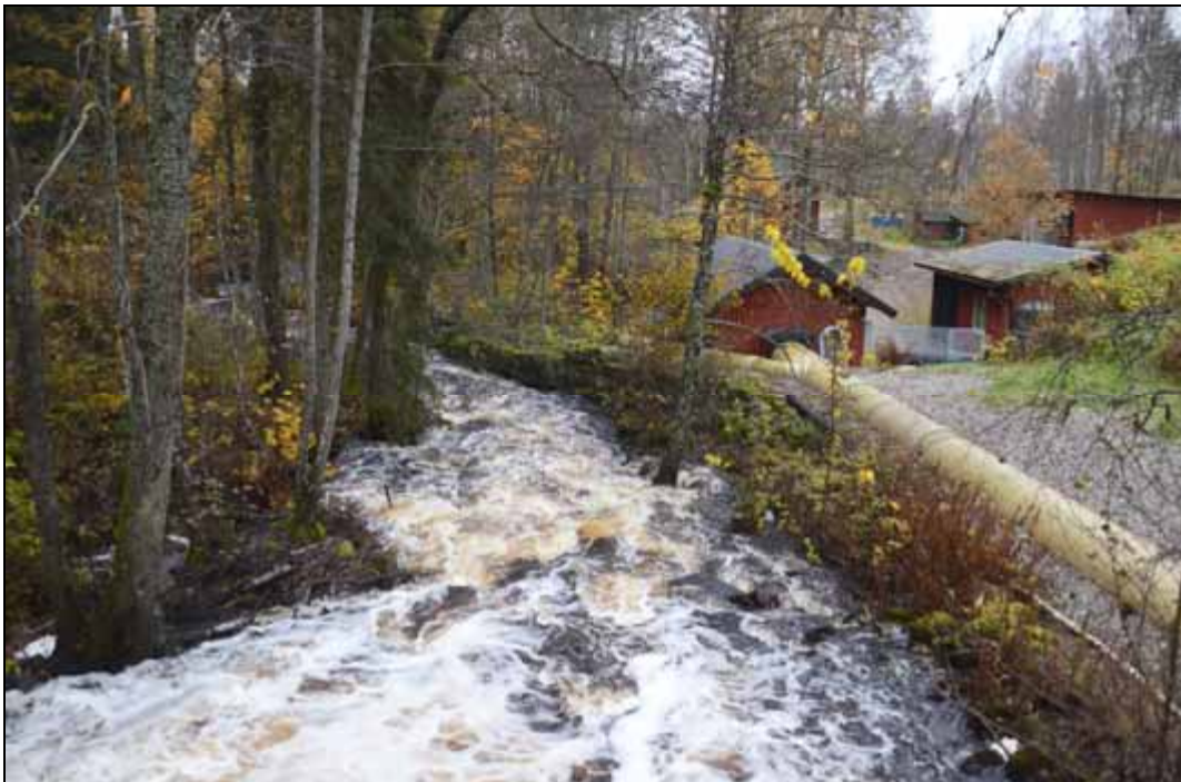
Figur 279. Nedströms Kedjebohammar. Till höger i bild skymtar vattentub och turbinhus. Foto mot söder.
