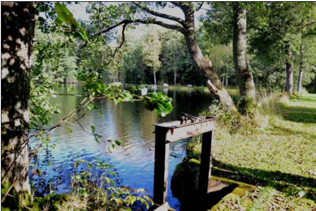
Figur 234. Utskov vid Damsjöns södra utlopp (Västervåla 80:1). Foto mot nordöst.
