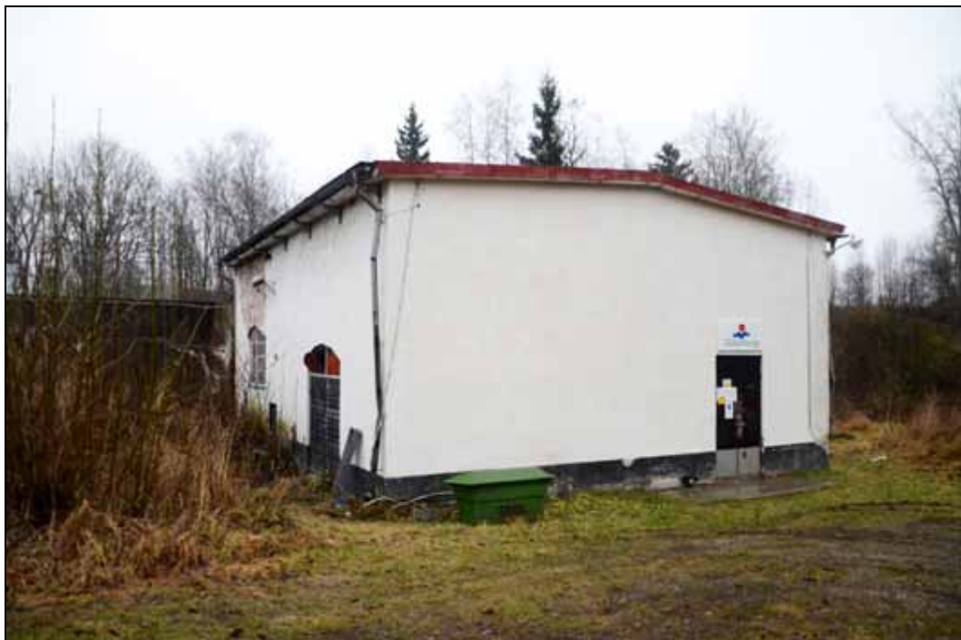
Figur 345. Turbinhus vid Holmens Kraftstation. Foto mot öster.
