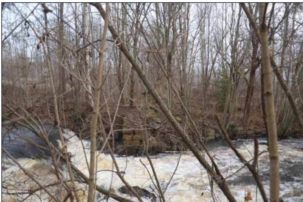
Figur 194. Grunder efter hammare strömmen i Skinnskatteberg. Foto mot öster.
