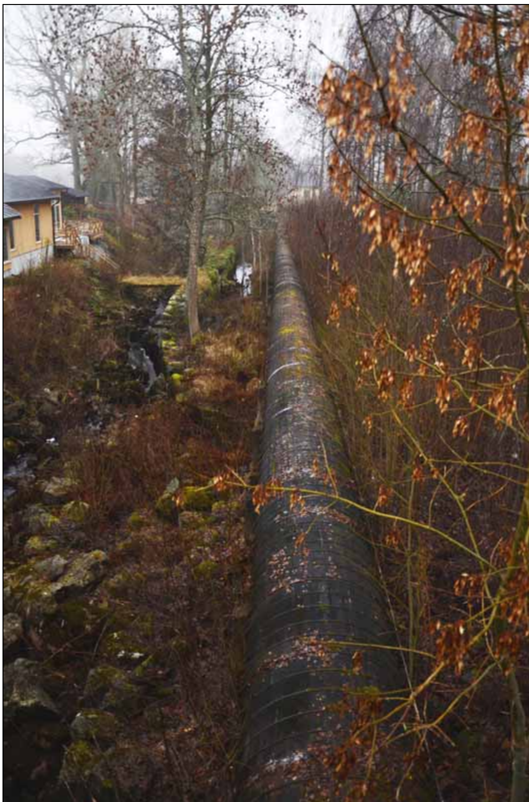
Figur 310. Från kraftverksdammen går en ca 200 m lång vattentub av trä ner till turbinhuset på föregående bild. Foto mot söder.
