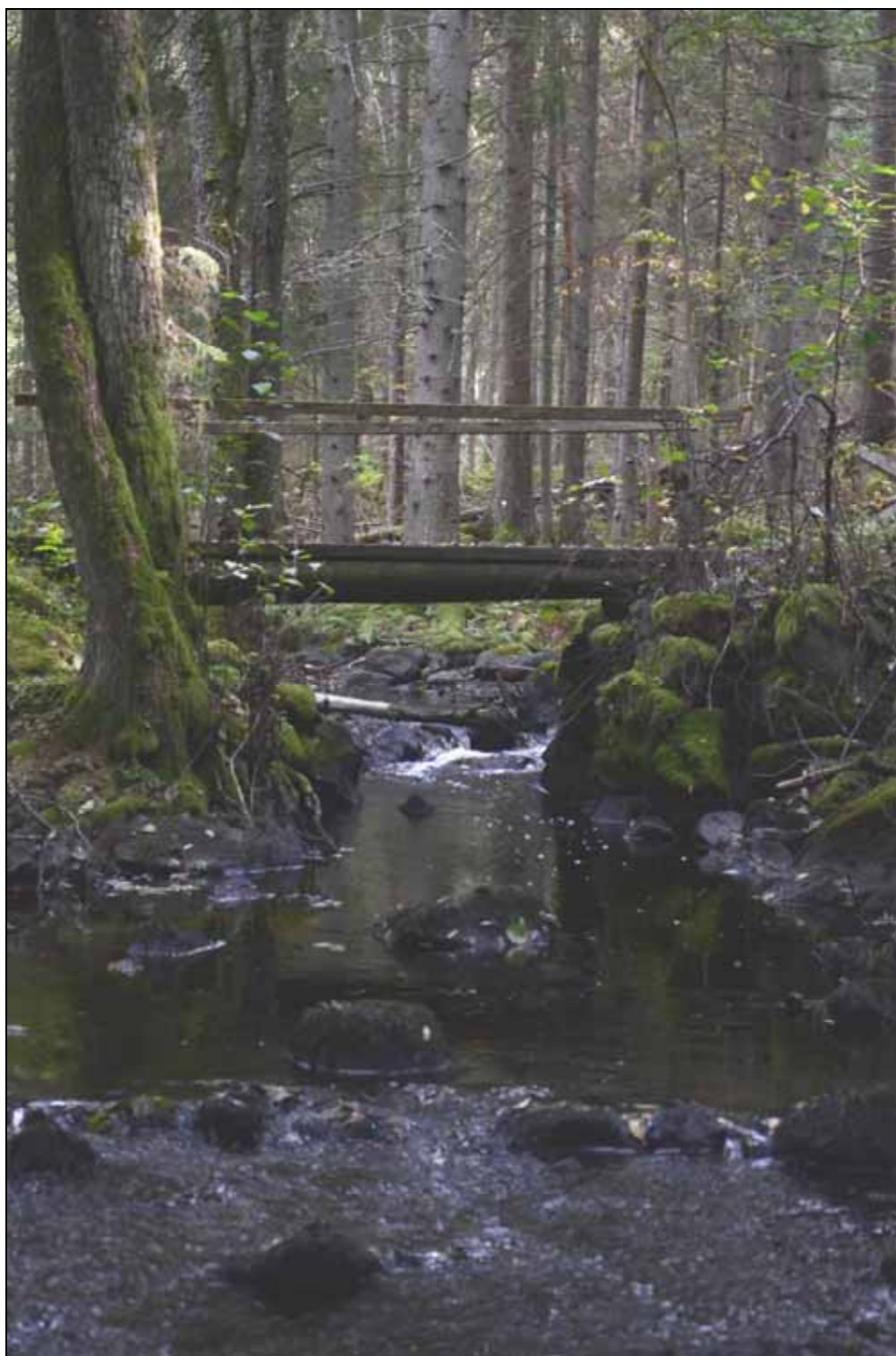
Figur 292. Återanvänt äldre brofäste vid Österflena hammare. Foto mot öster.
