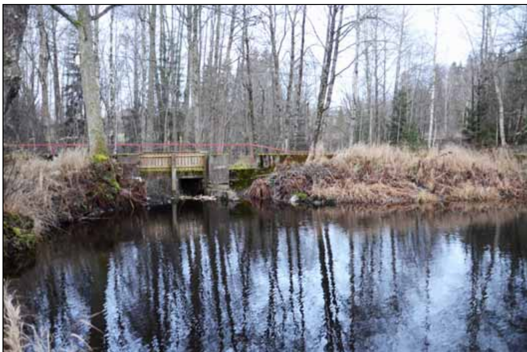
Figur 367. Uppströms tegelbruksdammen. Foto mot söder.
