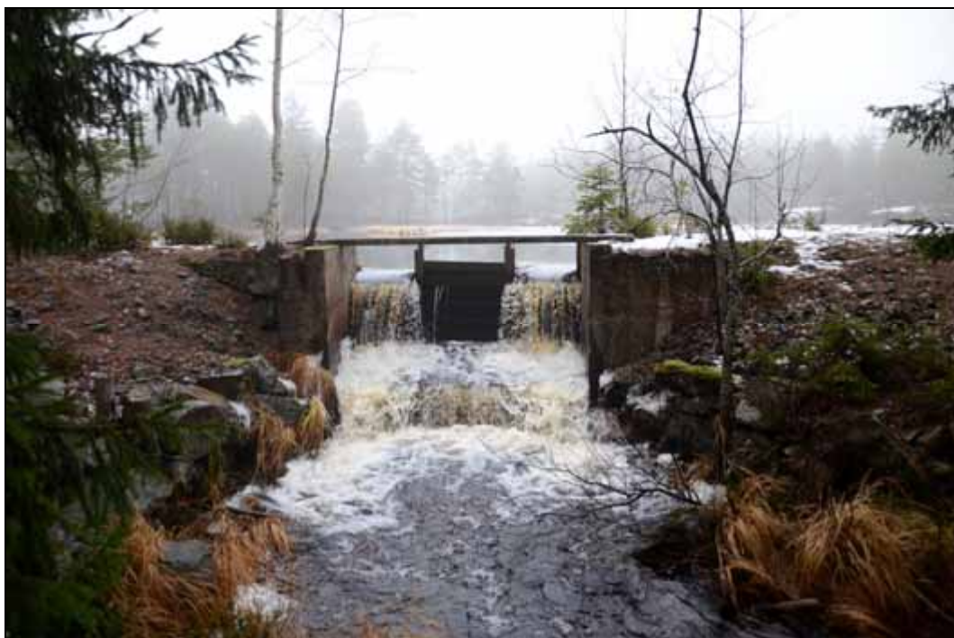
Figur 135. Utskov vid Övre Skärsjöns södra utlopp (objekt 2). Foto mot norr.
