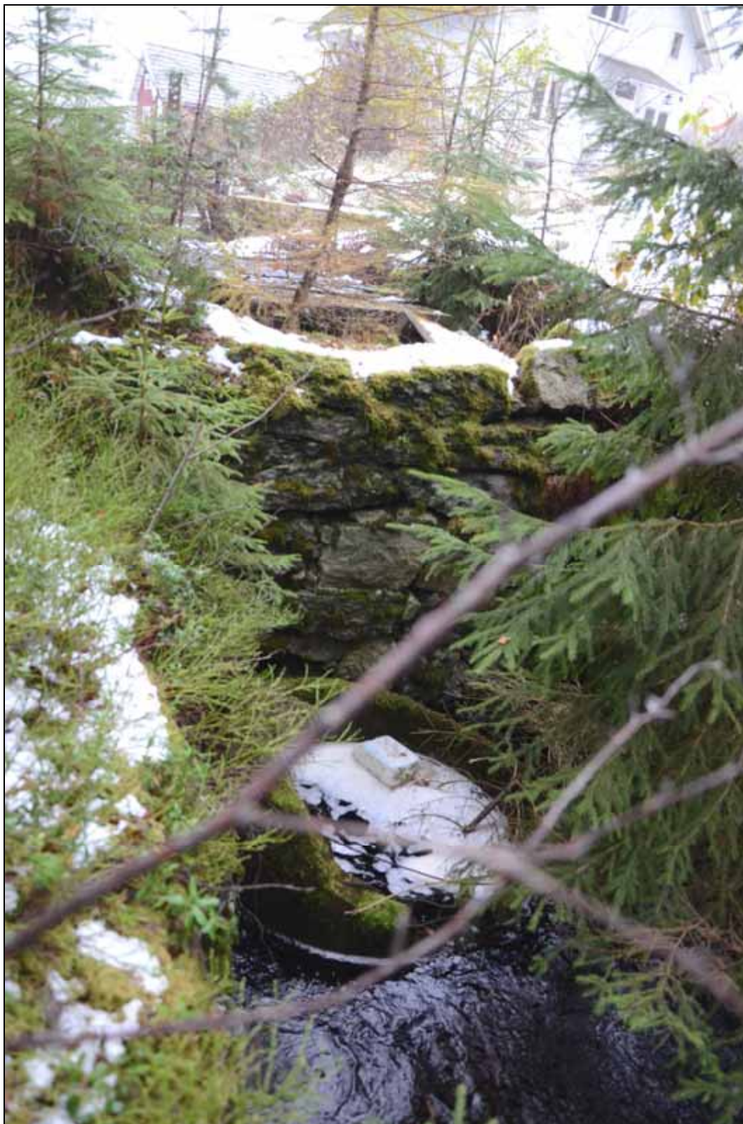
Figur 145. Kallmurat dämme i Persgruvviken. Grävd gruvkanal för processvatten till Bäckegruvan. Foto mot norr.
