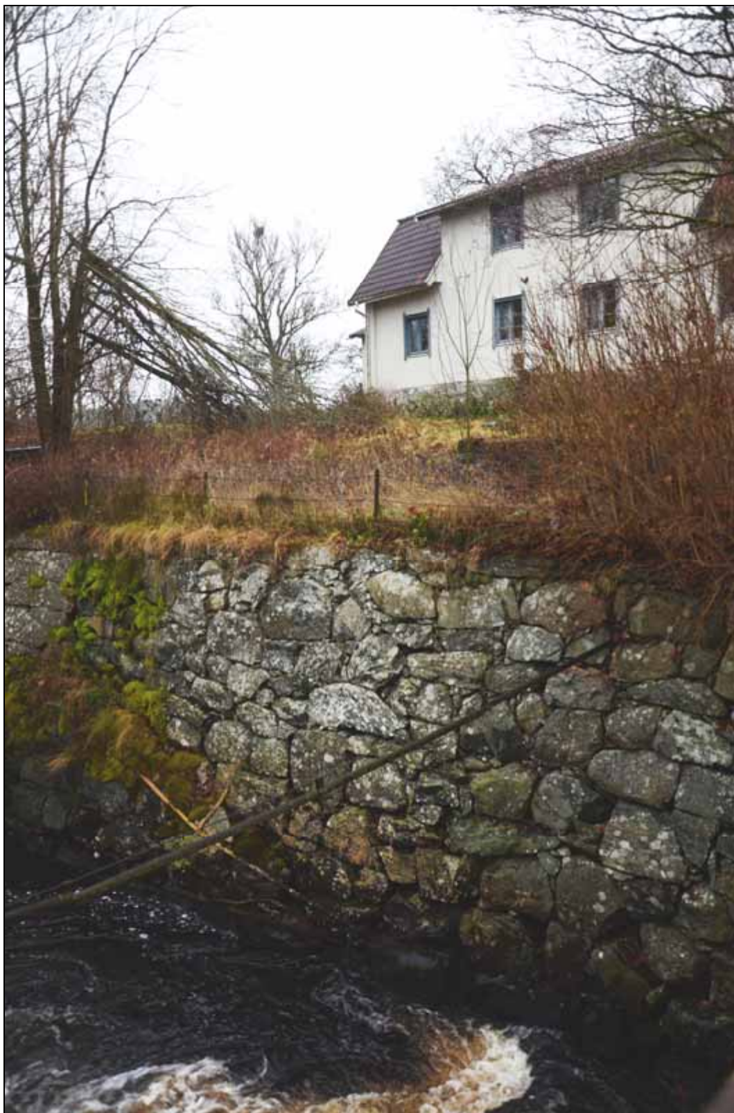
Figur 334. Detalj av kallmurad del av hammarområdet. Foto mot sydväst.
