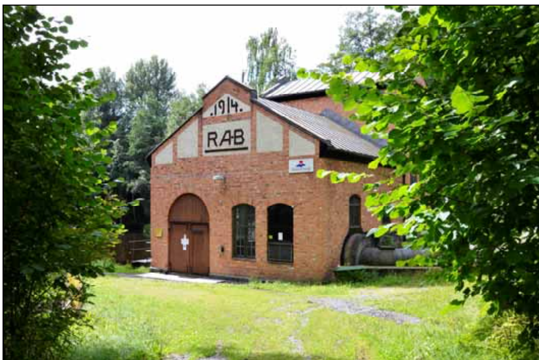
Figur 362. Gisslarbo kraftverksbyggnad. Anläggningen anlades 1914 i samband med att den övre hammarsmedjan moderniserades. Foto mot söder.
