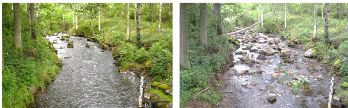
Figur 3. Till vänster rensad sträcka i Sågkvarnsbäcken och till höger efter genomförd restaurering.
