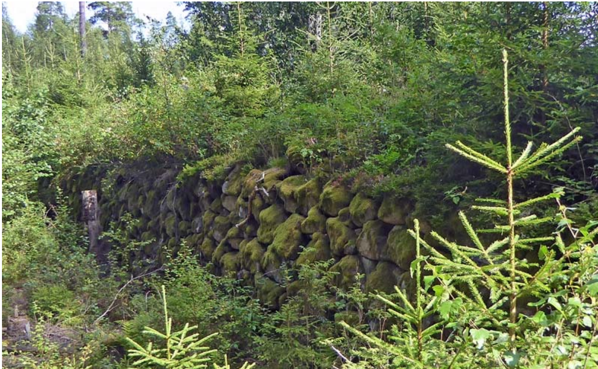
Figur 17. Norra Härsåsedammen som består av en stadig stenskodd vall som är välbevuxen med mindre granar och sly. Foto från SV.
