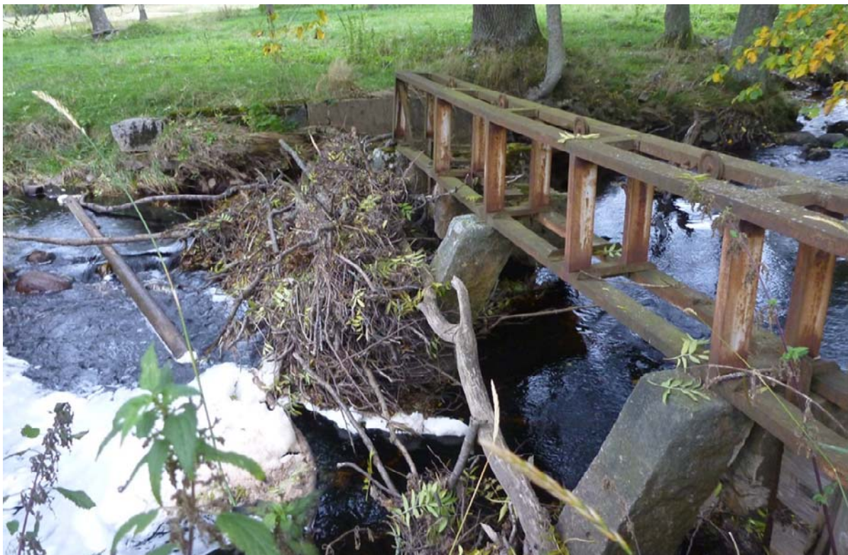
Figur 7. Det raserade utskovet där bråte samlas vid stenpelarna. Foto från NÖ.
