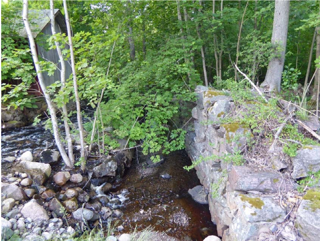
Figur 25. Till höger i bild syns fundament till såg och framför detta är resterna efter hjulgraven. Till vänster bakom slyn skymtar förrådsbyggnaden som står i direkt anslutning till åfåran. Foto från NNÖ.
