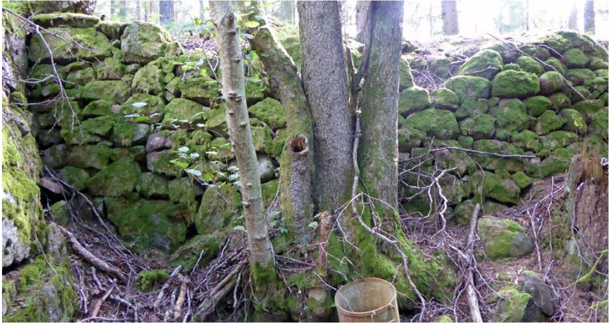
Figur 33. Östra kanten på bäckravinen är stensatt, dammvallen skymtar till vänster i bild. Foto taget från V.
