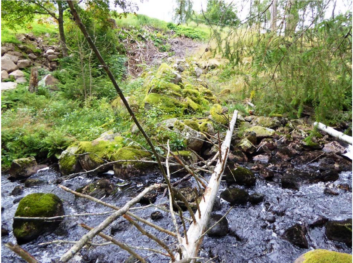
Figur 40. Den raserade äldre Anderstorpsdammen. Den östra sidan som idag är delvis kallmurad. Foto från V.
