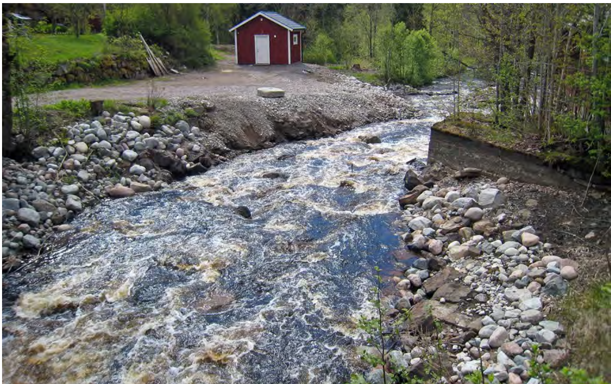
Figur 28. Vy från bron vid Utterbäck. Före och efter dammutrivning och rivning av kraftverk/kvarn. Foto från NV. Fotograf översta fotot: Peter Ström, länsstyrelsen.
