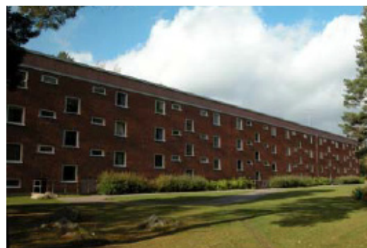
Saltängen som ligger väster om Laxå planerades och uppfördes 1962-72. Nedskaeringar på ESAB redan under byggtiden gjorde att bostäder stod tomma redan från starten. Rivning av hus inleddes redan 1987 och av de ursprungliga tjugofem flerbostadshusen kvarstår bara tolv.
