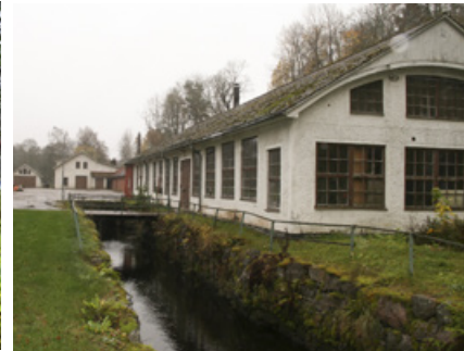
Lokstallarna och förrådsbyggnader i bruksområdet
