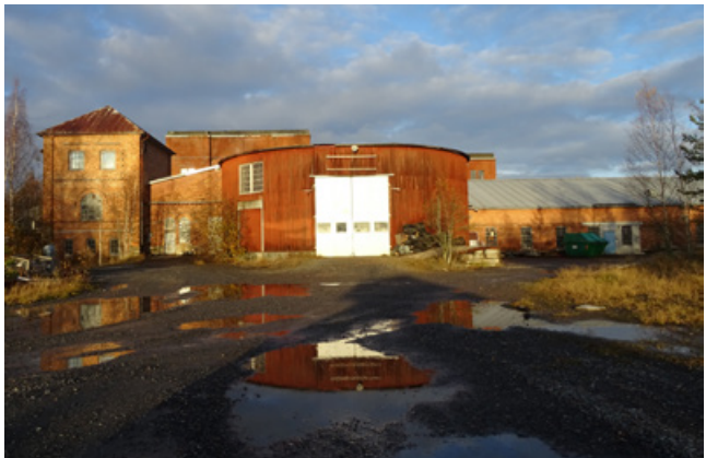
Den belgiskinspirerade tegelarkitekturen präglar Åmmebergs industribyggnader
