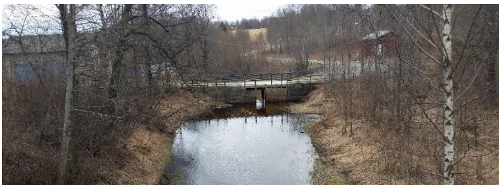
Bild 4. Uppströms branddammen innan åtgärd. Foto: Länsstyrelsen Örebro.
