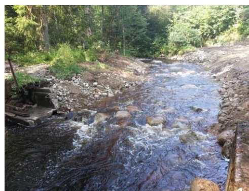
Bild 9. Platsen för den mindre dammen uppströms Kronohyttan efter åtgärd. Foto: Länsstyrelsen Örebro.
