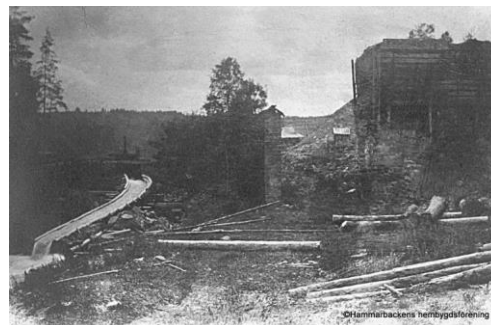
Bild 27. Den delvis rivna masugnen och flottningsrännan vid Gränsjöns utlopp, Hammarbacken. År 1912. Foto: Hammarbacken Hembygdsförening.
