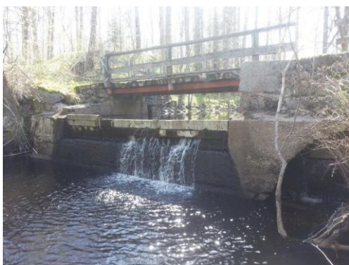
Bild 6. Herrgårdsdammen innan åtgärd. Foto: Länsstyrelsen Örebro.
