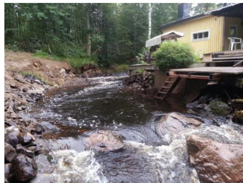
Bild 11. Konsttorpets damm efter åtgärd. Foto: Länsstyrelsen Örebro.
