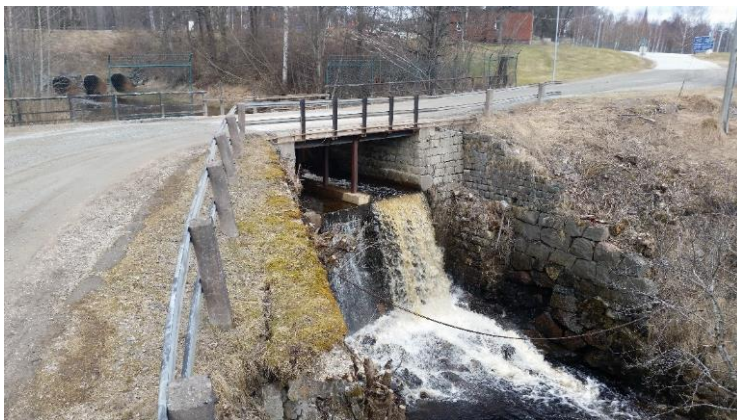
Bild 3. Branddammen innan åtgärd. Foto: Länsstyrelsen Örebro.
