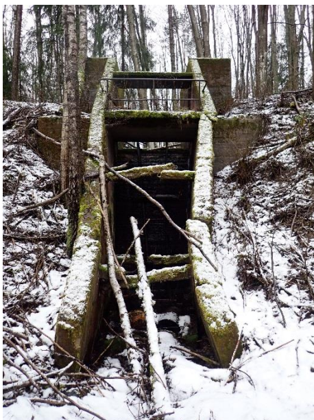
Bild 15. Dammkonstruktion med skibord strax öster om Norra hammarskogen.
