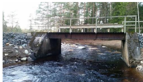
Bild 22. Dammen vid Gränstjärn efter åtgärd. Foto: Länsstyrelsen Örebro.
