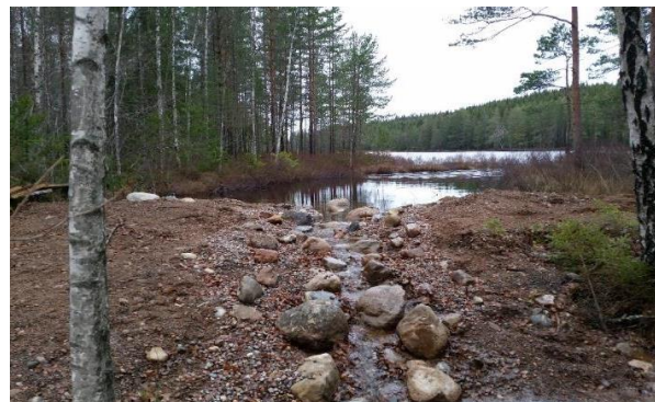
Bild 36. Utlopp vid Acksjön efter åtgärd. Foto: Länsstyrelsen Örebro.
