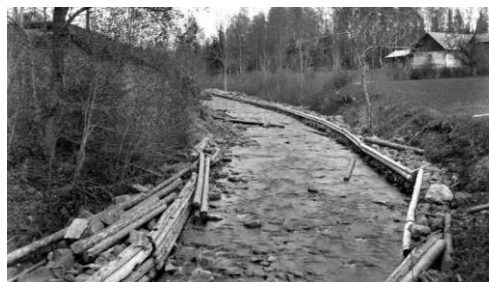
Bild 42. Erosionsskydd/ledarmar längst med sträckan av Hammarskogsån som rinner förbi Danshyttan, sträckan benämns Danshytteån. De ur ån bortrensade blocken och stenarna ligger längs med kanten. Foto: Hammarbackens Hembygd sförening.
