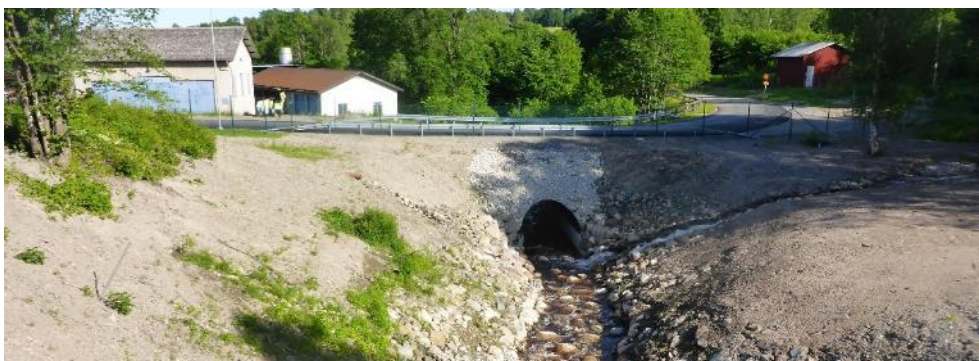
Bild 5. Uppströms branddammen efter åtgärd. Foto: Länsstyrelsen Örebro.
