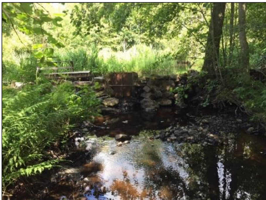
Anlagd bastudamm, som utgör vandringshinder för fisk, i den nedre delen av Emmesån.
