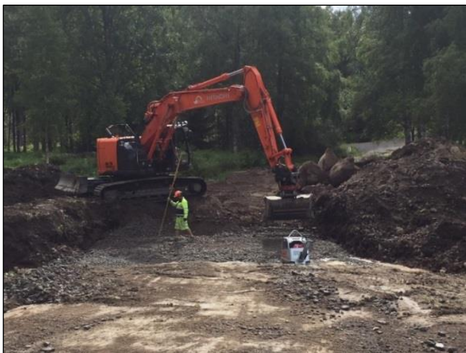
Dammen vid Dammsjön rivs och kommer att ersättas med ett naturligt sjöutlopp.
