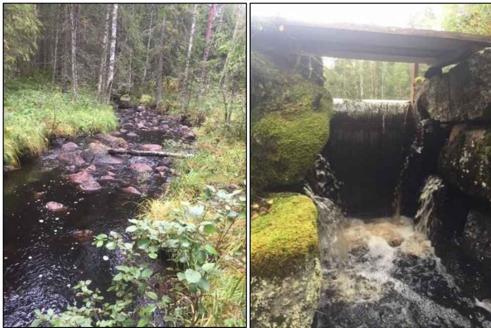
Strömsträcka i övre delen av Hemmansbäcken samt dämme vid damm nedströms Vargdammen.
