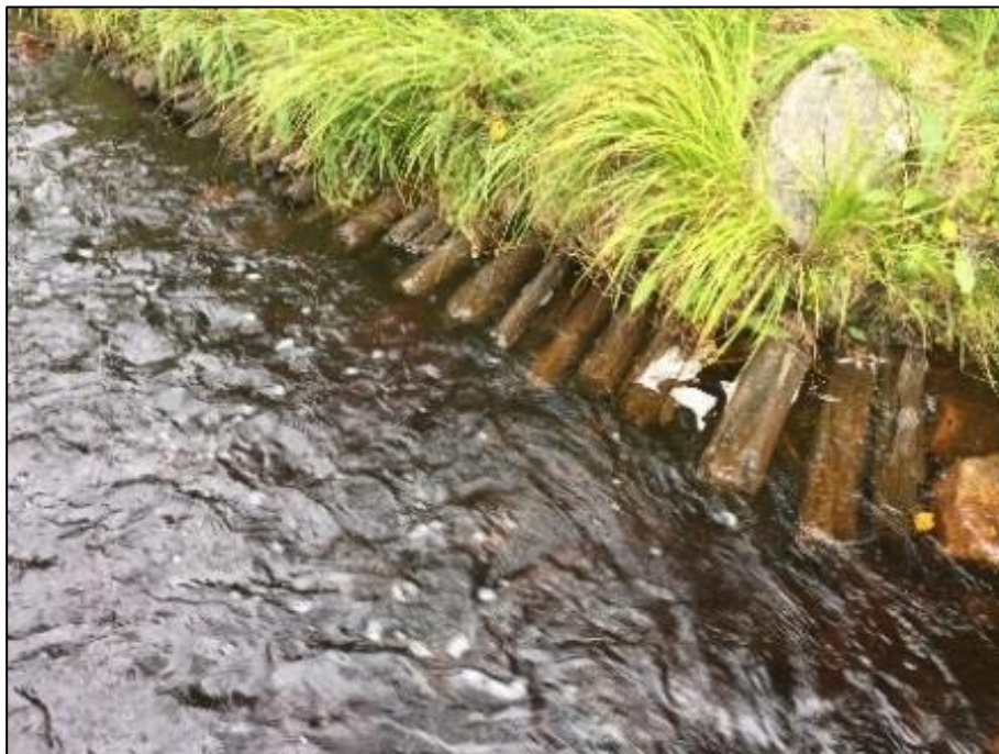
Lämningar efter flottningen syns på flera ställen i Sandån
