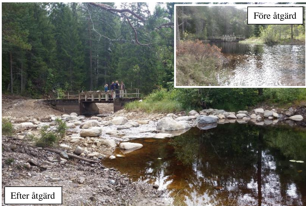
Figur 2. Vattenvårdsåtgärd där en sjöträskel byggts vid en naturlig sjö (Arbogaåns vattensystem).
