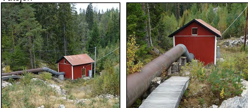
Figur 234. Våtsjön. Elproduktionen startade år 1916 där tidigare kvarnen stått. År 2015 upprustades området då en ny damm, nytt turbinrör och ett omlöp byggdes. Fortfarande i drift.
