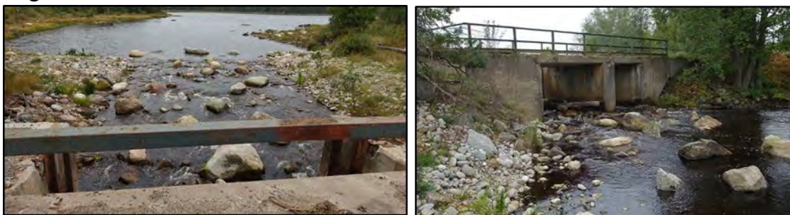
Figur 30. Damm 172, Angsjön är numera åtgärdad så att vattnet kan forsa fritt under vägbron.
