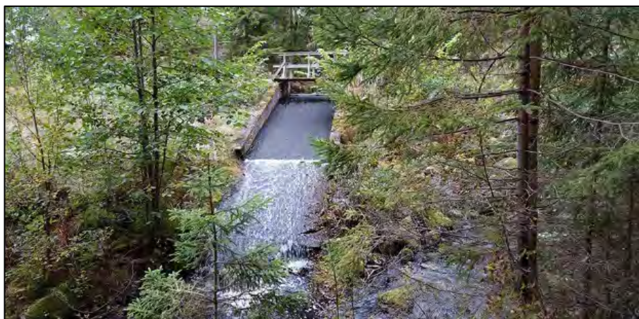
Figur 6. Damm 211, Granbergsdalstorps damm som varit verksdamm till en kvarn.
