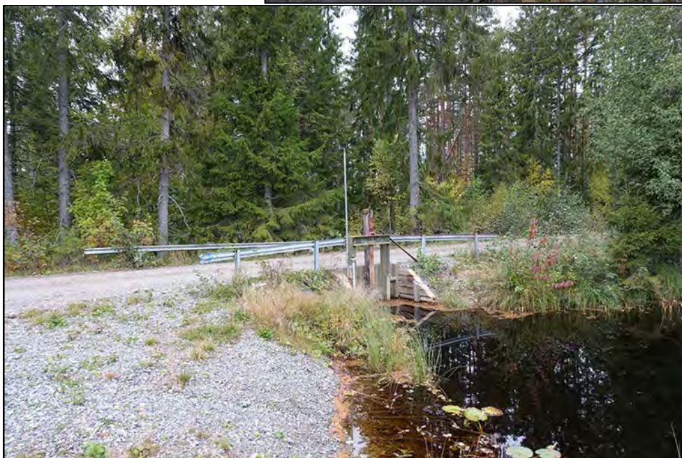
Figur 29. Damm 387, Småsjöarna är en hålldamm till Örlings kraftverk. På tidigt 1800-tal fanns här en verksdamm till en kvarn.
