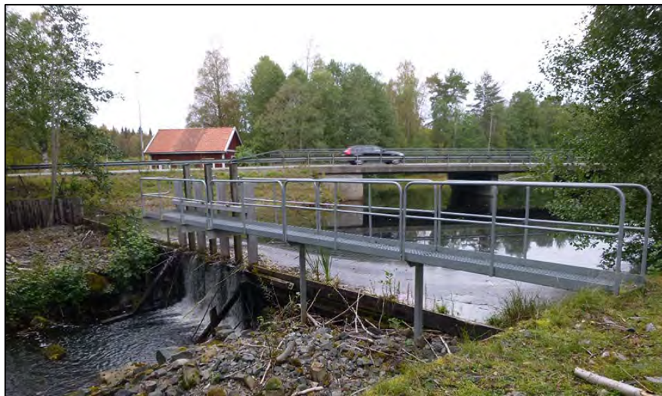
Figur 26. Damm 351, Sikfors spgeldamm är relativt nygjord/renoverad.
