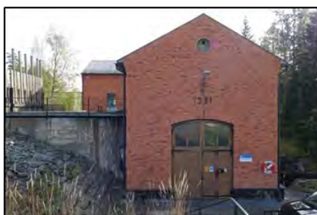
Figur 220. Västgöthyttfors II. Grupp 2B, byggt år 1921 – Tekniska Museet, TEKA0091126. I samband med att kraftverket byggdes gjordes en stor förändring i landskapet. En ny kanal grävdes på Östra Lövnäs mark, där kraftverket byggdes i rött tegel och placerades på mitten av kanalen. Dammkroppen vid den norra änden av kanalen höll på att byggas om hösten 2019. Fortfarande i bruk.
