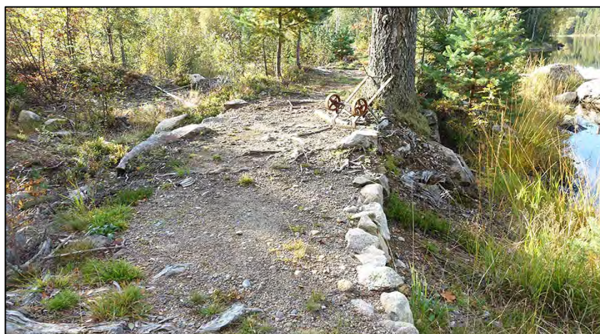
Figur 11. Damm 50, Flydammen var en regleringsdamm till Skagersholms bruk och/eller Finnerödja kvarn och såg. Den ligger i skogen långt från verksdammarna.
