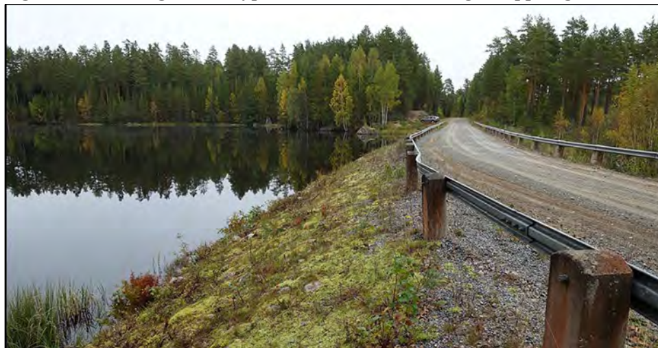
Figur 17. Damm 568, Vintersjön-Flaxen, spärrdamm syd. Det är inte helt uppenbart att detta är en spärrdamm då en väg finns på dess ovasida.
