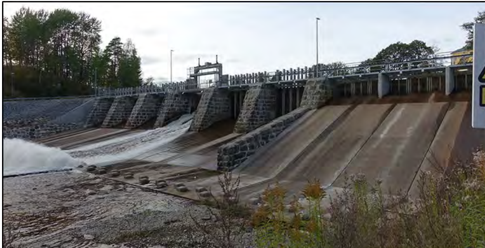
Figur 25. Damm 467, Torrvarpen Floddamm (Älvestorp).
