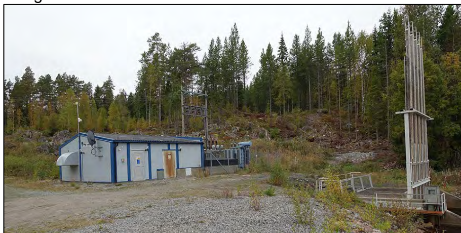
Figur 230. Mången. Byggt mellan år 1958 och 1987. Vattnet leds under mark mellan verksdammen och kraftverk. Fortfarande i drift.
