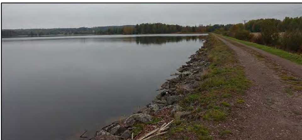
Figur 20. Damm 469, Åtorp spärrdamm. Här är spärrdammens funktion att förhindra att vattnet tar fel väg och svämmas över betesmarken som är strax intill.
