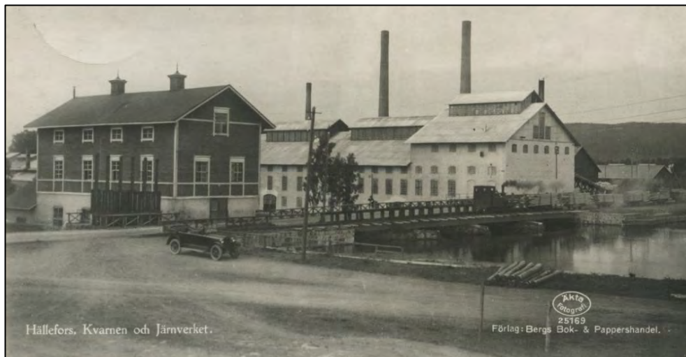
Figur 153. Hällefors såg och kvarn. Fotot är taget cirka 1920, byggnaden till vänster är kvarnen. Foto: Järnvägsmuseet JvmKCAC07138.
