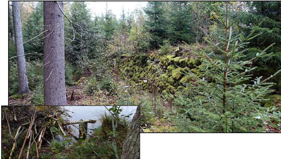
Figur 21. Damm 461, Härsåsdammen kan ses som en spärrdamm. Dess uppgift var att hålla vattnet samt att förhindra att det rann ut i bäcken till Kvarntorpet. Det har funnits någon slags utskov. Vattnet behövdes för att driva Skagersholms bruk. Denna variant är en skalmursdamm med stenmurar på vatten- och luftsidorna och tätmaterial däremellan.
