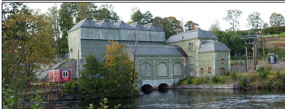
Figur 213. Älvestorp II, byggt 1906. Vykortet är från år 1915, alvestorp.weebly.com . Dagens byggnad är delvis ombyggd, tillbyggd samt har ändrat färg. Fortfarande i bruk.
