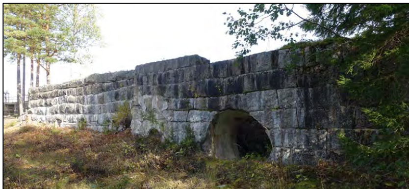
Figur 209. Västgöthyttfors I. Byggt i slutet av 1890-talet och är ett av länets första vattenkraftverk. Det var då den första större vattenregleringen skedde på platsen. Den kallmurade grunden finns fortfarande kvar (L1980:2100). Var i bruk fram till år 1921 då Västgöthyttfors II togs i bruk.
