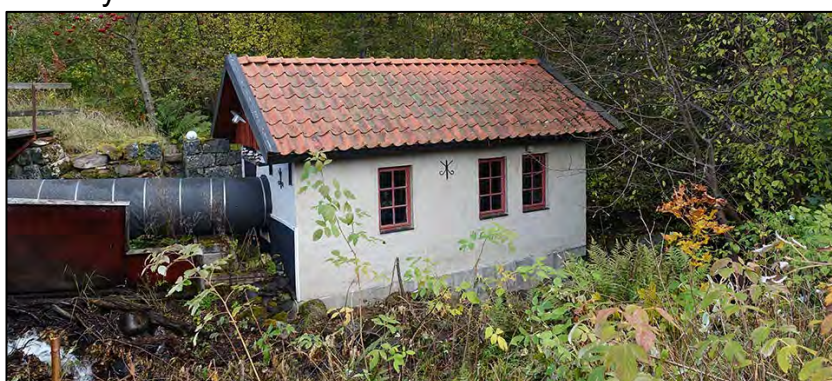
Figur 232. Silverhyttan. I drift från cirka år 2005. Ligger på ungefär samma plats där hyttan/masugnen har legat. Byggnaden är äldre vilket ankarsluten på fasaden visar. Kan ha funnits en föregångare från första hälften av 1900-talet.
