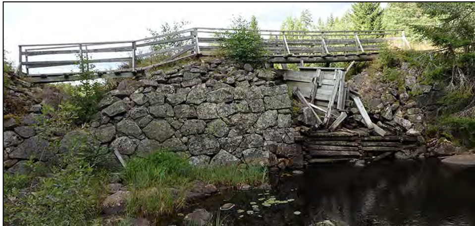
Figur 16. Damm 389, Hänglandstjärnen. En flottningsränna av trä har funnits i dammöppningen. Det går att ana ankarsluten på båda sidorna om timmerlådan.
