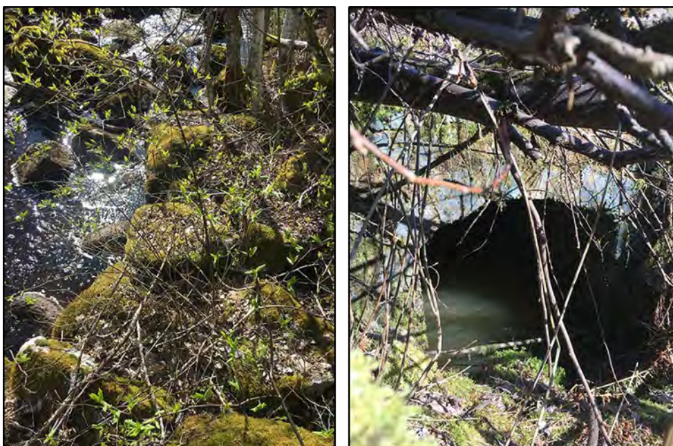
Figur 181. Foto över grund och valv vid turbinhuset. Foto Maria Waldebrink.
