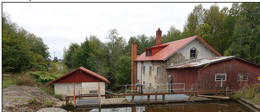
Figur 231. Lonnhyttan. Byggt efter år 1987. Kraftstationen är byggnaden till vänster. Fortfarande i drift.
