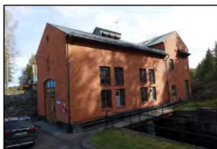
Figur 220. Västgöthyttfors II. Grupp 2B, byggt år 1921 – Tekniska Museet, TEKA0091126. I samband med att kraftverket byggdes gjordes en stor förändring i landskapet. En ny kanal grävdes på Östra Lövnäs mark, där kraftverket byggdes i rött tegel och placerades på mitten av kanalen. Dammkroppen vid den norra änden av kanalen höll på att byggas om hösten 2019. Fortfarande i bruk.
