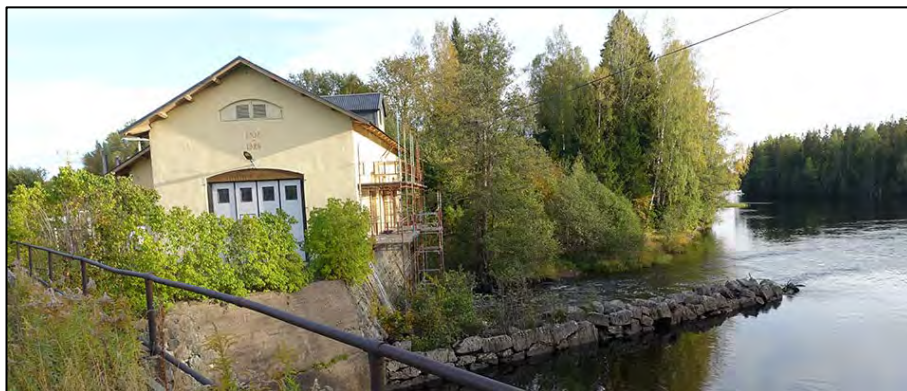
Figur 212. Hammarn. Grupp 5A, byggt år 1902 och ombyggt år 1926. Den sydvästra långsidan renoverades år 2019. Fortfarande i bruk.
