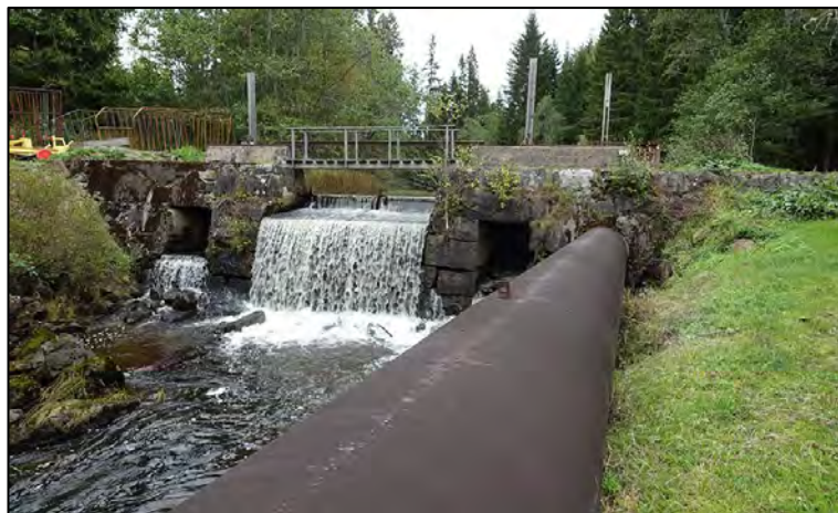
Figur 10. Damm 229, Stockforsen (Kvarndammen), även här leds vattnet in ett turbinrör som går till ett mindre kraftverk
