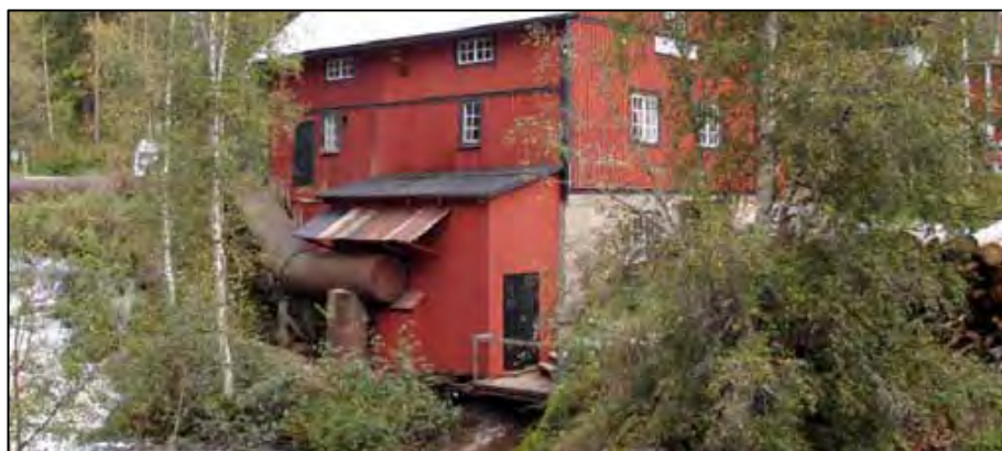
Figur 229. Stockforsen, togs i drift år 1983. Turbinröret till dammen är en industriskorsten. Byggnaden intill är en kvarn. Foto Olof Pettersson.
