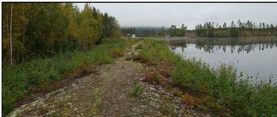
Figur 18. Damm 569, Vintersjön-Flaxen, spärrdamm norr.
