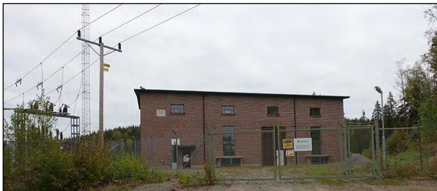
Figur 225. Brattforsen II. Grupp 5B, byggt år 1941. Brattforsens nya kraftverk är förlagd 20 meter under jordytan. Kraftverkets turbiner levererar 10 000 hk. Fortfarande i bruk.
