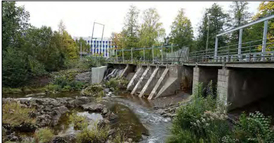
Figur 5. Damm 184, Bofors kraftverksdamm
