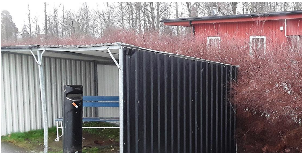
Vindskydd med askkopp i anslutning till skolgård.
