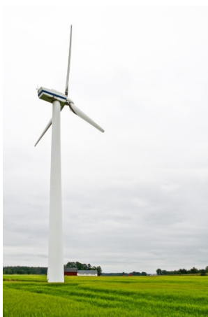
Vindkraftverk utanför Örebro. Foto: Mostphotos
