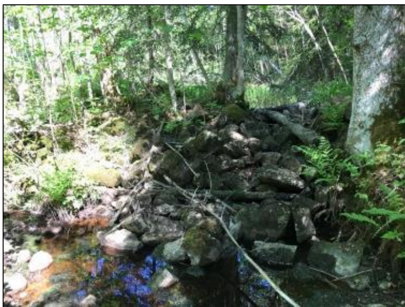
Figur 73. Delvis raserat stendämme.
