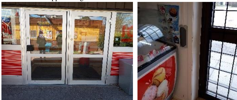
Bilden t.v. visar en entrédörr med stora omarkerade glasytor. Den har inte någon svepyta framför. Bilden t.h. visar ett manöverdon som sitter väldigt illa till för personer i rullstol. Placeringen av manöverdonet kan också var svår att upptäcka.
