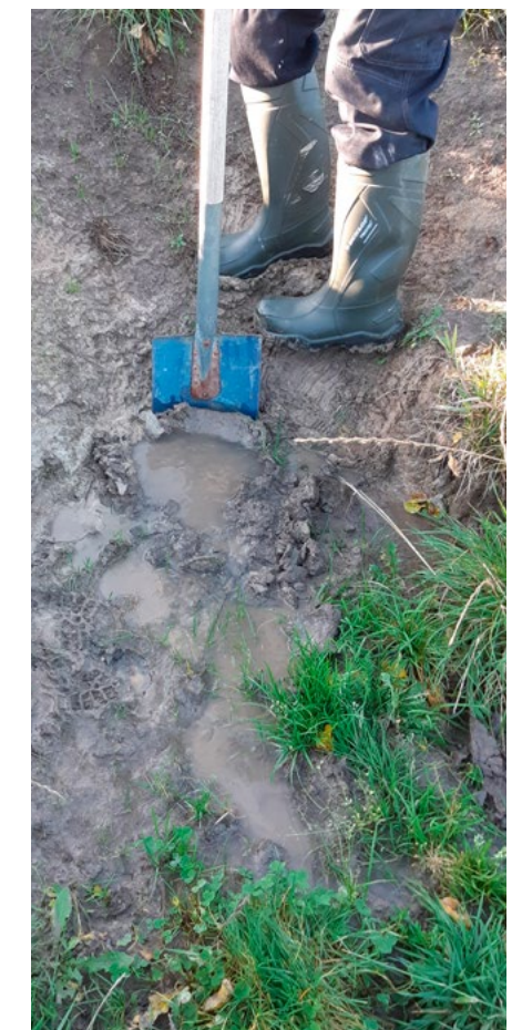
Bild 4: Vatten som tyder på att kulverten läcker. Spola kulvertar så att det blir ett bra flöde.
