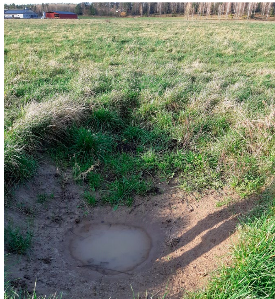
Bild 1: Här har ett täckdikesöga rasat. Genom att laga det så kan vattnet rinna fritt igen.
