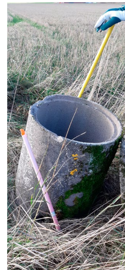
Bild 3: Se över alla brunnar så att de inte är fyllda med slam. Laga de som är trasiga.
