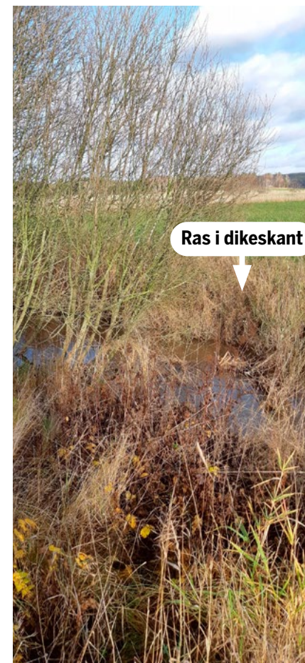
Bild 2: Håll undan sly och buskar för att inte underminera diken.
