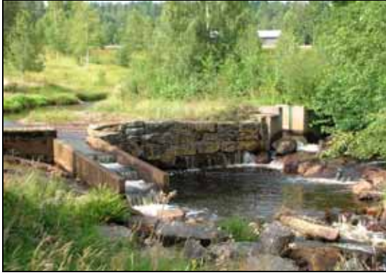
Figur 10. Fisktrappa som byggts förbi en gammal damm vilken tidigare utgjort ett definitivt vandringshinder.
