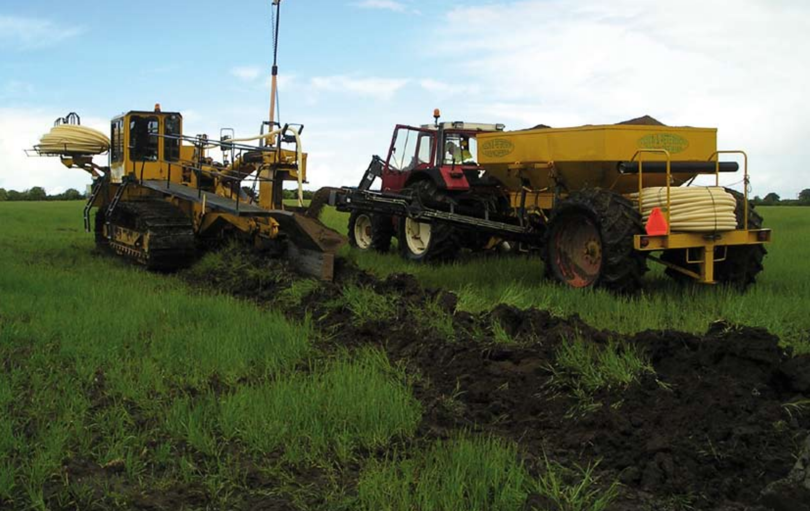
Nydikning med täckningsplog.
