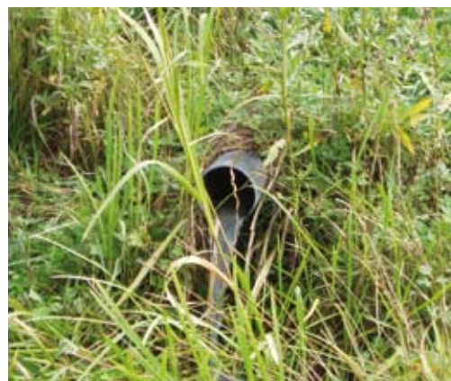
Dikesögon ska vara fria från igenväxning och mynna en bit ovanför vattenytan.
