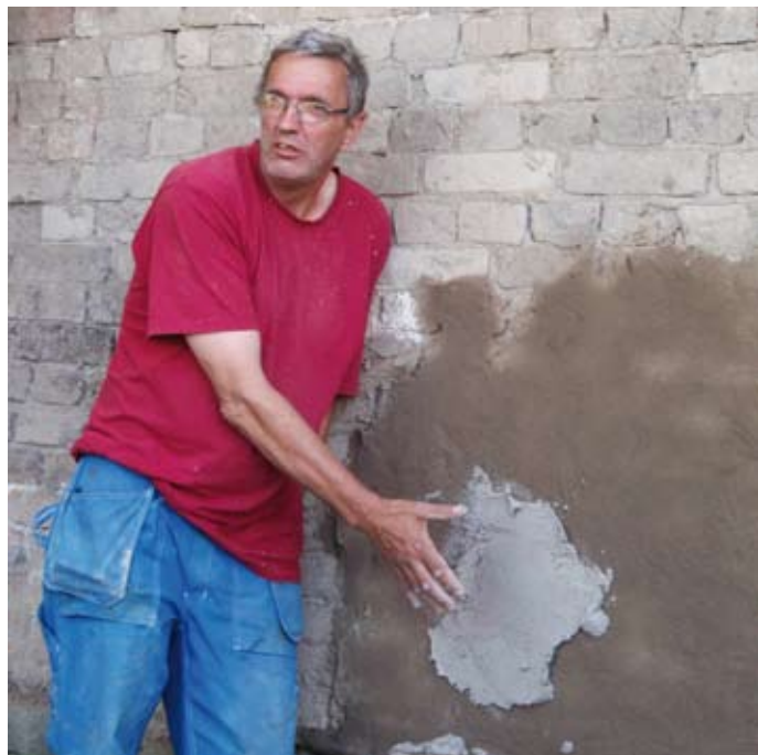
Kurslärare Per Zackrisson förklarar de olika materialens egenskaper. Vi använder oss av de traditionella materialen kalkbruk och lerbruk, samt kalkputs och lerputs.
