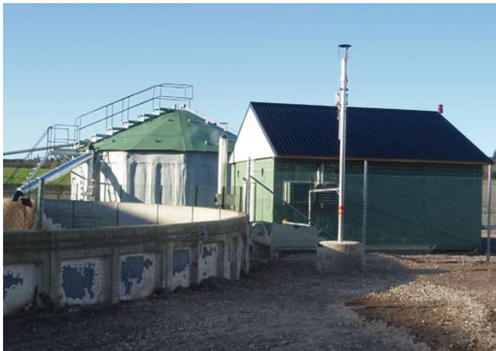
Nyanlagd biogasanläggning på Högebo gård, Hällekis som har svinproduktion. Förväntad årsproduktion är drygt 50 000 kbm gas.
