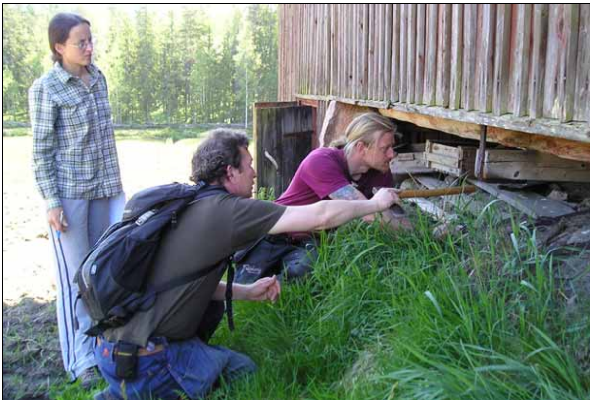
Pågående fältbesök vid Snåret, Böckelshöjden i Nyeds sn i juni 2009. Timmerman Robert Lindgren diskuterar åtgärdsbehovet på en av byggnaderna som beviljats miljöinvestering, tillsammans med husägarna.
