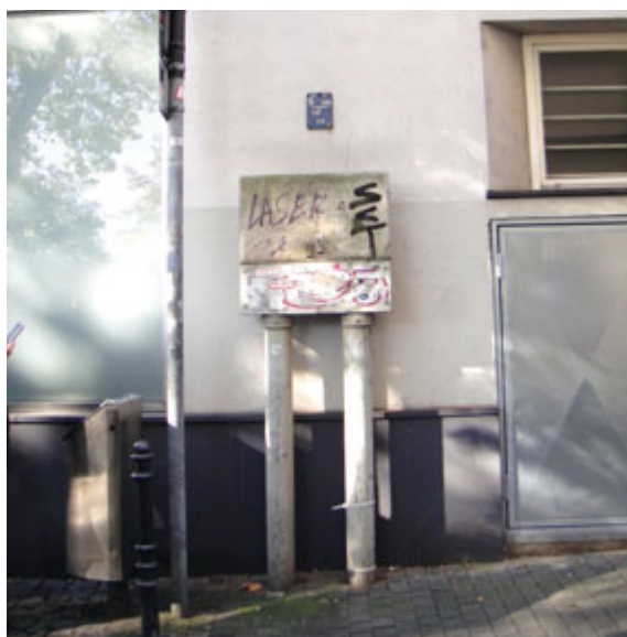
Figur 43. Översvämningssanpassat elskåp – Köln, Tyskland.
