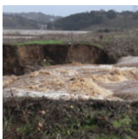
Figur 17. Brott i jordvall vid extremt högt flöde.
