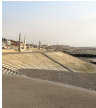
Figur 39. Mångfunktionellt översvämningskydd i Cleveleys – Lancashire, UK.
