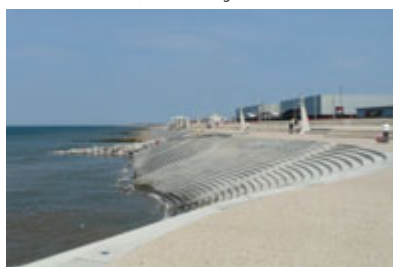
Figur 119. Mångfunktionellt översvämningskydd i Cleveleys – Lancashire, UK.
