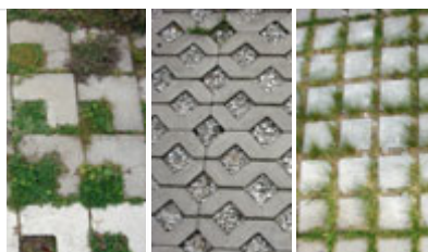
Figur 97. Genomsläpplig markbeläggning, Malmö.
