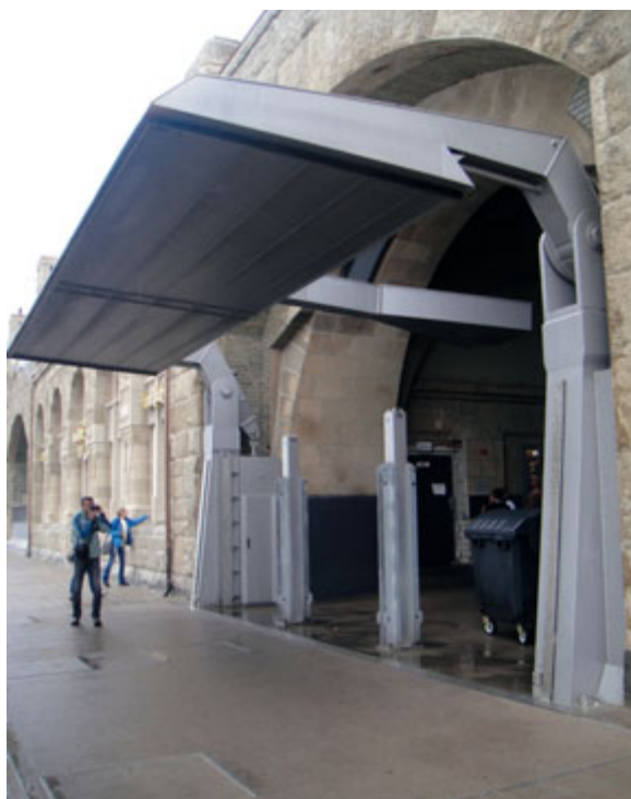
Figur 50. Tillfälligt skydd i stadsmuren i Hamburg, Tyskland.
