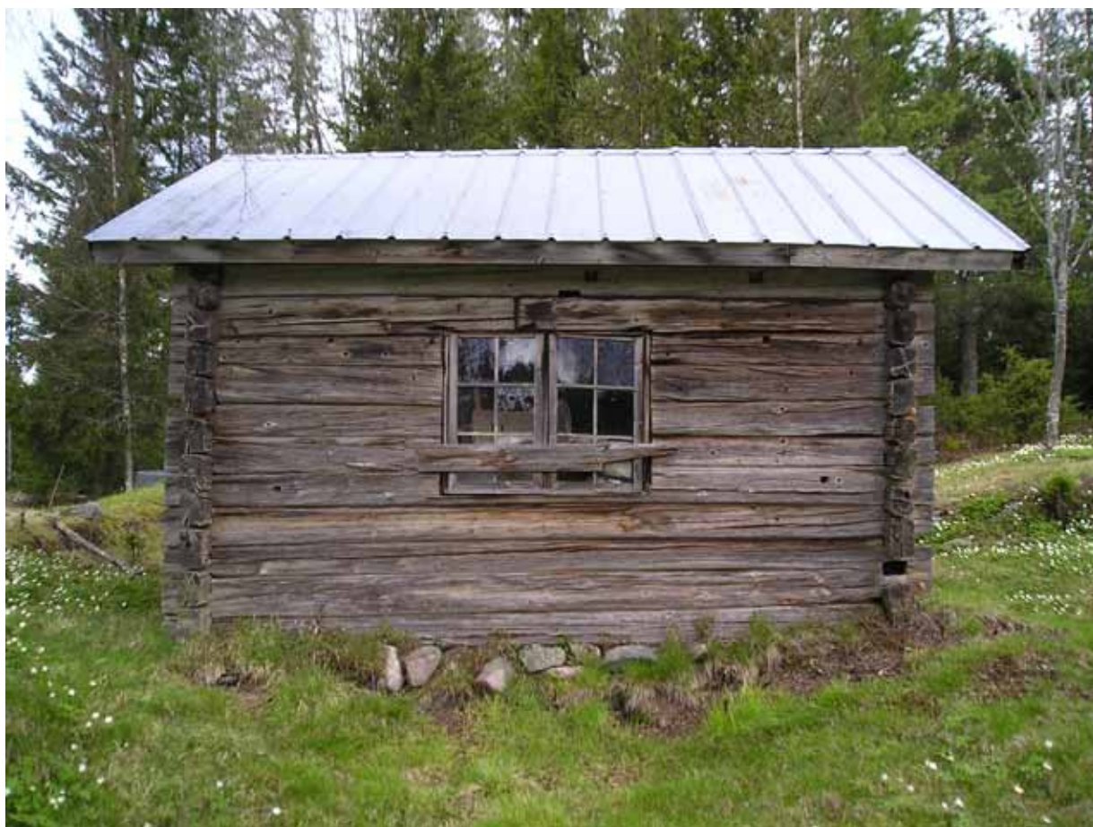
Pannplåt, ett enkelt och relativt billigt sätt att bevara en byggnad många år till.
