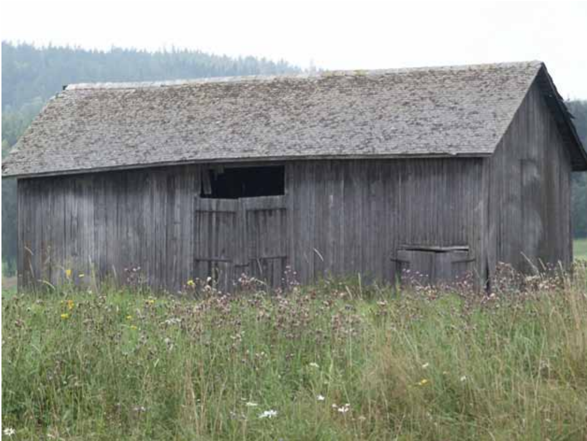
Lada vid Fjäll i Glava, brädklädd regelverkskonstruktion och skiffertak, troligen tidigt 1900-tal.
