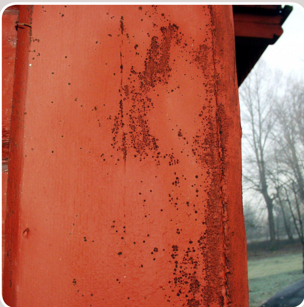
Svartmögel på fasad, Foto: MYCOTEAM
