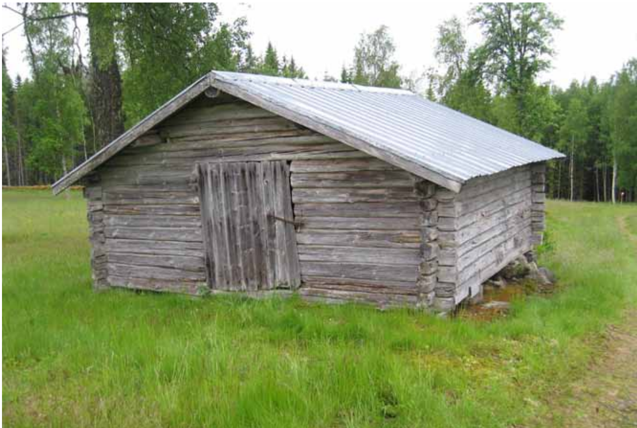
Lada på Åstrandssättern. Tack vare ett helt plåttak har den klarat sig länge efter att den slutade användas.
