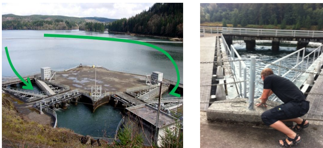
Figur 25. Vänster, Louvers vid Mayfield Dam. I vattnet i mitten är fisken redan avledd och allt vatten går vidare till turbinerna. Höger, Stefan S specialstuderar utloppspipen från den ena louvern.
