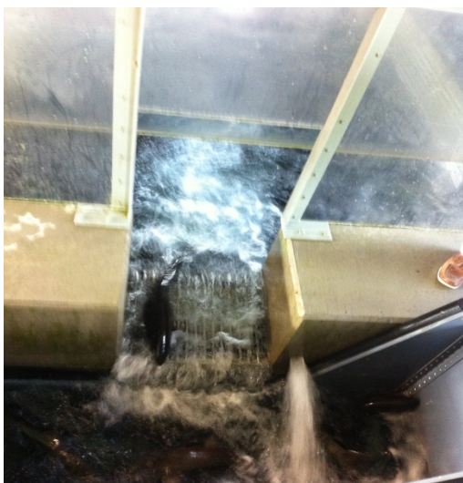
Figur 22. Ett s.k. "False Weir" lockar upp fisken från fisktrappan och in i odlingsanläggningen utan manuell hantering.
