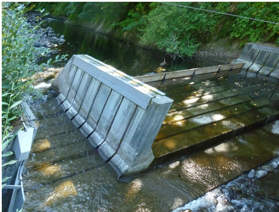
Figur 6. En elektrisk barriär i Eagle Creek i anslutning till en fiskodlings- och sorteringsanläggning. Nedströms denna barriär finns en fiskväg som leder till anläggningen. Vid lågvatten (som det var vid detta tillfälle) flödar vatten endast i den vänstra delen, vilket gör att man kan minimera elförbrukningen.
