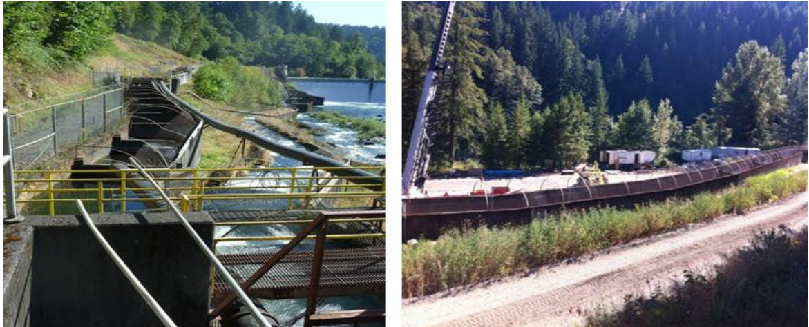
Figur 9. Uppsamlingsstation i fiskvägen i Clackamas River där fisk sorteras och räknas. Vild fisk sätts tillbaka i den 3,2 km långa fiskvägen för vidare vandring uppströms medan odlad fisk transporteras med lastbil till avelsanläggningen eller tillbaka nedströms i älven för fisketurism.
