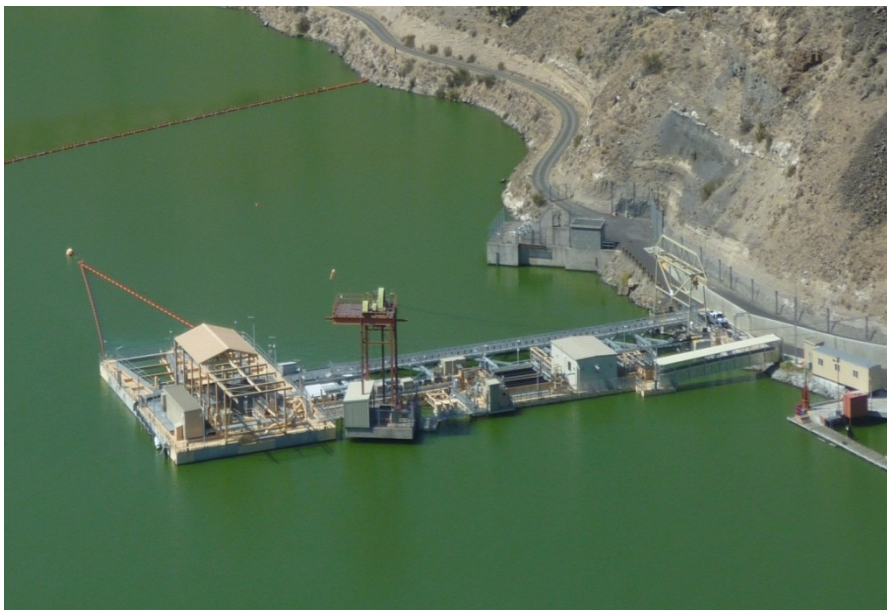
Figur 13. Smoltuppsamlingsanläggningen vid Round Butte Dam under uppförande (med tillstånd av Portland General Electric).
