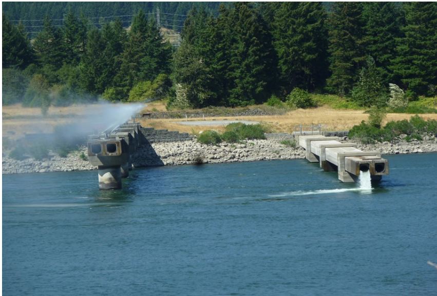
Figur 19. Smoltutsättningsrör nedströms Bonneville Dam. Vattenspridaren vid det ena röret förhindrar rovfåglar att predera på smolten vid dess återkomst till älven.
