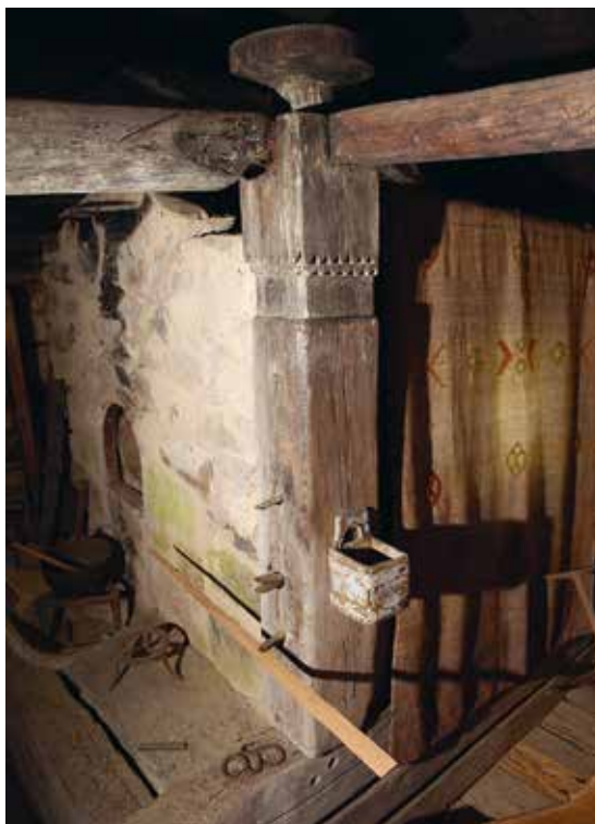
Pahastocken stöttar rökugnens stenkonstruktion. Dess avslutning upptill är täljd och har utsmyckande dekor. Få dekorativa detaljer finns i övrigt bland rökstugorna. I några finns dock en målad fris på översta stocken innan innertaket tar vid.
