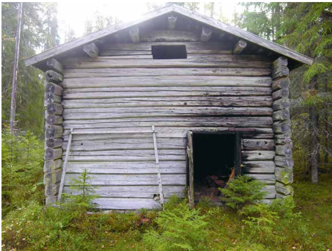
Ria belägen i östra Värmland. Det timrade vägglivet är högre än bastuns. Detta för att kärvarna ska kunna staplas på höjden inne i rian.
