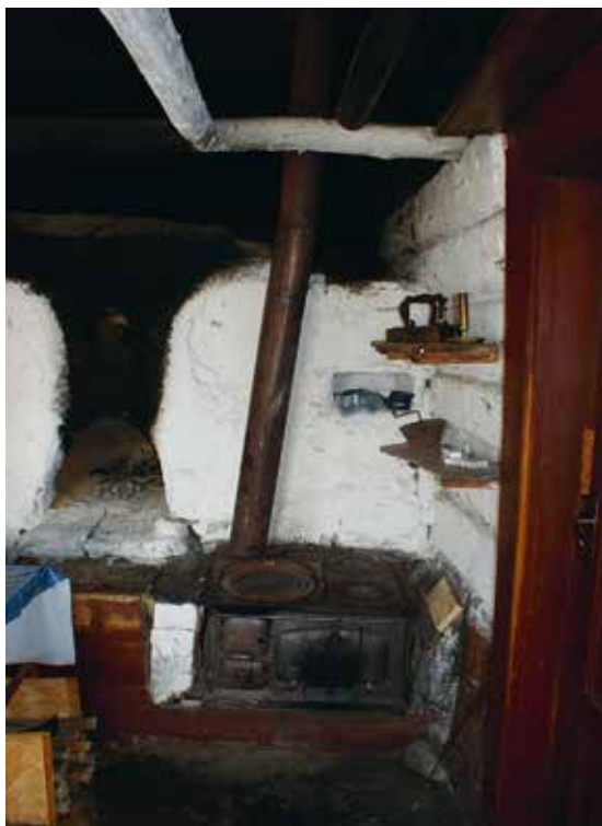
Den här rökugnen har kompletterats med en järnspis av märket Nävekvarn.
