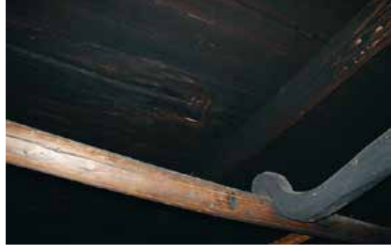
I det sotsvarta taket syns konturerna på takluckan. Skjuts den i sidled kan röken ledas ut genom en trumma gjord av trä.
