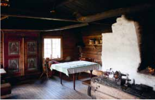
Interiör från rökstugan vid Purala finngård. Till höger rökugnen. I taket syns de grova takåsar som håller upp innertaket samt tväråsar som stöttar stommen.
