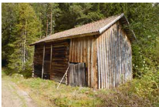
Torkria från Gräsmark. Den timrade delen är själva rian med rökugn. I den panelklädda delen av byggnaden förvarades troligen säd och lin. Rian har också använts till linberedning.
