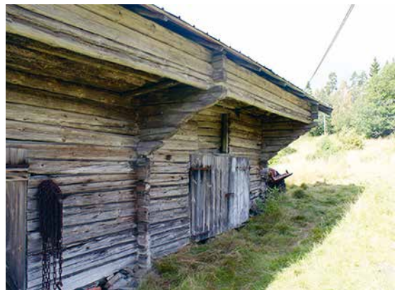
Stallängan i Gräsmark är byggd under 1700-talet och är ovanlig med sin timrade utkragning.
