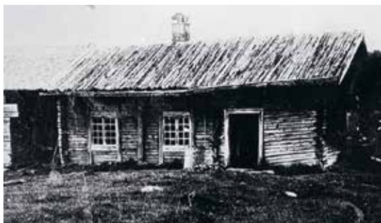
Nävertak eller farjtak som de kallas i Värmlands och Hedmarks finnskogar. Här vid rökstugan vid Ylladobba, Hollandstorp i Östmark socken. Uthuset bredvid fick dock ett tak av stickor.
