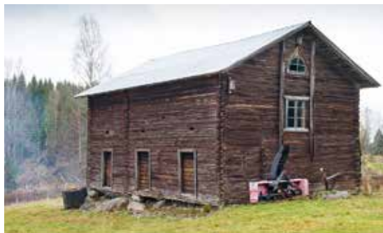
Denna bod, eller magasin som de större bodarna kallas, finns på en finngård som säkerligen haft stora skördar. Den är gediget byggd och har kostats på med ett så kallat lunettfönster i gavelröset. Ytterligare ett fönster finns i gaveln. Kanske har gårdsfolket bott där uppe om sommaren.
