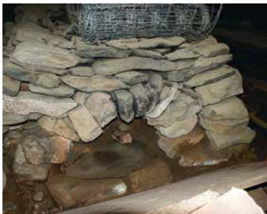
En välvd rösuugn i en bastu i Gräsmark. Här har relativt flata stenar använts till murning. Observera att inget murbruk använts.
