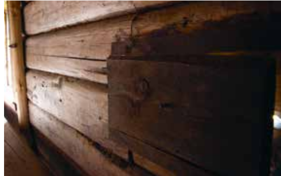
Inne i rökstugan har väggen skurats så många gånger att den blivit alldeles sammetslen. Skurningen skulle ske minst en gång om året. Längst upp mot taket är väggen sotsvart. I förgrunden syns en glugg med skjutlucka.
