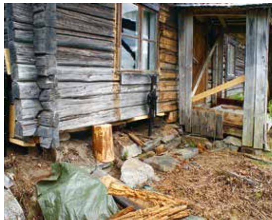
Med hjälp av en domkraft kan stommen försiktigt lyftas och den nedersta stocken, syllen, kan bytas.
