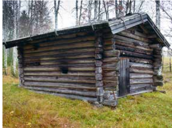
En för Finnskogen karaktäristisk bastu. Sittlaven löper ut genom ytterväggens timmer och vid de små gluggarna har röken lämnat spår i timret. Se även fotografier av bastun på sidan 29 respektive 38.
