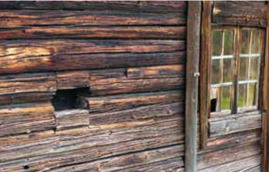
Två generationers ljustinläpp bredvid varandra. Till vänster en glugg som interiört har en skjutlucka. Till höger ett spröjsat fönster som nedtill har en liten så kallad kattlucka. Rökstugan vid Vitsands hembygdsgård.
