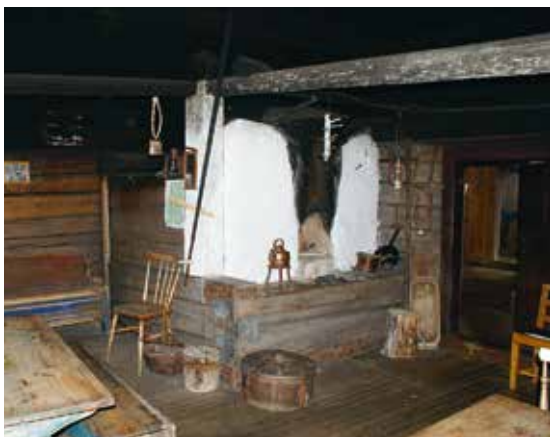
Kappugnen vid Ritämäki finngård. En timrad så kallad kista och en pahastock stödjer murverket.
