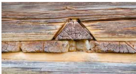
Salt från mattinorna inne i boden har gjort utfällningar på timret. Veden har lösts upp och ser närmast lite "luddig" ut.
