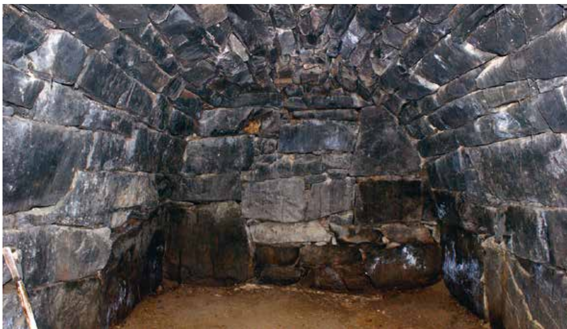
Den här jordkällaren från Lekvattnet har ett otroligt fint och välgjort stenvälv.
