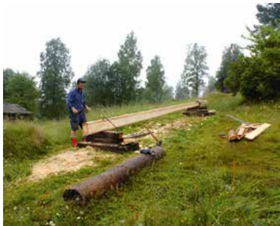
Här bilas syllstocken som skall sättas på plats.
