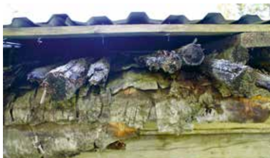
Ett farjtak har bevarats som ett tidsdokument under den nya korrugerade plåten.
