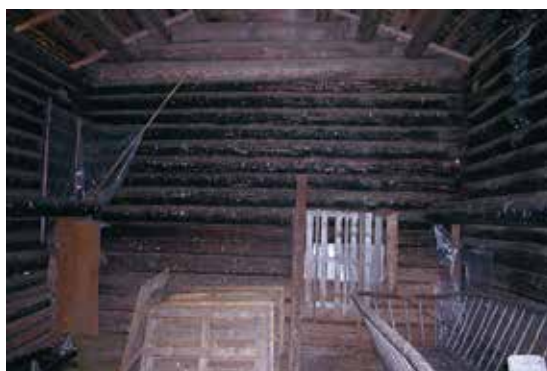
Interiör från rian ovan. I mitten längs med väggarna löper stockar mot vilka torkstänger legat. I gavelröset är inte stockarna svarta av sot vilket tyder på att ett innertak funnits.
