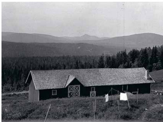
Uthuslänga belägen i Södra Finnskoga socken. Längan är byggd i en slutning. En körbro till logen krävs. Dörrarna är för bygden typiskt dekorerade. Lägg märke till att en eldstad tycks finnas.
