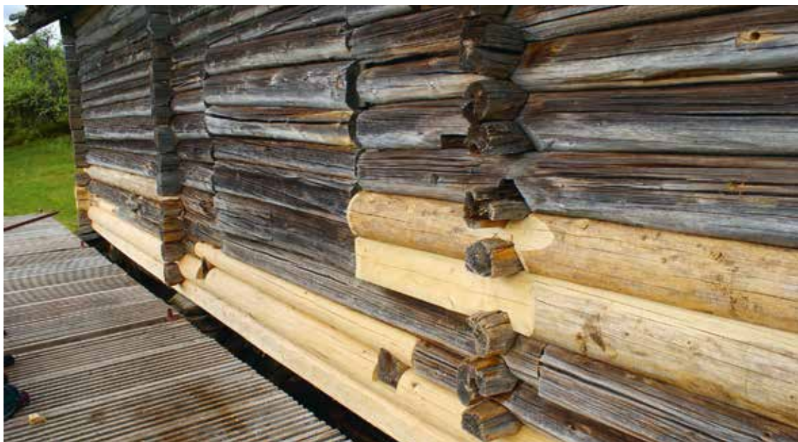
Logen står klar efter en gedigen restaurering. De nya stockarna har formats, en efter en, med de gamla som mall. Den nedersta stocken har bilats medan de längre upp har kvar sin rundning. Timret lämnas ofärgat.
