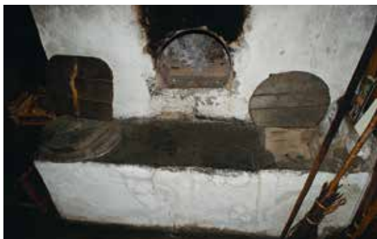
Kappugn vid Mattila finngård. Fotot visar den så kallade panken som skjuter ut framför ugnöppningen. Till höger finns en nedsänkning, den så kallade gruvan, där aska kunde rakas ned.
