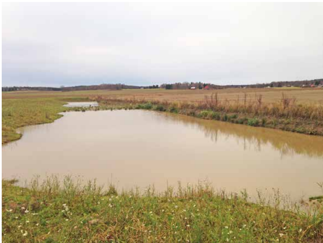
Värmlands första fosfordamm, anlagd vid Lillerudsgymnasiet utanför Karlstad.
