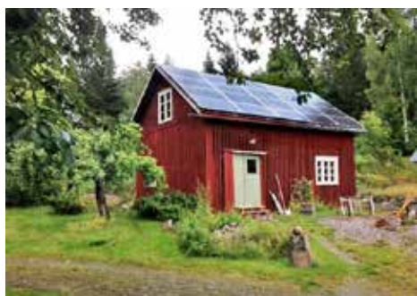
Solceller på uthuset - en härlig känsla att producera sin egen förnyelsebara energi säger ägaren Gabriella Uhrdin.
