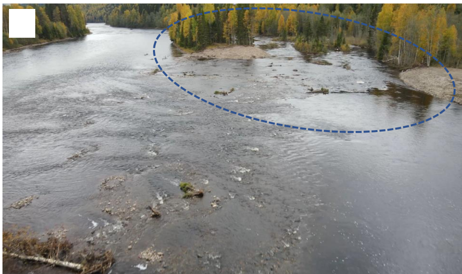
Figur 10 a, b, c. En restaurerad sträcka i höjd med Huskheden, där block, sten och lekgrus lagts ut för att ge en varierande bottenstruktur med både lekrområden och gömslen för småfisk. I och med att schaktvallen öppnades upp återuppstod även den tidigare ön och en sidogren.
