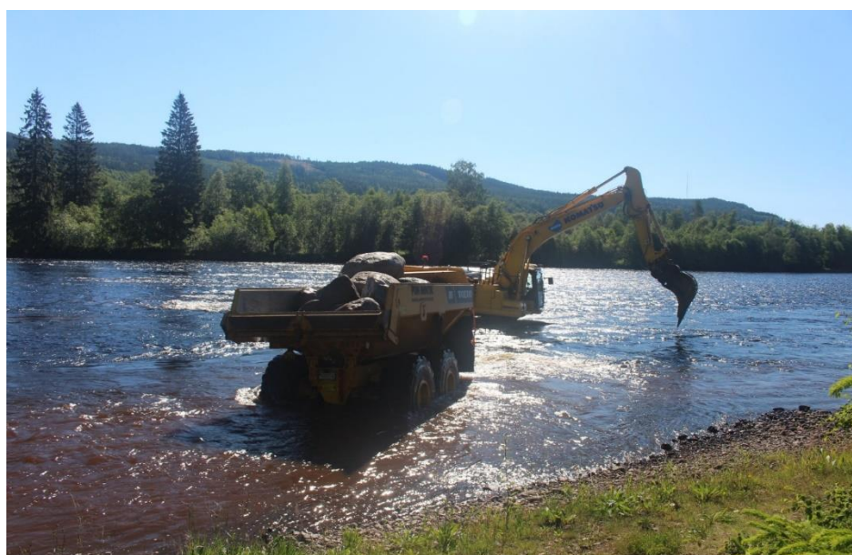
Figur 8. Maskiner i arbete med att lägga ut block på optimeringssträcka O13, vid Sundhultsmon.
