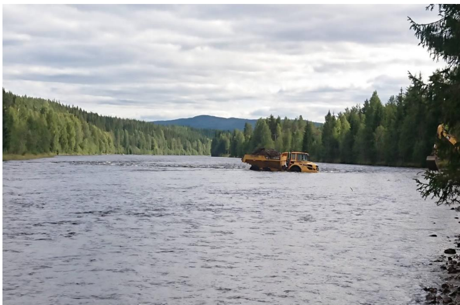
Figur 5. Dumper och grävmaskin i arbete med att lägga ut sten och block på en delsträcka uppströms Tåsans mynning.
