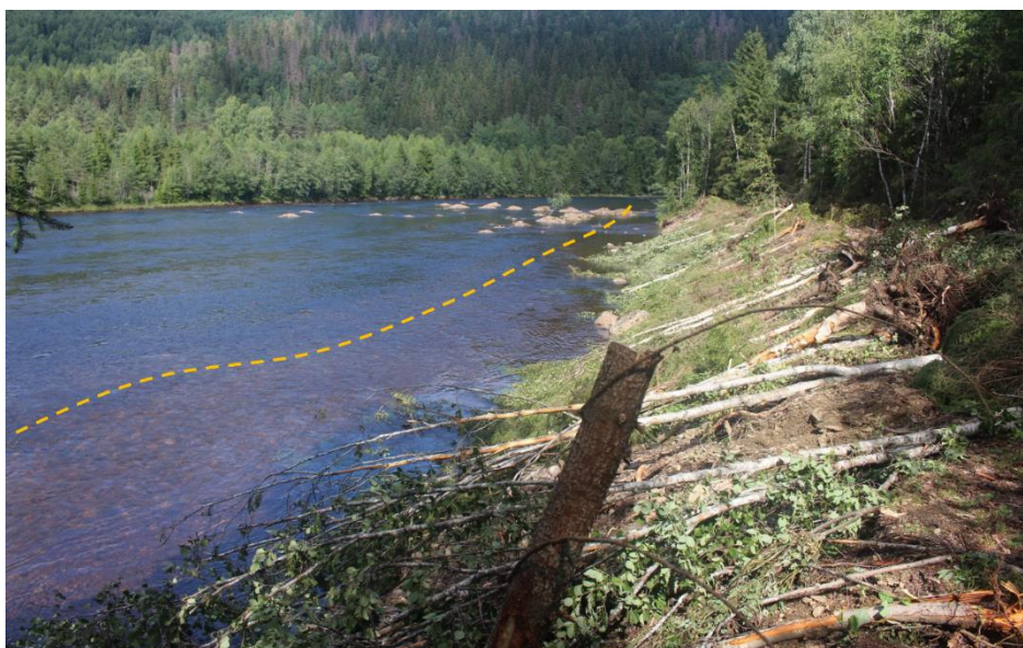
Figur 6. En bred och lång rensvall har här återförts till älven, vilket ökat älvbredden med ca 10 meter. Den tidigare strandkanten är markerad med gul streckad linje. Tillfört material skapade mer naturliga strömbilder samt mängder med skydd för småfisk. De små "öarna" med sten som syns i bakgrunden kommer från vallen och spreds senare ut över hela älvbredden. De liggande träden kommer bidra till viktiga övergångsmiljöer mellan vatten och land.
