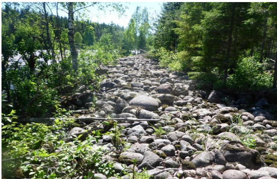
Figur 2. Här syns resultatet av arbetet i figur 1: En typisk schaktvall bestående av block, sten och grus.
