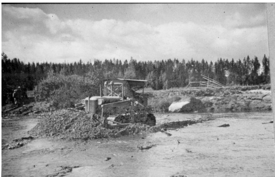
Figur 1. Bulldozer i färd med att schakta upp sten och grus.
