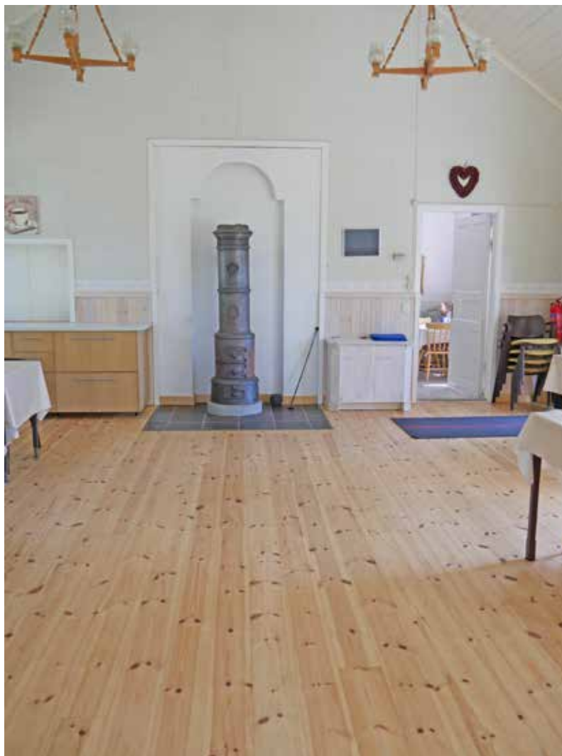
Golvet i stora salen renoverades 2015, på grund av att det blivit angripet av trämask.
