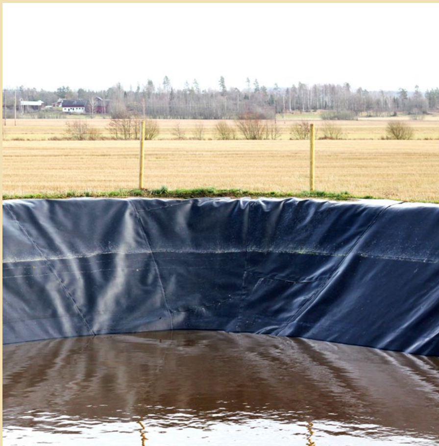
I satellitbrunnen kan gödseln mellanlagras vilket underlättar gödselspridningen. Foto: Teresia Borgman
