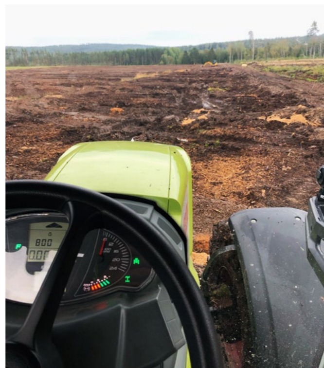
Arbetet pågår, här är stubbfräsningen klar. Foto: Erik Forsberg
