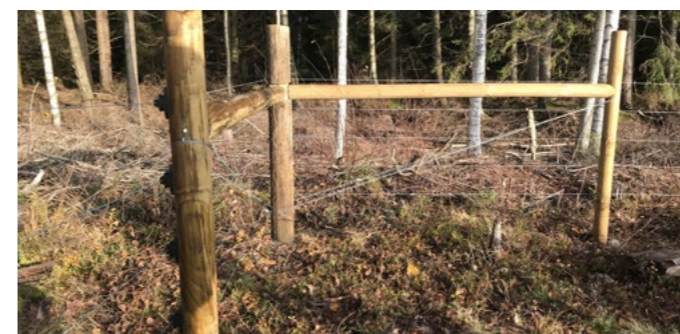
För att få ett bra stängsel är stabila hörn något av det viktigaste eftersom det övriga stängslet spänns upp mot hörnstolparna. Om markens form är ojämn kan det också behövas grövre stolpar i vinklar och svängar. Det är också viktigt att ha en eltråd överst. Exempelvis kan en stöttande plank som sitter ovanför eltråden användas som språngbräda för rovdjur.
