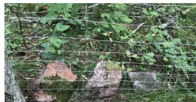
Det här stängslet sitter i ojämn terräng med många små svackor som gör att fjärnätet inte kan sluta tätt mot marken. Stenar har därför lagts på utsidan för att förhindra varg från att gräva sig in i hagen. Nätet har låsta knutar och om maskorna är högst 15 cm höga räcker det att komplettera med eltråd/eltrådar ovanför. Är maskorna större behövs även en eltråd max 30 cm ovanför marken.
