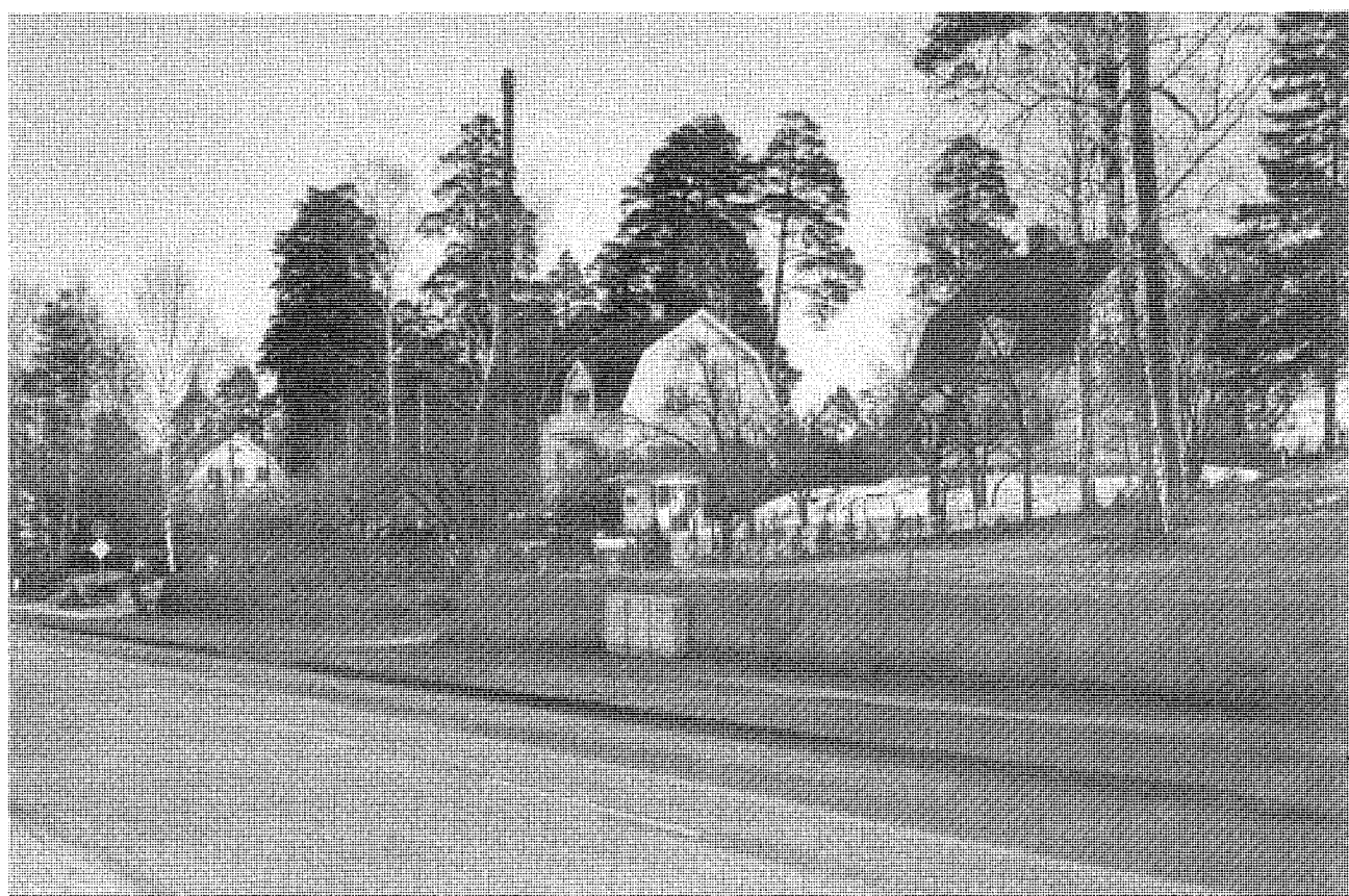
1920-talsvillor vid Sollentuna- vägen (närmiljö 24:1)
