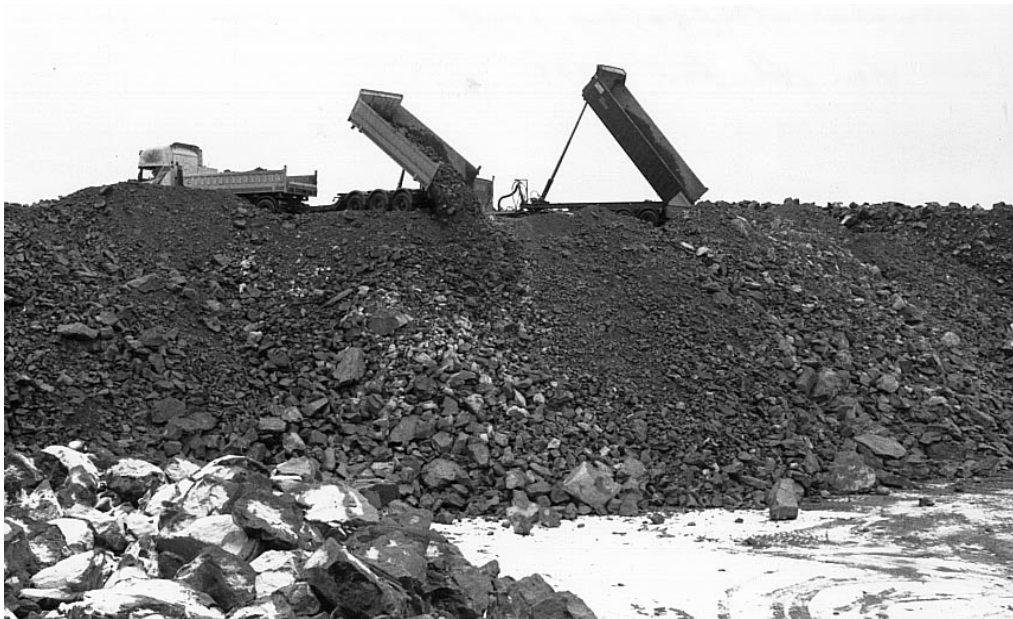
Mellanlagring av bergmassor från utbyggnaden av Södra Länken. Skrubba, Stockholms Stad. Foto: Lars Åkerblad.
