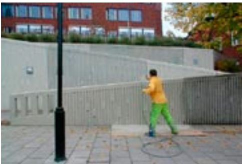
Exempel på hur upprustning av rekordårens bebyggelse kan ske på varsamt sätt: I Bredängs centrum ledde samarbete mellan de boende och antikvarier vid Stockholms stadsmuseum till att den hårt smutsade betongen målades i en grå kulör som efterliknade den ursprungliga ytan. På bilden målas provytor för att fastställa rätt kulör, SAK.
