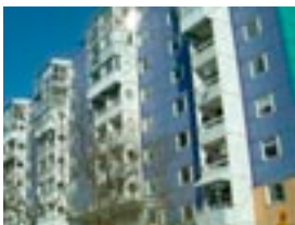
I Husby, uppfört kring mitten på 1970-talet, färgades fasadelementen in i starka färger, SAK.
