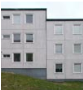
Elementbyggda hus i Tensta uppförda i skarnesystemet, SAK.
