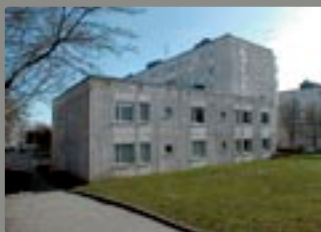
Bostadsbebyggelse i Tensta uppfört av Ohlsson och Skarne och ritat av György Korodi. Byggnadsfirman eget elementsystem S66, med sin typiska kvadrerade yta ger karaktär åt bebyggelsen.
