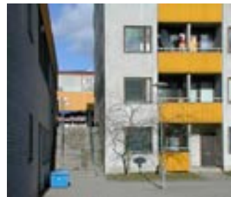
I Hjulsta centrum, uppfört 1971-75, har en stark gul accentfärg använts för att tydligt skilja ut centrum från den övriga bebyggelsen, SAK.
