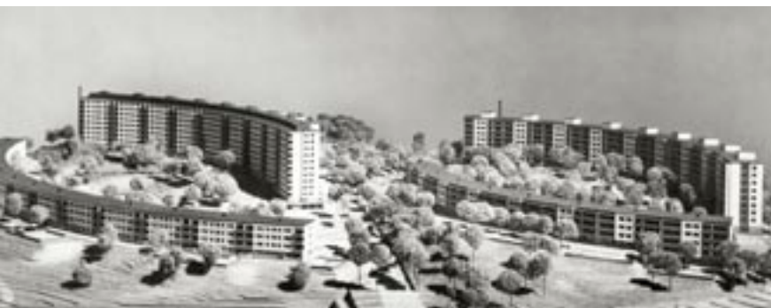
Även Kallhäll i Järfälla är ett exempel där byggnaderna används som skulpturer i landskapet. Platzers bildarkiv, Stockholms läns museum.
