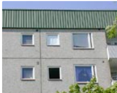
Under rekordåren blev motfallstaken vanliga. De kan kännas igen på de karaktäristiska, plåtinklädda takstegarna. Tensta, SAK.
