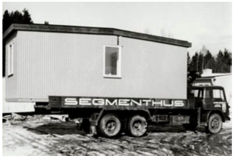
Under rekordåren kunde segment av hela byggnader förtillverkas industriellt. Byggnadsdelarna monterades sedan enkelt ihop på plats. Platzers bildarkiv, Stockholms läns museum.
