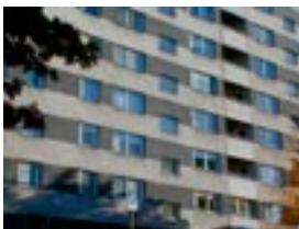
Fasad i Bredäng utförd i ädelputs i två nyanser, SAK.
