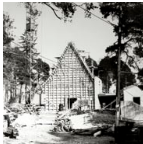
Östertälje kyrka, ritad av Rolf Bergh, under uppförande i början av 1960-talet. Kyrkan är en av sex som byggdes i Södertälje kommun under rekordåren. Bild: Göran Gelotte.
