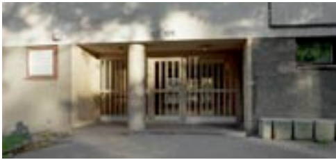
Genomgående entréer med utgång på byggnadens båda sidor blev vanliga under rekordåren. Ofta var portarna, som i denna byggnad i Bredäng, indragna i fasaden, SAK.
