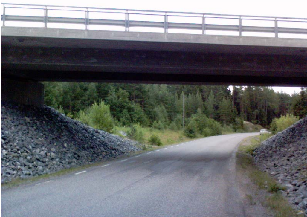
Figur 1 - Undergången under E18 mellan Ledinge och Rösa i Norrtälje kommun. Ett exempel på område som borde kunna fungera utmärkt som viltport för lodjur att ta sig mellan bägge sidor av motorvägen som annars har relativt hög trafik och är kantad av viltstängsel. Notera att det i dagsläget inte finns några bekräftade uppgifter om lodjur här. Foto: Andreas Zetterberg.
