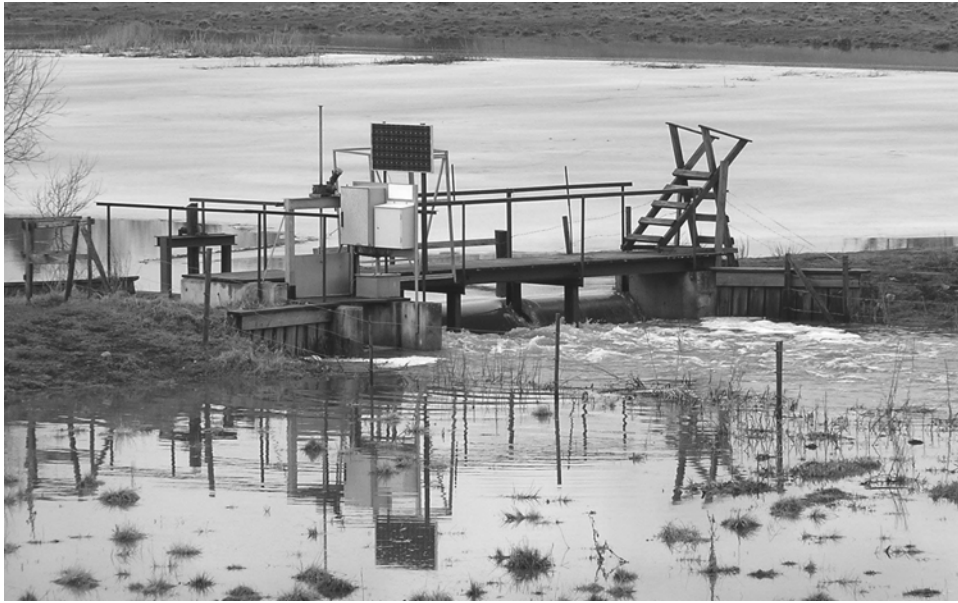
Figur 14. Dämet vid utloppet utformades med rörlig dammlucka (t.v. i bild) samt träsättar i överfallsdelen (t.h.). Det finns också utrustning för manövrering av dammluckan via telefon (därav solfångare för elförsörjningen). Detta har dock inte gjorts färdigt, utan anordningen manövreras fortfarande manuellt. Foto: H-G Wallentinus maj 2004.
