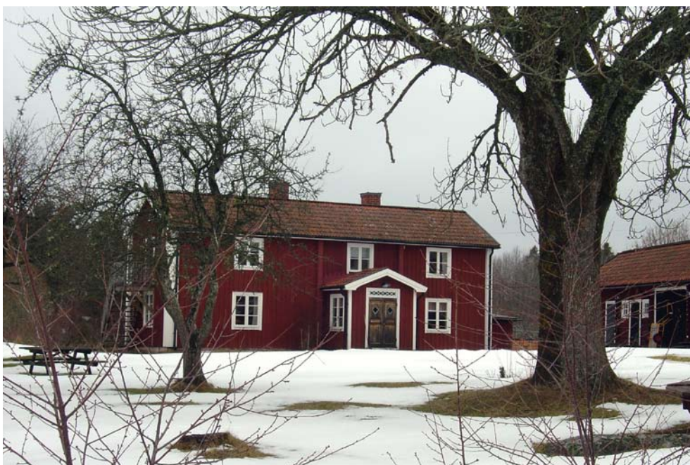
Mangårdsbyggnad och uthuslänga på Bull-Augusts på Arholma. De långa uthus- eller ladugårdslängorna är karakteristiska för redargårdarna. Förmodligen var den en statussymbol liksom huvudbyggnadens två våningar. Foto: Hanna Gårdstedt, Länsstyrelsen.
