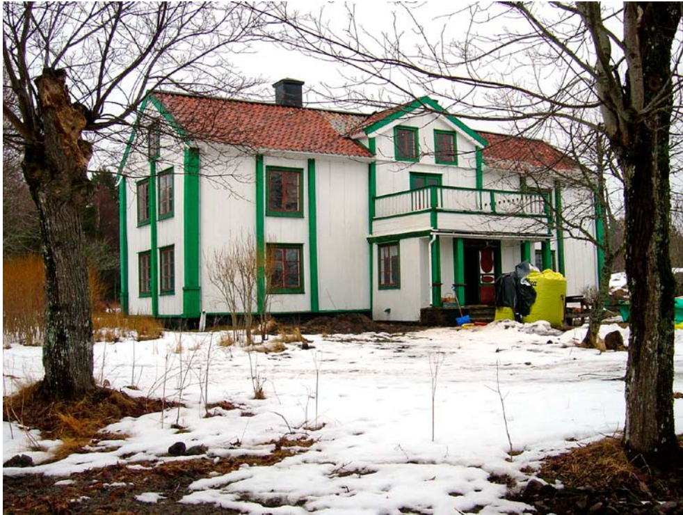
Mangårdsbyggnad och ladugårdslänga, Simpnäs redargård på Björkö. Här inreddes ursprungligen endast delar av mangårdsbyggnaden övervåning när husets uppfördes på 1830-talet. Foto: Hanna Gårdstedt, Länsstyrelsen.
