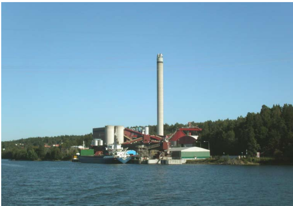
Bild 5: Värmekraftverket Igelstaverket, Södertälje.
